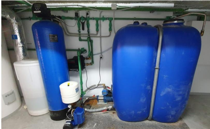
*Ilustración 14. Sistema de descalcificación*
