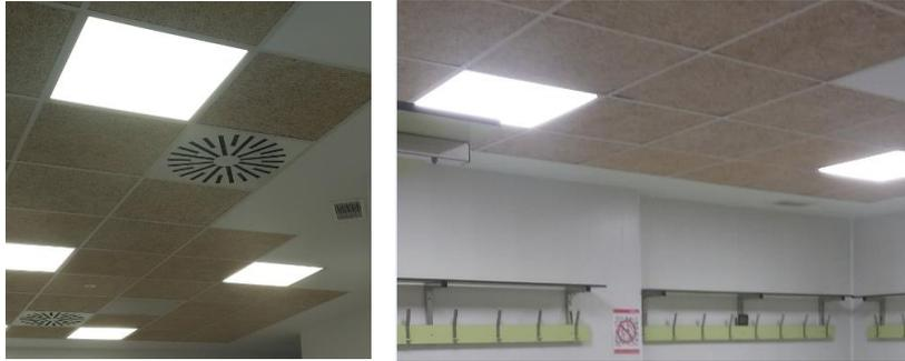
*Ilustración 16. Luminarias - Tipo Paneles LED*
