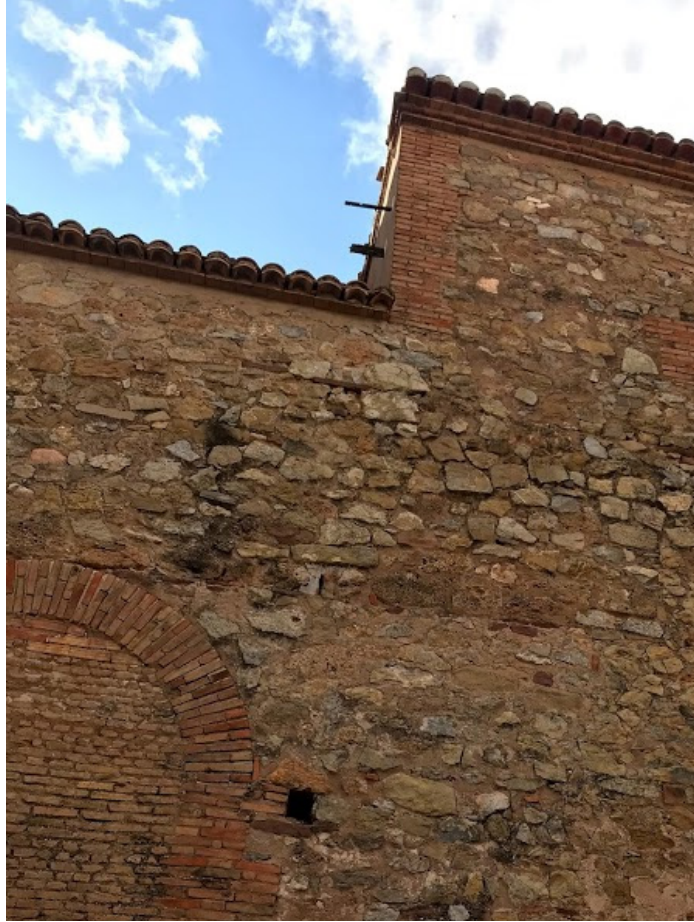
Fig.17. Fachada Trasera. Fuente: Elaboración Propia
