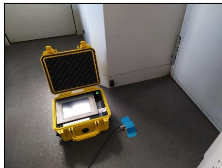
Gráfica 15. Instalación de sensores en el piso de la cabina.
