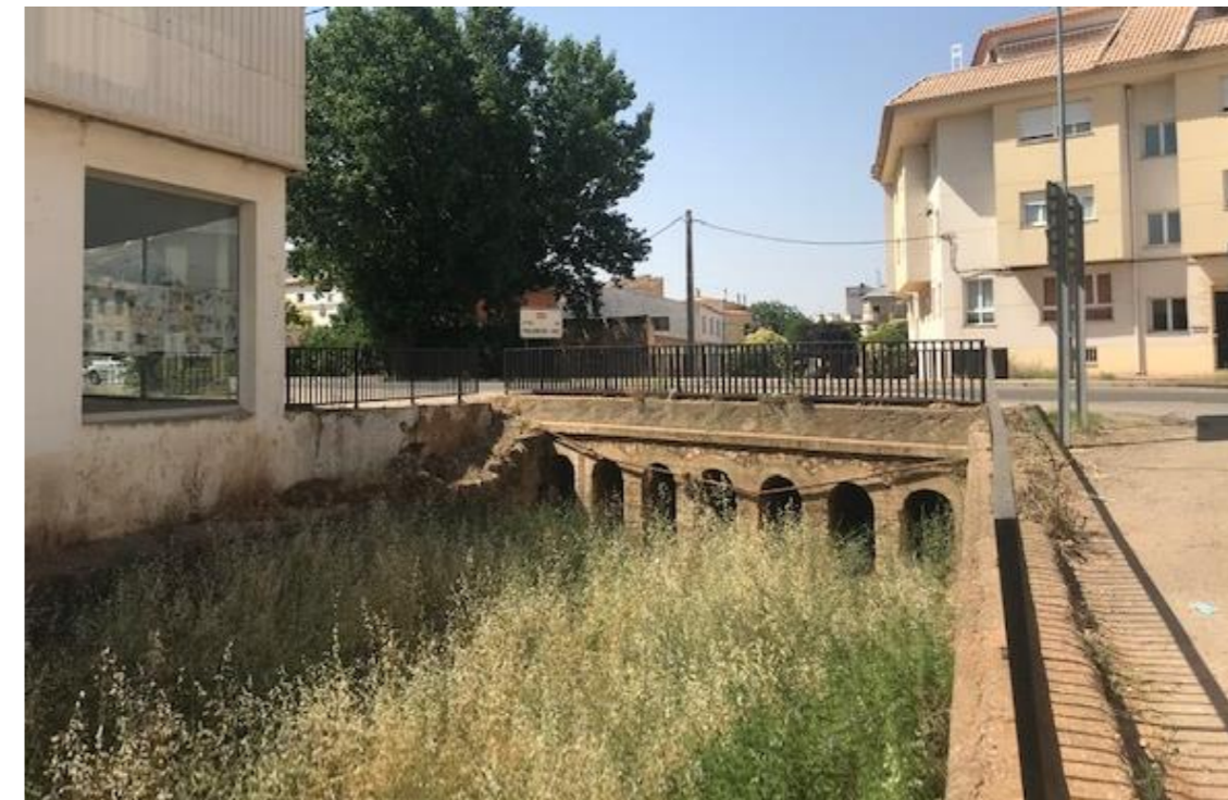
Ilustración 8 – Zona embocadura (7 puentecillos y N-III). Fuente: Propia.
