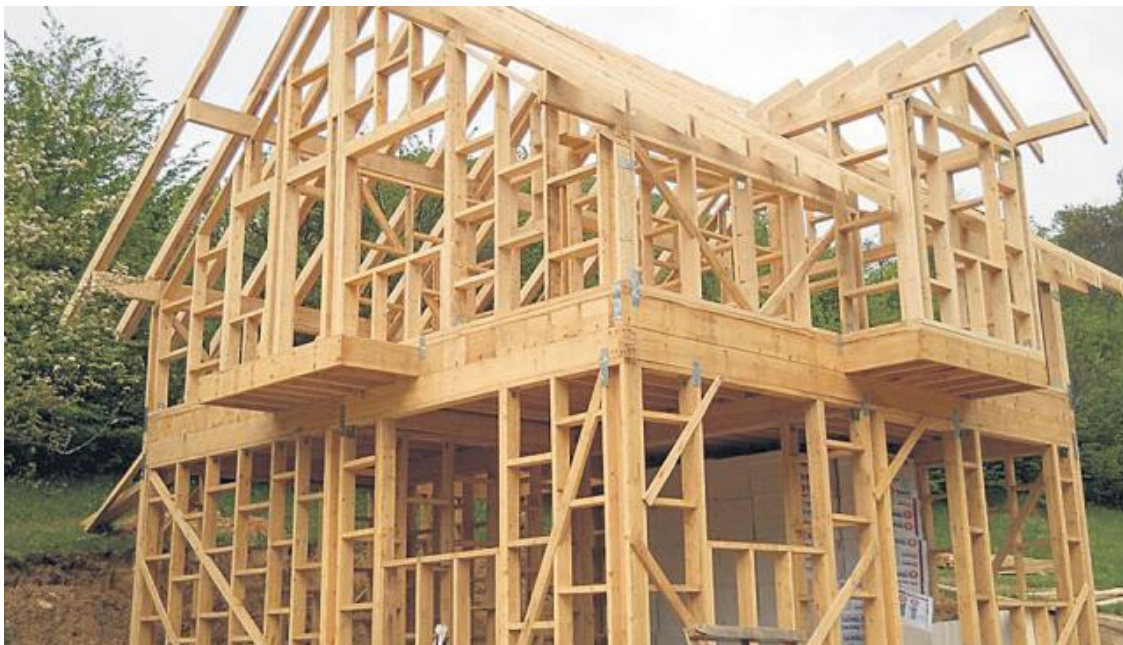
Figura 10. Vivienda unifamiliar ejecutada con sistema Platform Frame (Madera y construcción, 2015)
