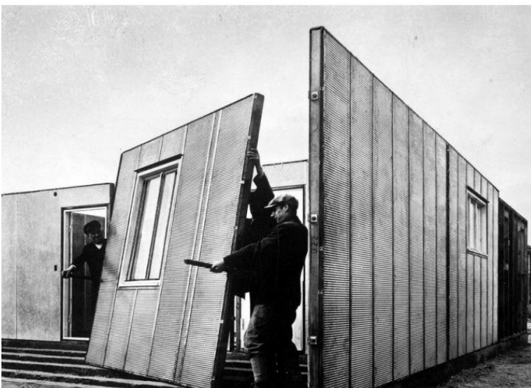
Figura 30. Montaje de paneles de la Casa de Cobre, Casas que crecen, en Berlín (Gropius, 1931)
