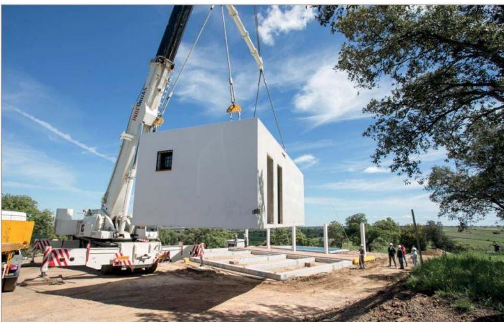
Figura 50. Módulo habitacional con 6 caras envolventes. Sale de fábrica totalmente terminado, quedando únicamente en obra la cimentación y las redes de servicios. (Worldmeter, 2017)
