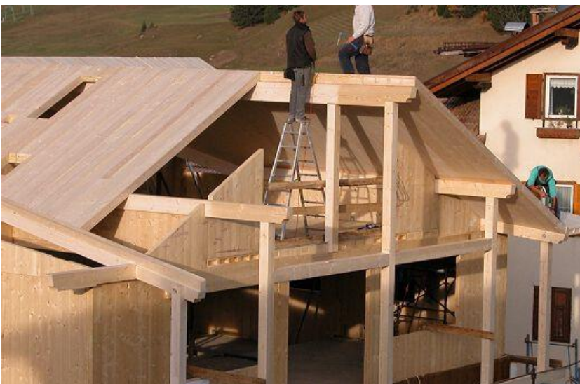
Figura 34. Vivienda ejecutada con paneles y placas de madera mediante el sistema Lignatur. (Lignatur, 2005)
