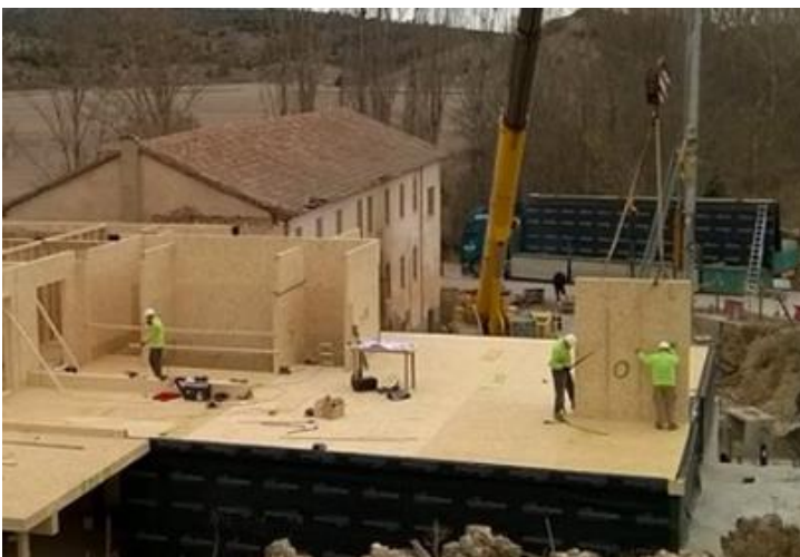
Figura 17. Colocación de un entramado con panel incorporado en obra mediante una grúa. El traslado se hace directamente desde el camión, sin necesidad de descargarlo previamente (Arquima, 2018)
