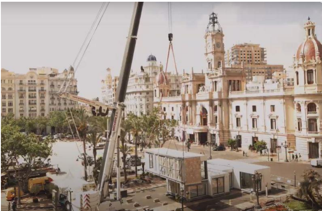
Figura 54. Vivienda Inhaus para Open House Valencia. Ensamble de una vivienda modular en la Plaza del Ayuntamiento de Valencia. Se puede ver el interior de una de las fachadas. (Inhaus, 2019)
