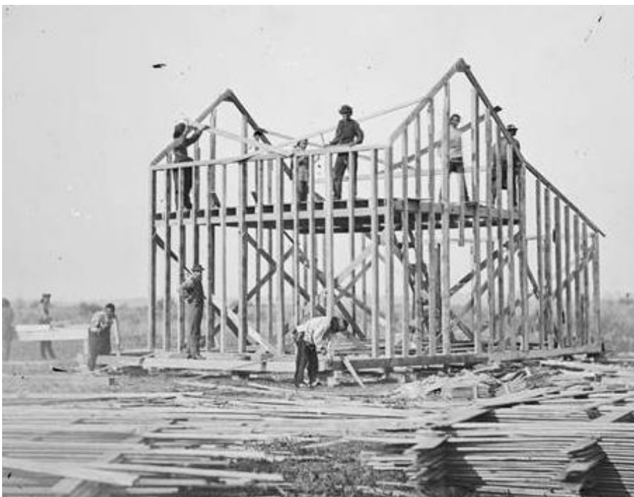
Figura 6. Hombres trabajando en la vivienda con Balloon Frame en Nebraska (1877)
