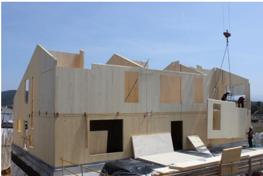
Figura 36. Construcción mediante paneles CLT (EstudioK, 2013)
