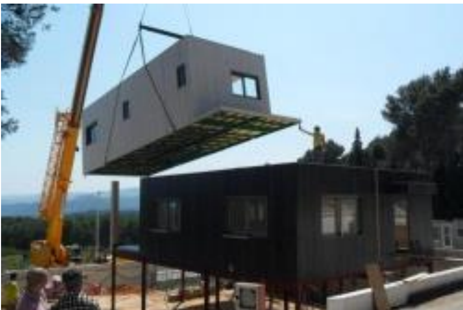
Figura 52. Colocación del módulo de la tercera planta de una vivienda unifamiliar. (CasasNatura, 2019)
