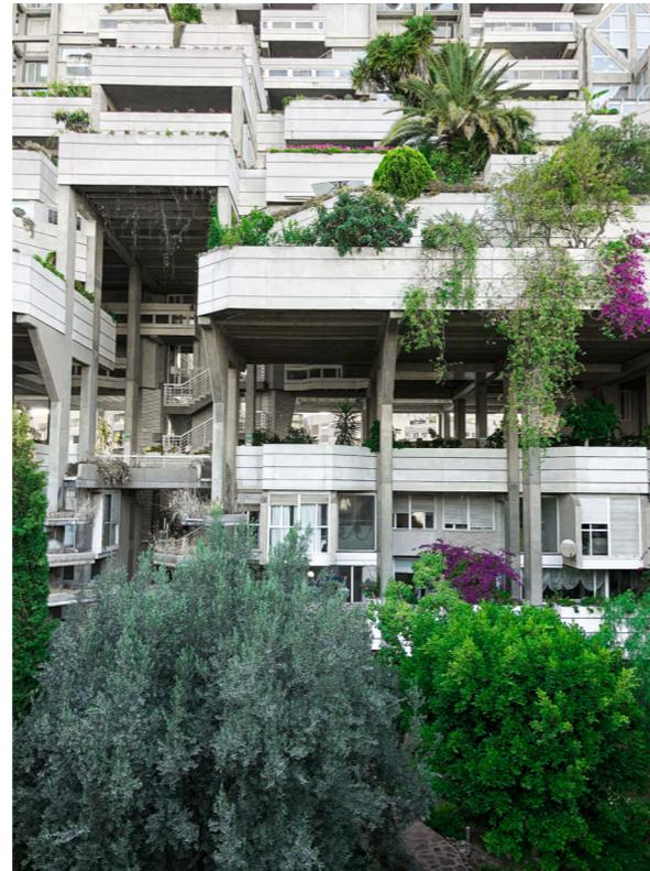
Figura 88. Revestimiento de placas blancas de poliéster con fibra de vidrio (fases 1 y 2)
