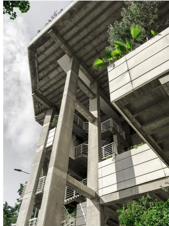
Figura 27. Combinación de elementos *in situ* y prefabricados en estructura
