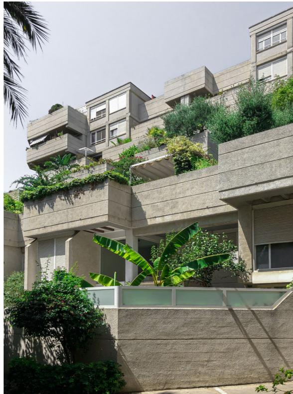
Figura 87. Revestimiento de enfoscado de mortero blanco con piedra de mármol royectado (fase 4)
