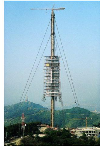
*Ilustración 34 Proceso constructivo de la Torre de Collserola.*
