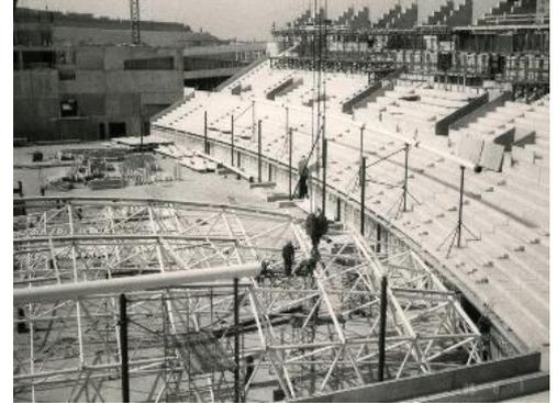
*Ilustración 38 Palcos y construcción de la cubierta principal.*
