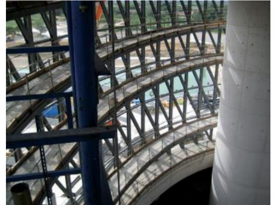
*Ilustración 50 Tramos inferiores de la estructura de la fachada.*
