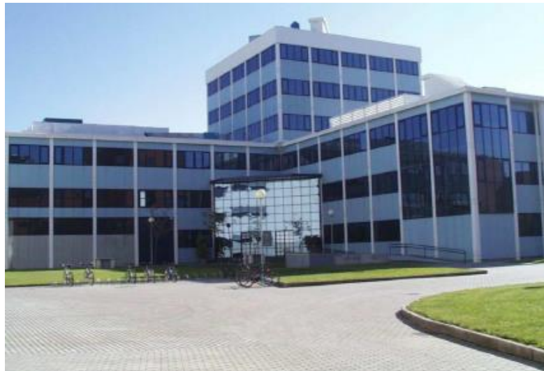
Fig. 1.1 Imagen exterior del edificio del CMT
