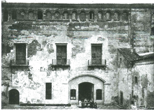
La façana de llevant, adjacent al pati, de la primera navada del Palau, abans de la restauració. Tàpies i tàpies. Foto extreta de la Monografia del 1904.
