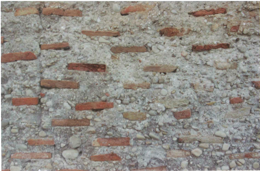
Parament extern de la fàbrica de tàpia mixta de l'ermita de Sant Vicent de Benieto. Foto J. A. G.
