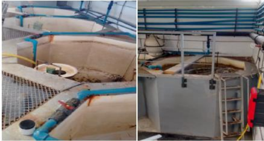
Figura 4. Detalle de los tanques octogonales de la línea 1 del LAC.
