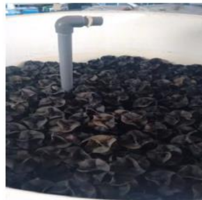
Figura 7. Detalle del interior del biofiltro.
