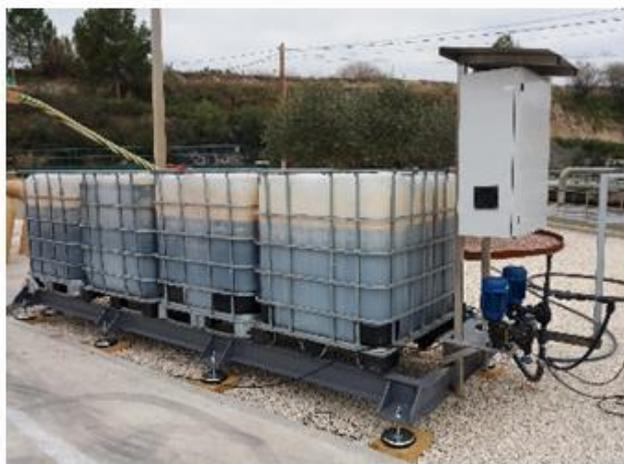
Figura 12. Sistema de dosificación EDAR Ontinyent-Agullent.
