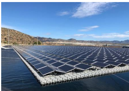
Figura 17. Instalaciones fotovoltaicas flotantes en España
