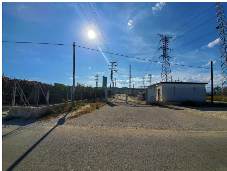
Figura 2.1: Subestación de Oliva
