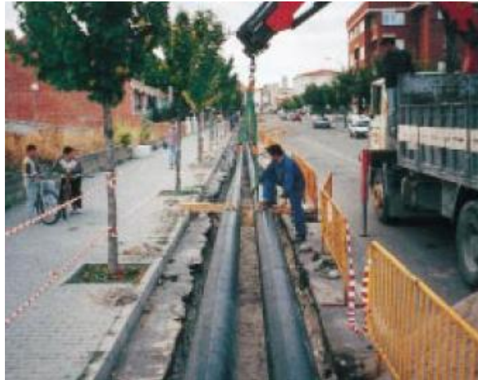
Figura 5: Instalación de la red de distrito de Cuéllar, Segovia. (IDAE, 1999)
