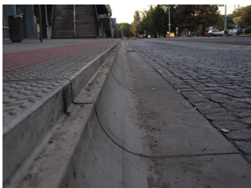
Ilustración 32: Bordillo tipo Kassel, permite al vehículo acercarse lo máximo a la parada evitando choques gracias a su curvatura
