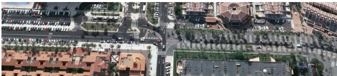
Ilustración 29: Avenida Rafael Puig Lluvina, en la zona derecha ya intervenida, y en la zona izquierda con la estructura anterior. Se observa la recuperación de espacios para peatones y la eliminación de plazas de aparcamientos.
