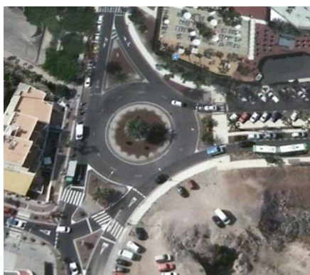
Ilustración 57: Rotonda en los tramos de más tráfico, el tránsito del BRT será por el centro de esta con prioridad semafórica.
