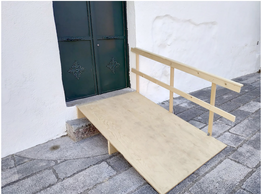
Fig. 38: Casa delle Agriculture (2019). Rampa de acceso a la Iglesia de Santa María Magdalena, Castiglione d'Otranto (Italia). Elaboración propia.
