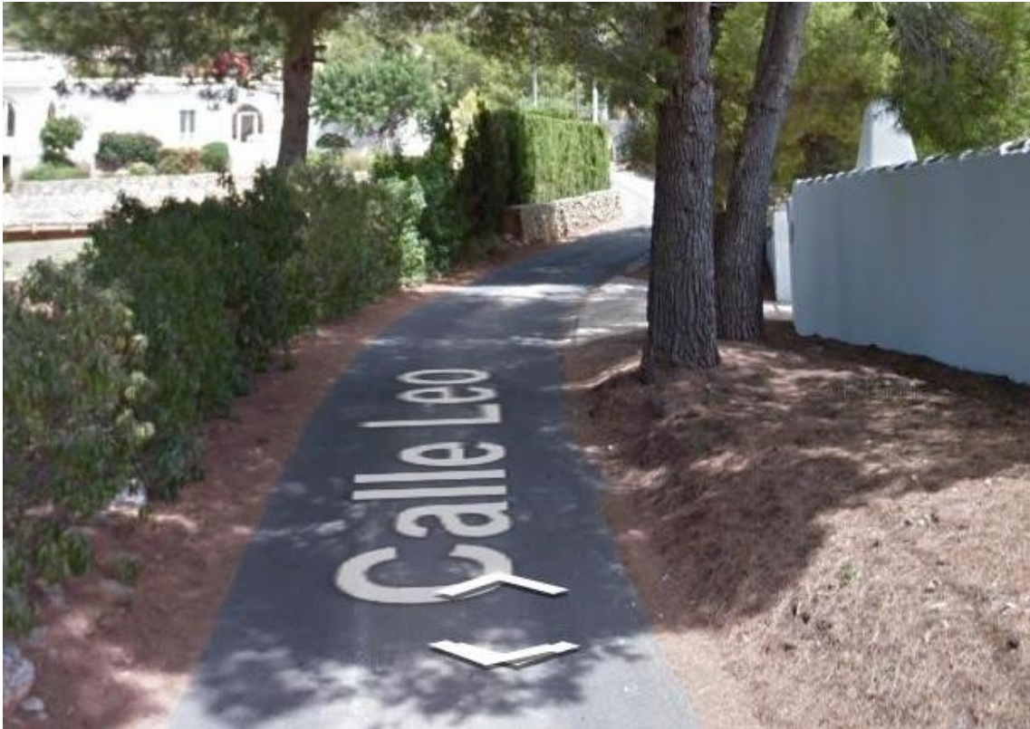
Figura 16. Estado de riesgo por acumulación de acículas de pino y anchura de 3,5 metros más cubierta de copa de los pinos. Elaboración propia.
