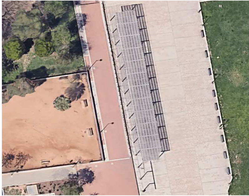
Figura 52. Pérgola instalada en el parque de ayora (40m x 4.5m x 4m). (Google Earth).
