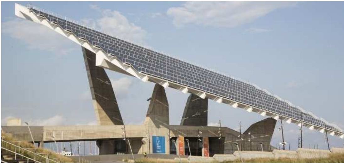
Figura 47. Pérgola del Fòrum construida en 2004 de 550kWp (Ayuntamiento de Barcelona, s. f)
