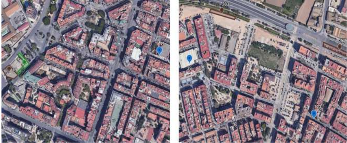
Figura 33. Mercados de Algirós y Torrefiel junto a las pérgolas fotovoltaicas propuestas para cada mercado. Imágenes obtenidas con Google Earth.
