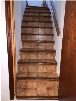
Figura 32: Escalera. Año 2020. Fuente propia
