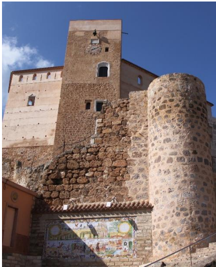
Figura 22: Torre del Homenaje. Año 2020. Fuente propia
