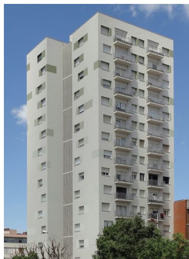
Viviendas Narcís Monturiol, Hospitalet de Llobregat, ES Arquitectura Tècnica - Torre de la Creu Foto: Karolina Moon Photography
