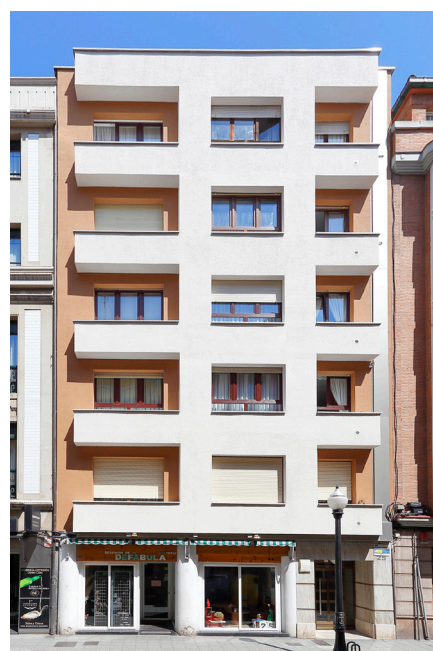
Viviendas Marqués de Casa Valdés, Gijón ES Foto: Construcciones Fercavia S.A.
