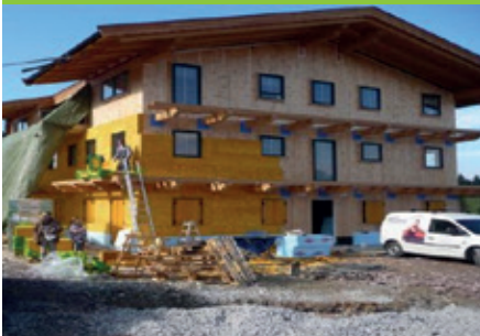
Vivienda unifamiliar de consumo casi nulo
