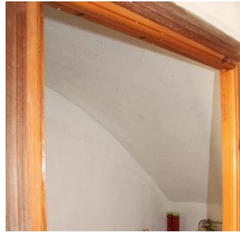
Figura 33: Zanca de la escalera. Año 2020. Fuente propia
