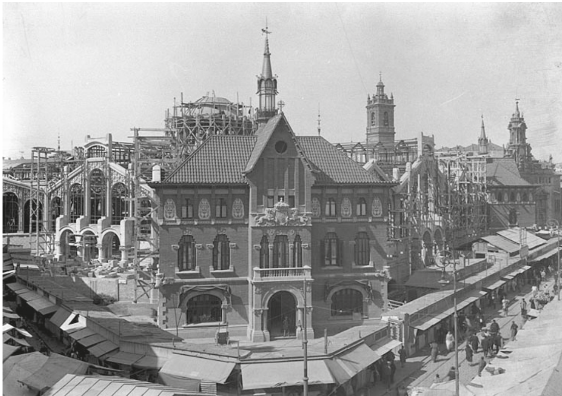
Fig. 4.38. Mercado Central en construcción. 1926.
