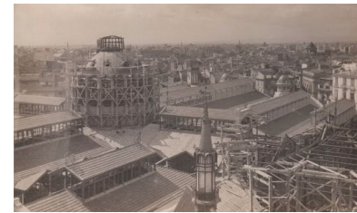
Fig. 4.40. Mercado Central en construcción.
