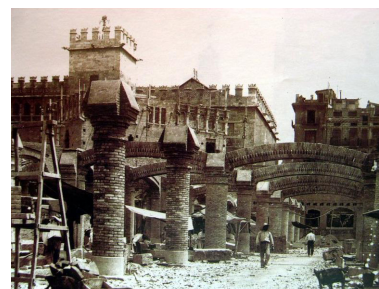
Fig. 4.36. Ejecución del sótano.
