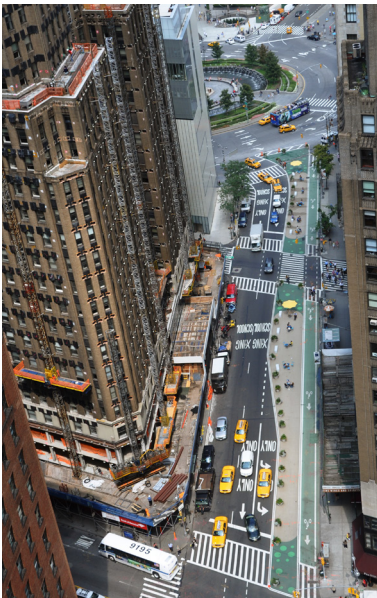
Fig.3.17 y 3.18. Columbus Circle antes y después de la actuación.
