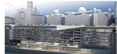
Fig. 4.52. Aparcamiento y estación de metro "Mercat" construidas bajo la Plaza Ciudad de Brujas.
