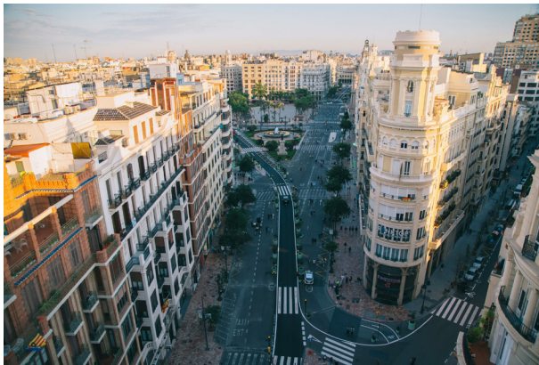
Fig. 4.84. Plaza del Ayuntamiento tras las obras de la primera fase de peatonalización. Mayo de 2020.
