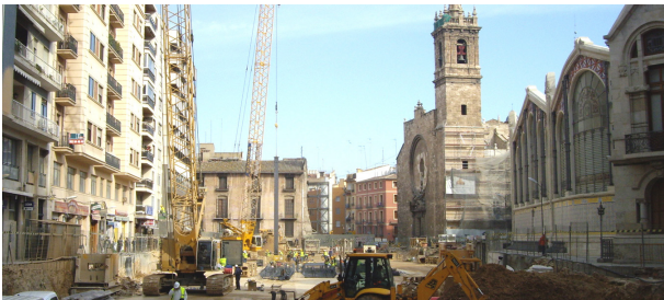
Fig. 4.47. La plaza durante las obras en 2009.
