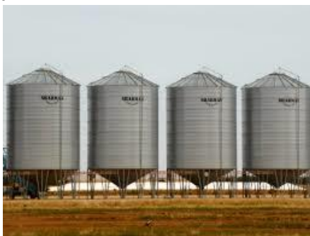
Figura 3-5 Silos de trigo.
