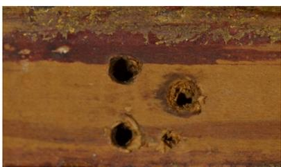
Fig. 36. Detalle de orificios en el reverso del marco.
