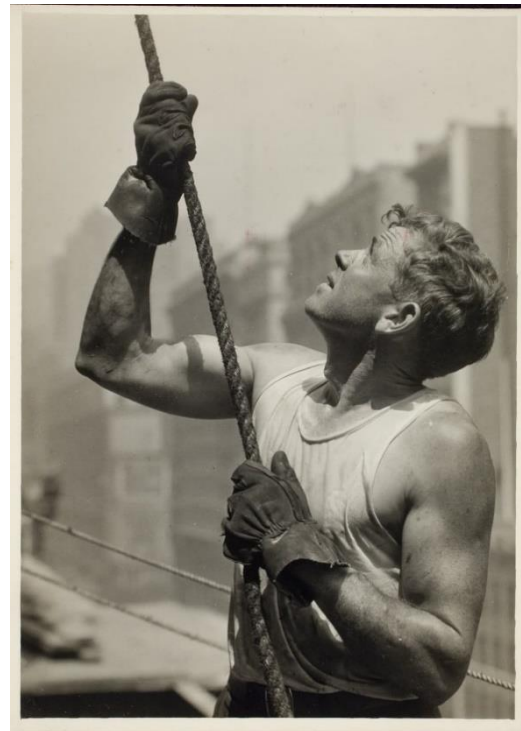
Fig. 3. Guiando una viga, ca. , Lewis W. Hine, 1931.
