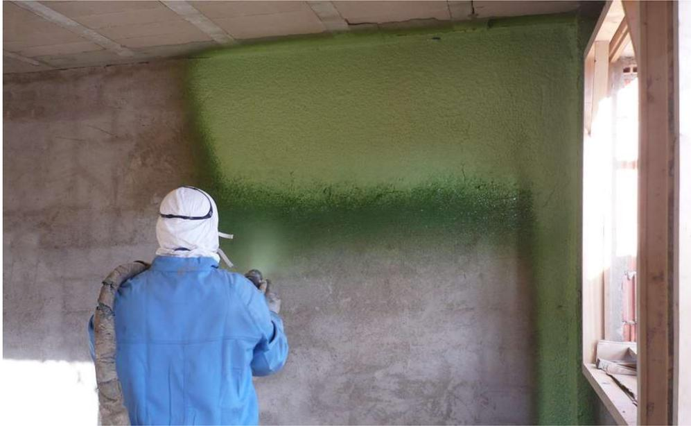
Figura 11. Aplicación de espuma de poliuretano a base de AS en una pared (Grupo Aismar, 2020).
