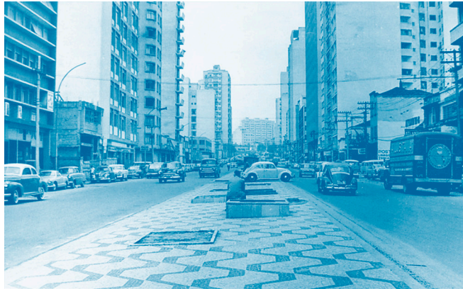
Fig. 32 Fotografía de la calle Amaral Gurgel antes de la construcción del Minhocão en 1966. La calle es parte del Plano de Avenidas ejecutado en la década de 60 por la dictadura militar, su papel consiste en conectar la radial este desde la plaza Roosevelt hasta la Avenida Duque de Caxias, formando la segunda perimetral alrededor del Valle del Anhangabaú.
