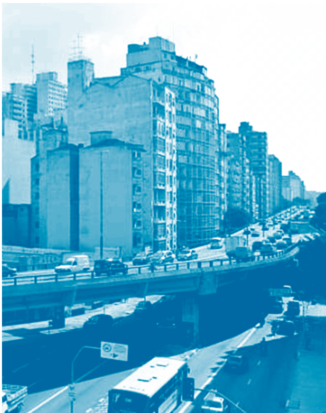
Fig. 44 Fotografía lateral que permite ver la barrera formada por la estructura del elevado. Esa condición también ha generado un vacío en la parte de abajo.
