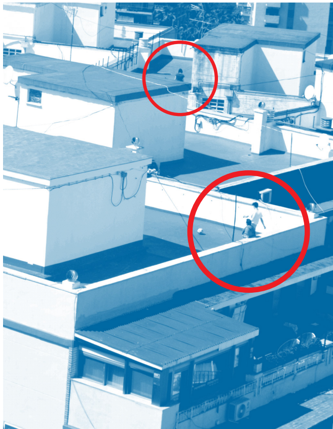
Fig. 111 La terraza aquí se transforma en una pista de fútbol.
