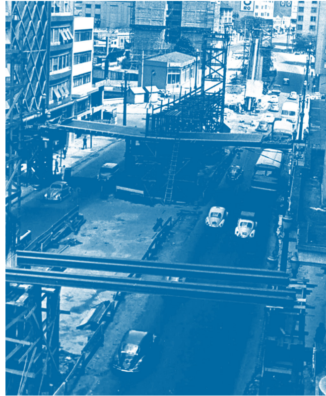
Fig. 37 Fotografía de la construcción del elevado en 1969 sobre el tramo de la Avenida São João. En el retrato se puede ver la desorganización de la obra dividiendo espacio con el flujo de coches de la avenida.
