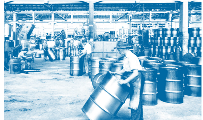
Fig. 90 Imagen de la fábrica de barriles Mauser & Cia. Ltda en la década de 50. Toda la estructura presente en la imagen fue mantenida en el proyecto.
