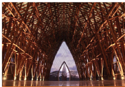
El sistema constructivo utilizado en la iglesia, se puede definir como un sistema de tipo puntal simple, cuyo material principal es la guadua, en su construcción no se utilizó ningún otro de madera.
