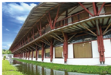
El edificio tiene una longitud de 87.00 metros de largo y una longitud de 16.00m de ancho. Vélez adopta la simetría como base principal de diseño para el edificio. A partir de la generación de un espacio central, el más importante [1].
