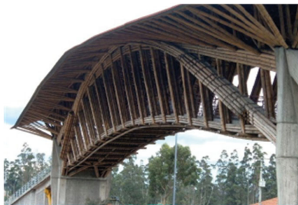
Se trata de un puente peatonal cubierto que está localizado a las afueras de la ciudad de Santa Fe de Bogotá capital colombiana, a la altura de la Calle 80, en la salida que de la capital conduce a la ciudad de Medellín [1].
