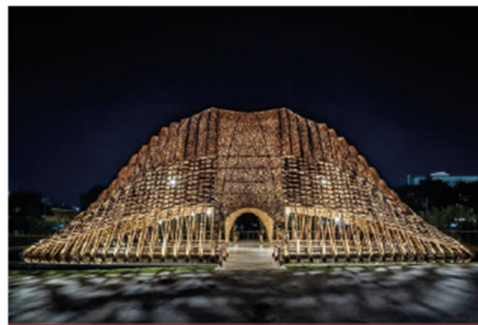
Se busca que el Bamboo Pavilion se vea como una semilla nacida desde la superficie del suelo, rodeado de agua en su interior y exterior [1].
