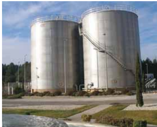
Figura 13: Detalle de depósitos de almacenamiento de aguas pluviales. Fuente: Elaboración propia.
