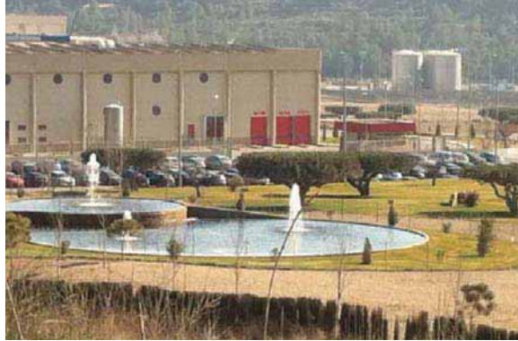
Figura 12: Detalle de lago artificial: misión mejora depuración, ornamental y aprovechamiento para riego. Fuente: Elaboración propia.
