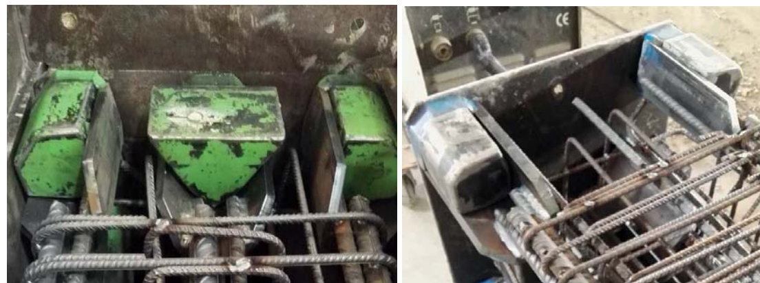
Cajas de instalación para fijación en tape molde. Diferencia geométrica entre cajas de esquina y centrales.
