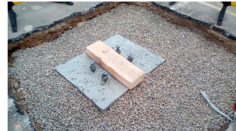
Figura 16. Hormigonado de Enano y relleno de excavación.
