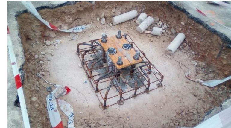
Figura 15. Armadura y vainas de Enano de cimentación.
