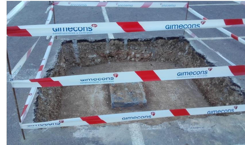
Figura 9. Excavación zapata aislada.
