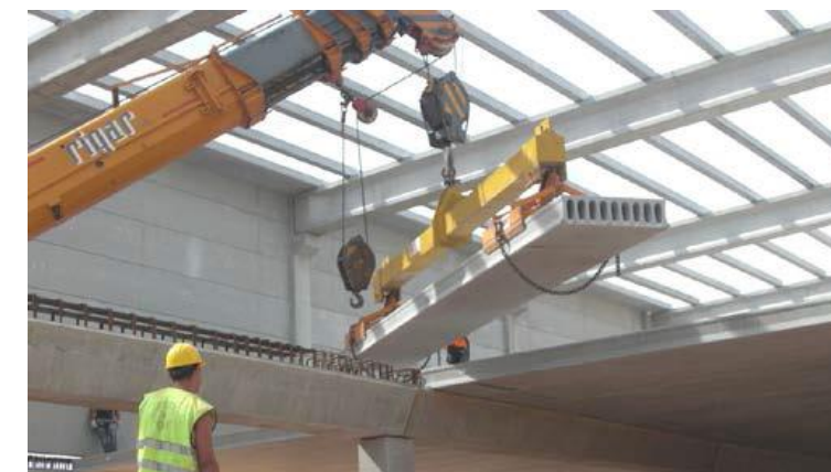
Figura 72. Pinzas especiales para manipulación de placas alveolares.
