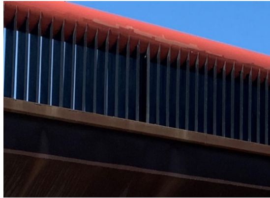
Imagen 9 Imposta y barandilla. (Fuente: elaboración propia)
