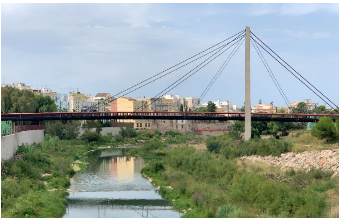
Imagen 5 Vista parcial del alzado de la pasarela. (Fuente: elaboración propia).
