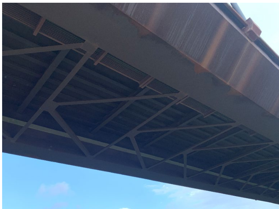
Imagen 7 Vista inferior del tablero. (Fuente: elaboración propia)
