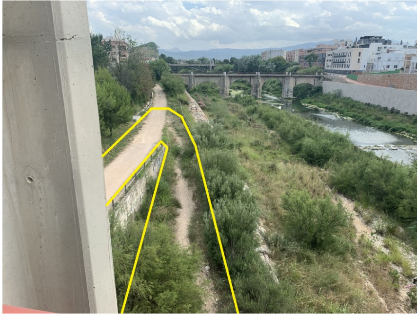
Imagen 82 Camino de acceso al cauce del río [1]. (Fuente: elaboración propia).
