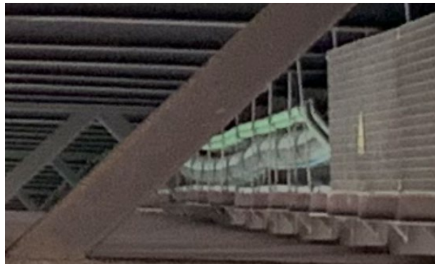
Imagen 10 Instalación de conductos y servicios bajo el tablero. (Fuente: elaboración propia)
