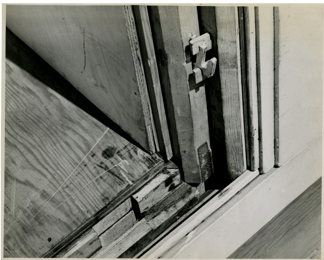
Figura 7. Packaged House System , 1942-1952. Fase de montaje: panel de piso, panel de partición y panel de pared exterior. Fotografía de Anna Wachsmann. Papel de gelatina de plata 20,1×24,9 cm.
