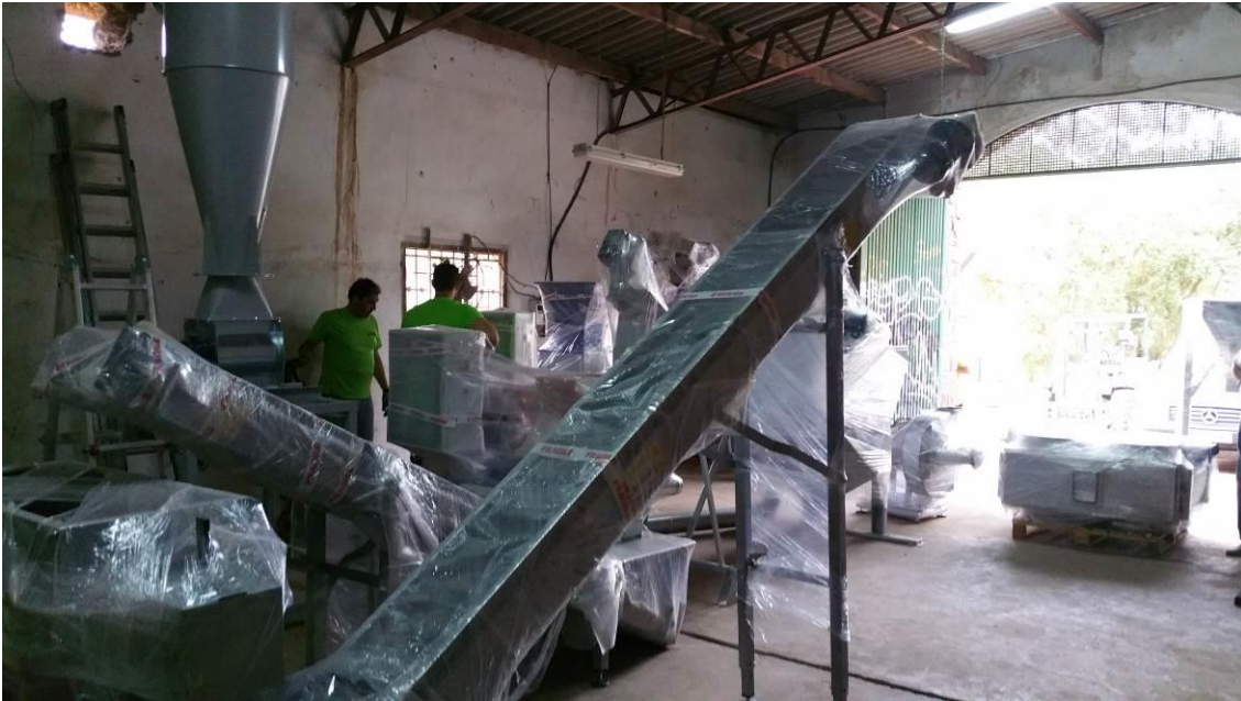
Fotografía 19. Descargas y montaje de la línea semi industrial de peletizado.
