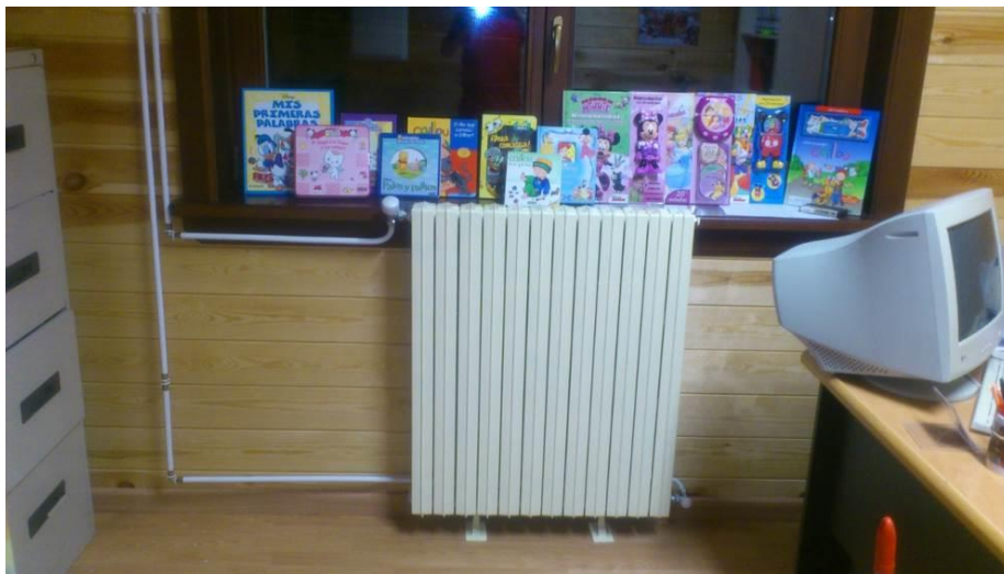
Fotografía 50. Instalación de radiadores y circuito de agua caliente en la Guardería municipal. Fuente: Elaboración propia
