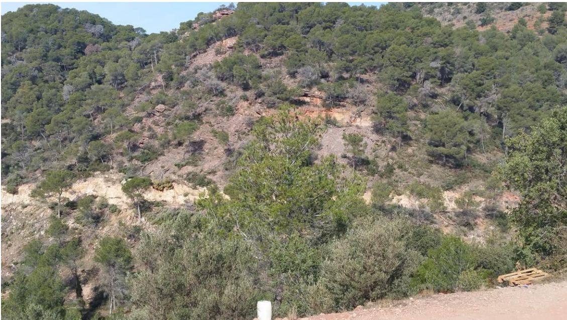
Fotografía 77 .Trabajos de ejecución del área cortafuegos camino Ombría Castell. Fuente: Elaboración propia.
