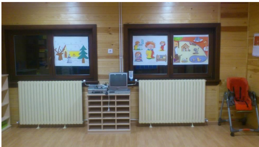
Fotografía 48. Instalación de radiadores y circuito de agua caliente en la Guardería municipal. Fuente: Elaboración propia
