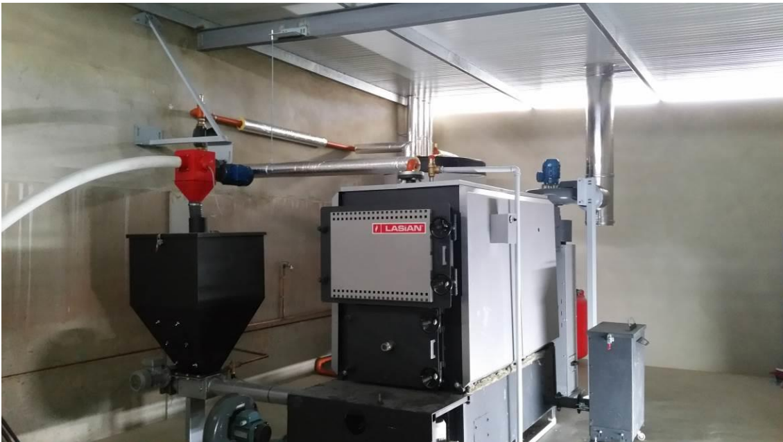
Fotografía 70. Instalación de la caldera del colegio público. Fuente: Elaboración propia
