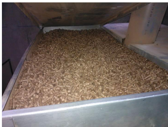
Fotografía 58. Silo de la caldera del ayuntamiento lleno de pélets..
