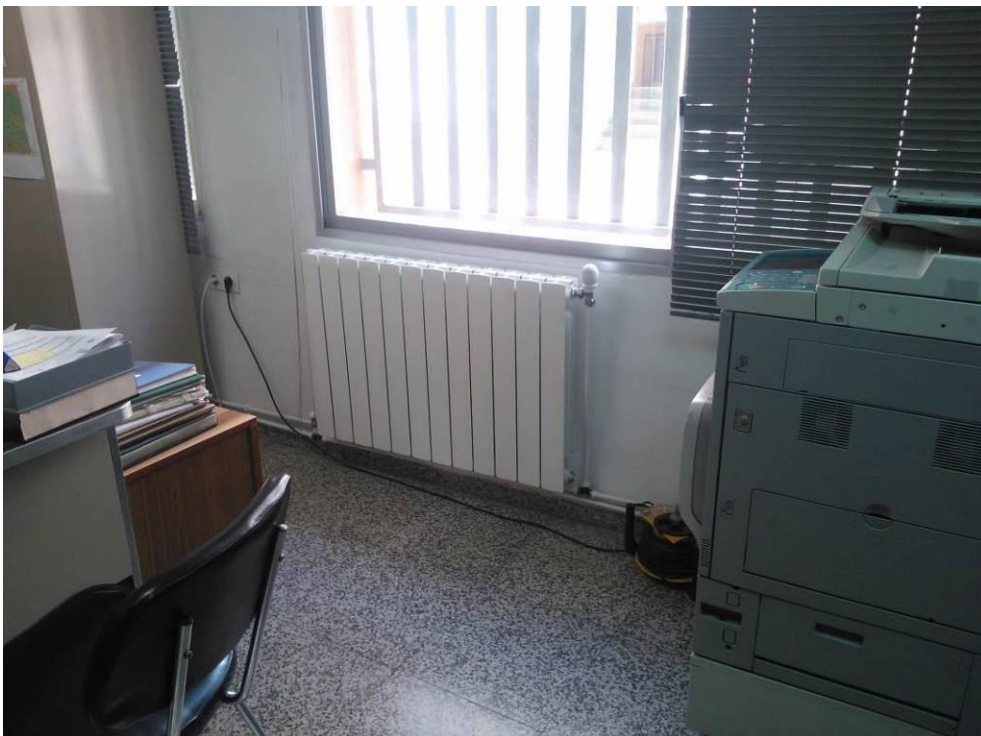
Fotografía 56. Instalación de radiadores del edificio consistorial, oficina técnica. Fuente: Elaboración propia
