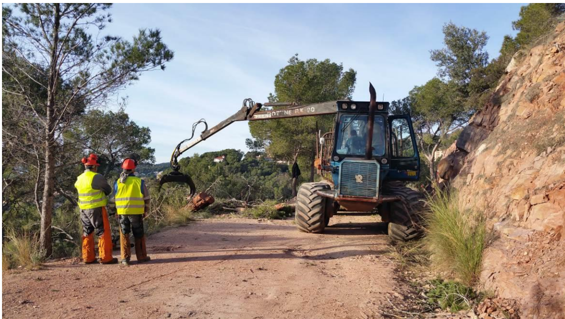
Fotografía 73 .Trabajos de ejecución del área cortafuegos camino Ombría Castell.
