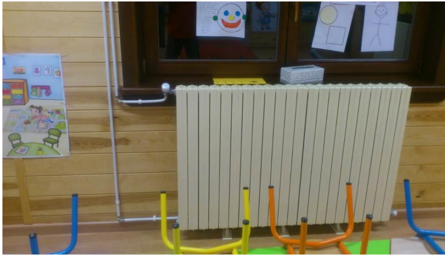
Fotografía 46. Instalación de radiadores y circuito de agua caliente en la Guardería municipal. Fuente: Elaboración propia
