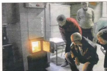
Visita a les calderes de biomassa de Serra.
