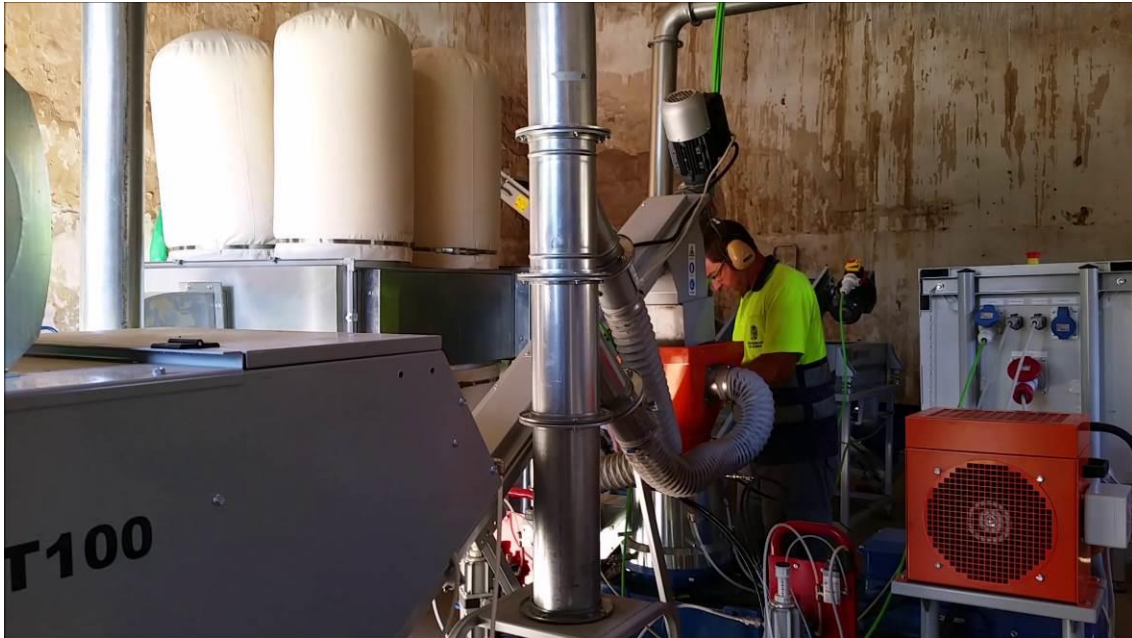
Fotografía 21. Puesta en marcha de la línea semi industrial de peletizado.
