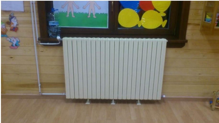
Fotografía 47. Instalación de radiadores y circuito de agua caliente en la Guardería municipal. Fuente: Elaboración propia
