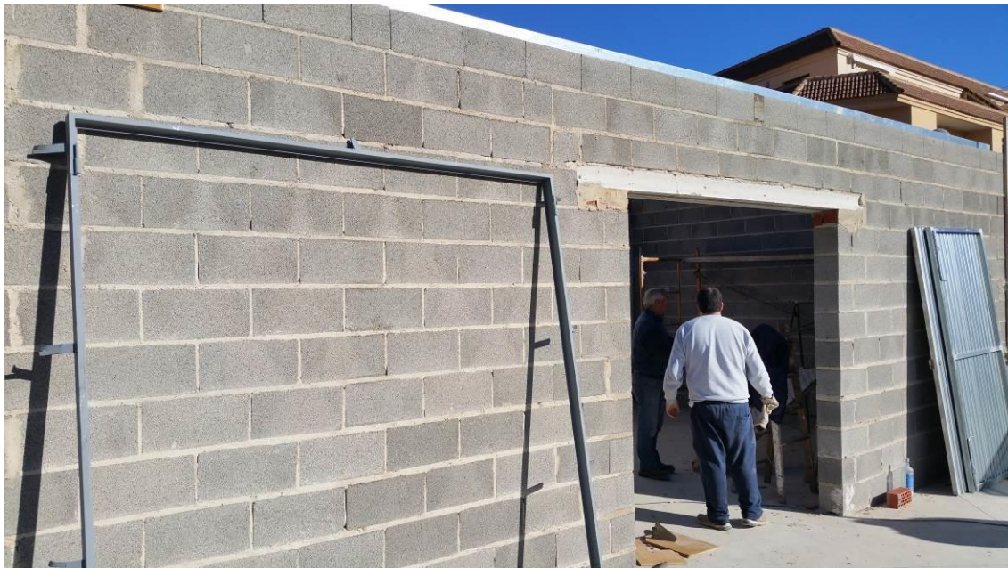
Fotografía 66. Construcción de la caseta que alojaría la caldera del colegio público.
