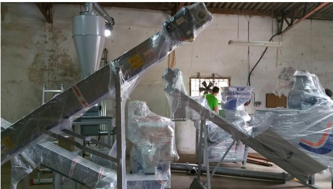
Fotografía 18. Descargas y montaje de la línea semi industrial de peletizado.
