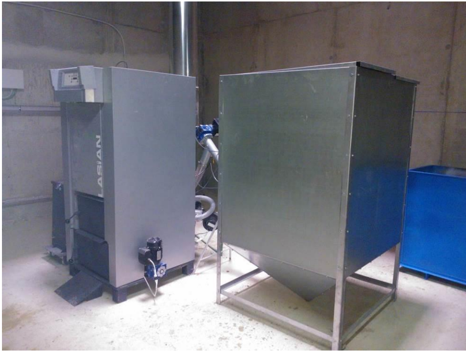
Fotografía 53. Caldera de biomasa poli combustible de 65 kW del edificio consistorial, parte frontal Fuente: Elaboración propia
