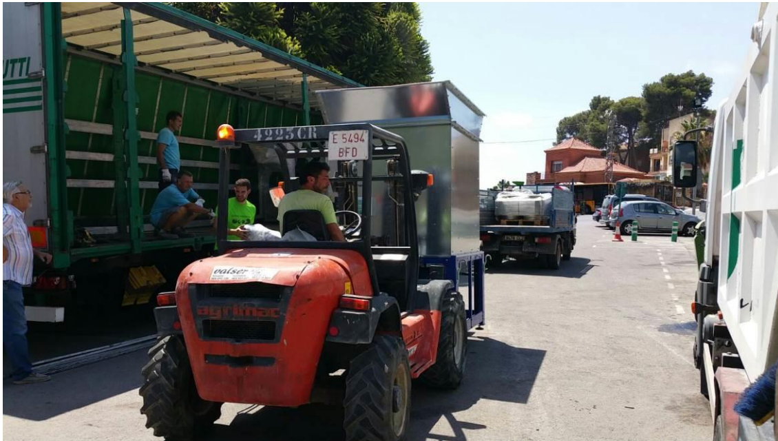
Fotografía 15. Descargas y montaje de la línea semi industrial de peletizado.
