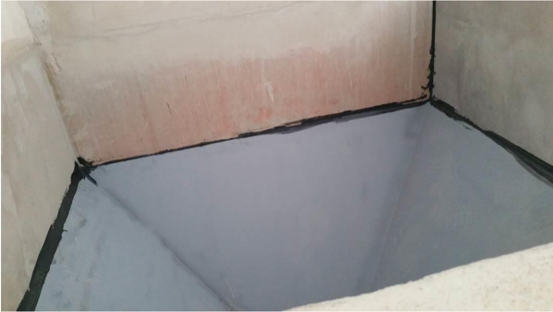
Fotografía 69. Construcción del silo de obra para pélets de caldera del colegio público. Fuente: Elaboración propia
