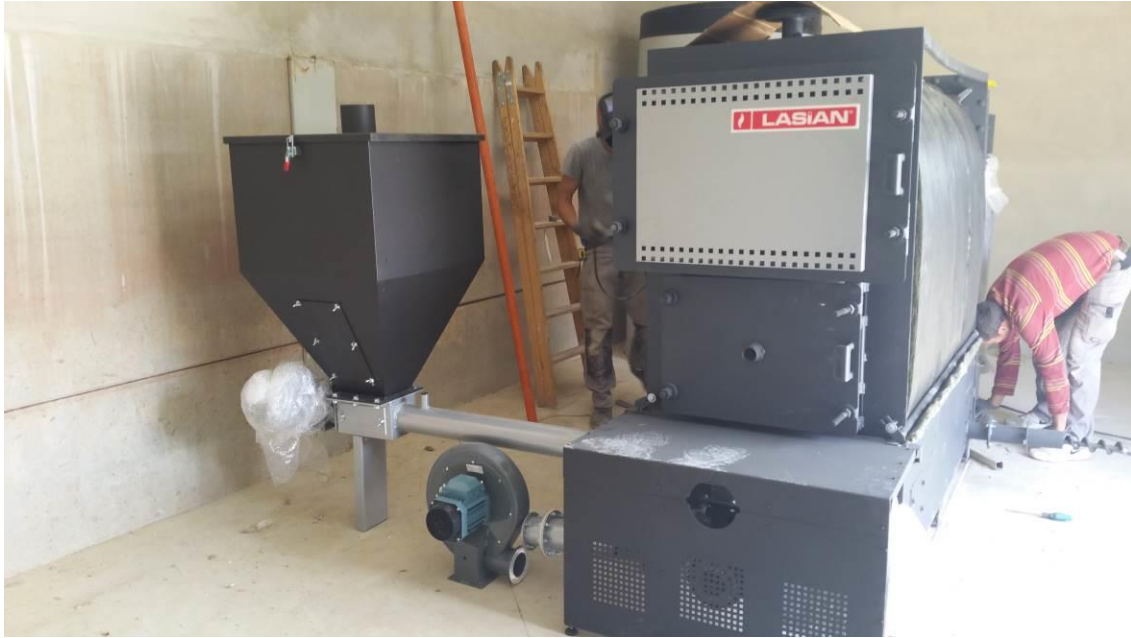
Fotografía 67. Montaje e instalación de la caldera del colegio público. Fuente: Elaboración propia
