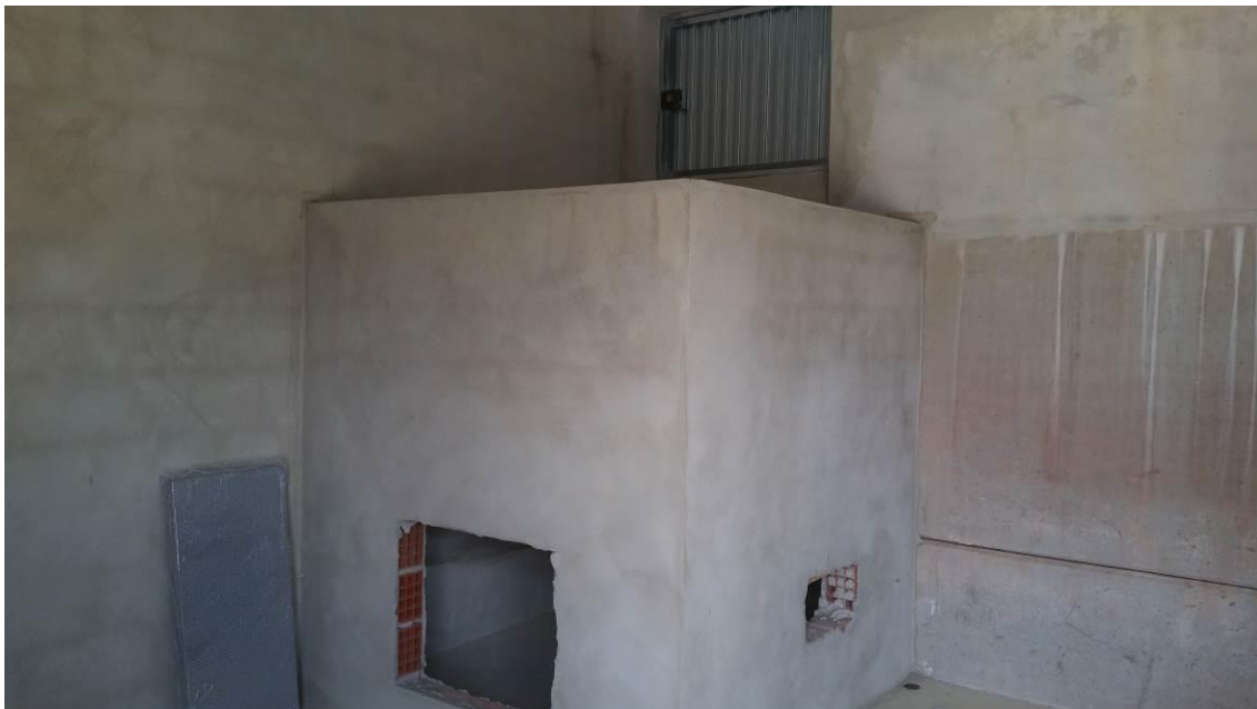
Fotografía 68. Construcción del silo de obra para pélets de caldera del colegio público. Fuente: Elaboración propia
