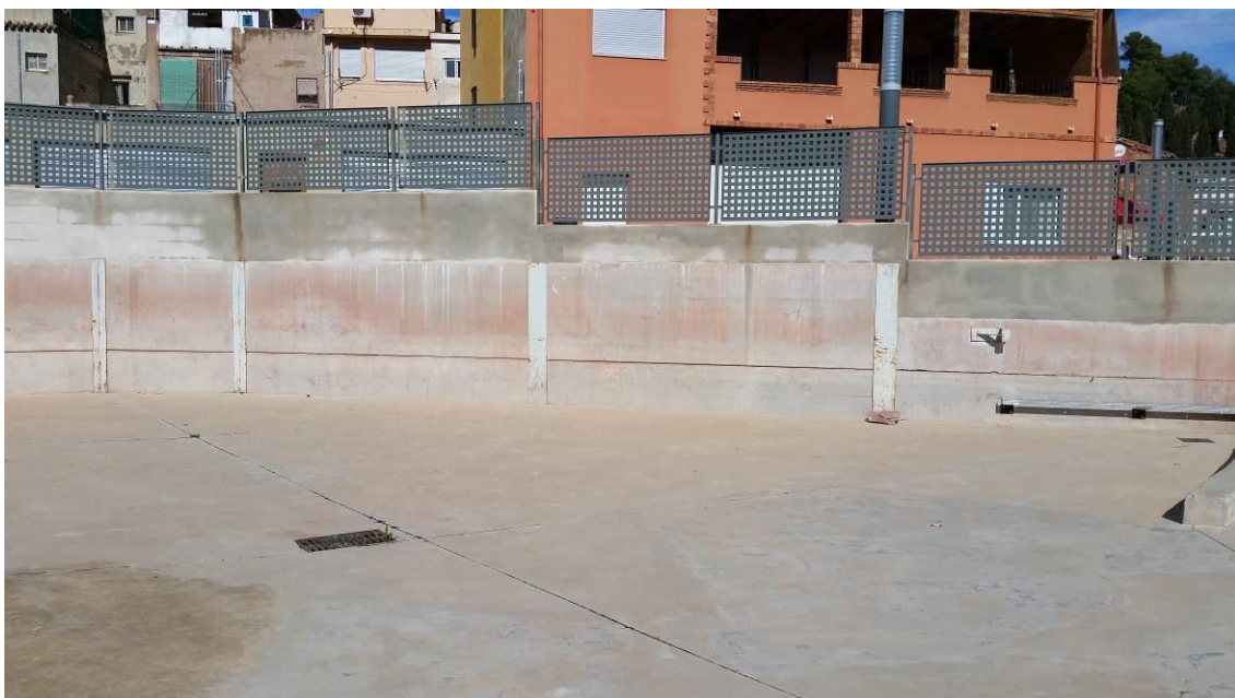
Fotografía 64. Parking de profesores en el colegio público previo a la construcción de la caseta que alojaría la caldera.
