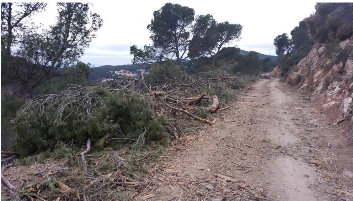
Fotografía 75 .Trabajos de ejecución del área cortafuegos camino Ombría Castell. Fuente: Elaboración propia.
