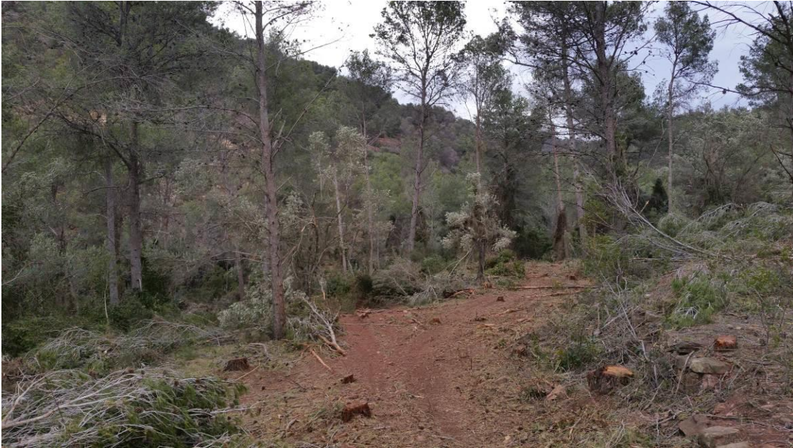
Fotografía 76 .Trabajos de ejecución del área cortafuegos camino Ombría Castell. Fuente: Elaboración propia.
