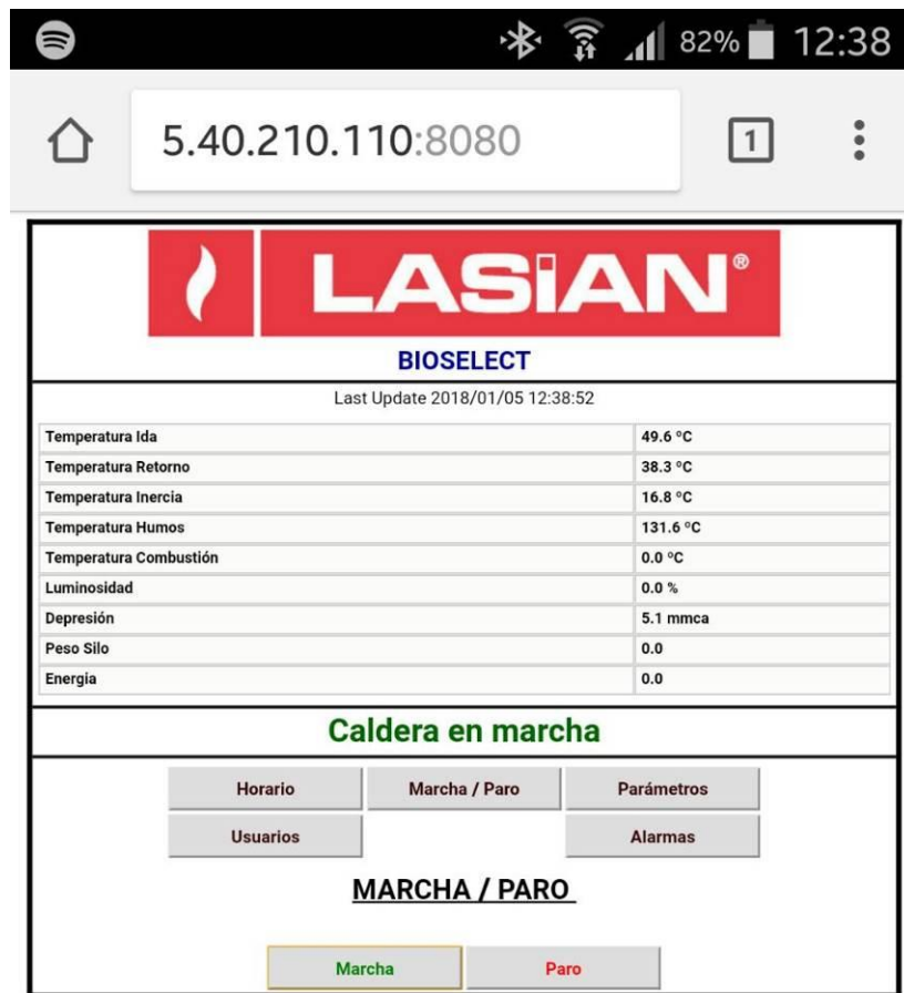
Fotografía 63. Interfaz de control remoto de la caldera del colegio público en terminal móvil.
