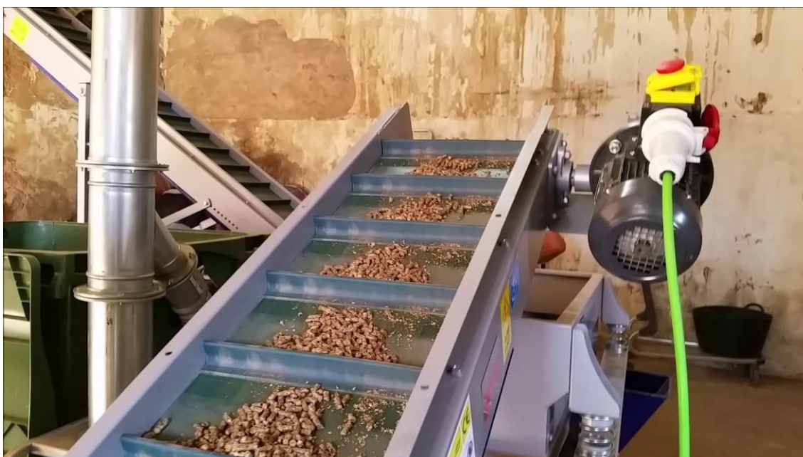
Fotografía 24. Puesta en marcha de la línea semi industrial de peletizado.
