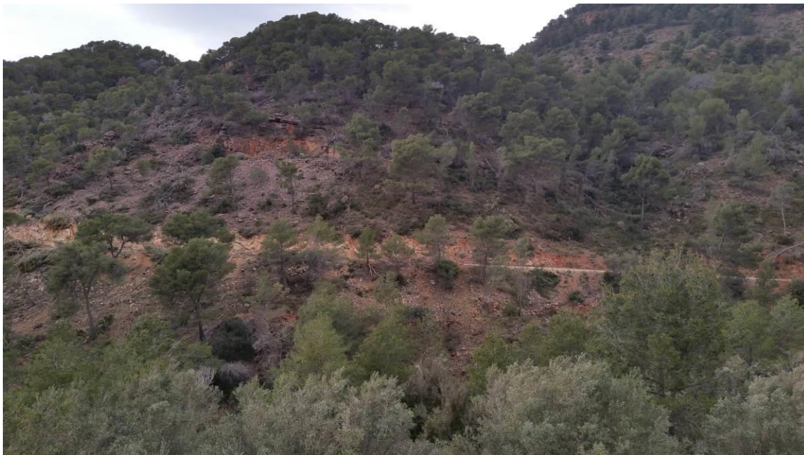
Fotografía 78 .Trabajos de ejecución del área cortafuegos camino Ombría Castell. Fuente: Elaboración propia.
