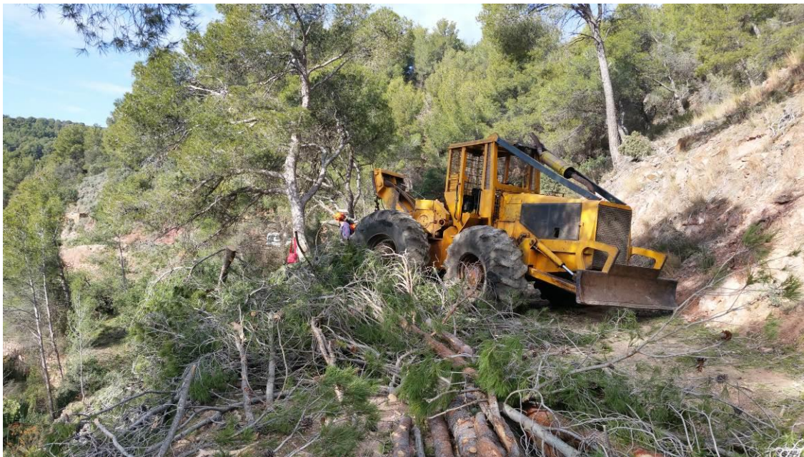
Fotografía 74 .Trabajos de ejecución del área cortafuegos camino Ombría Castell. Fuente: Elaboración propia.
