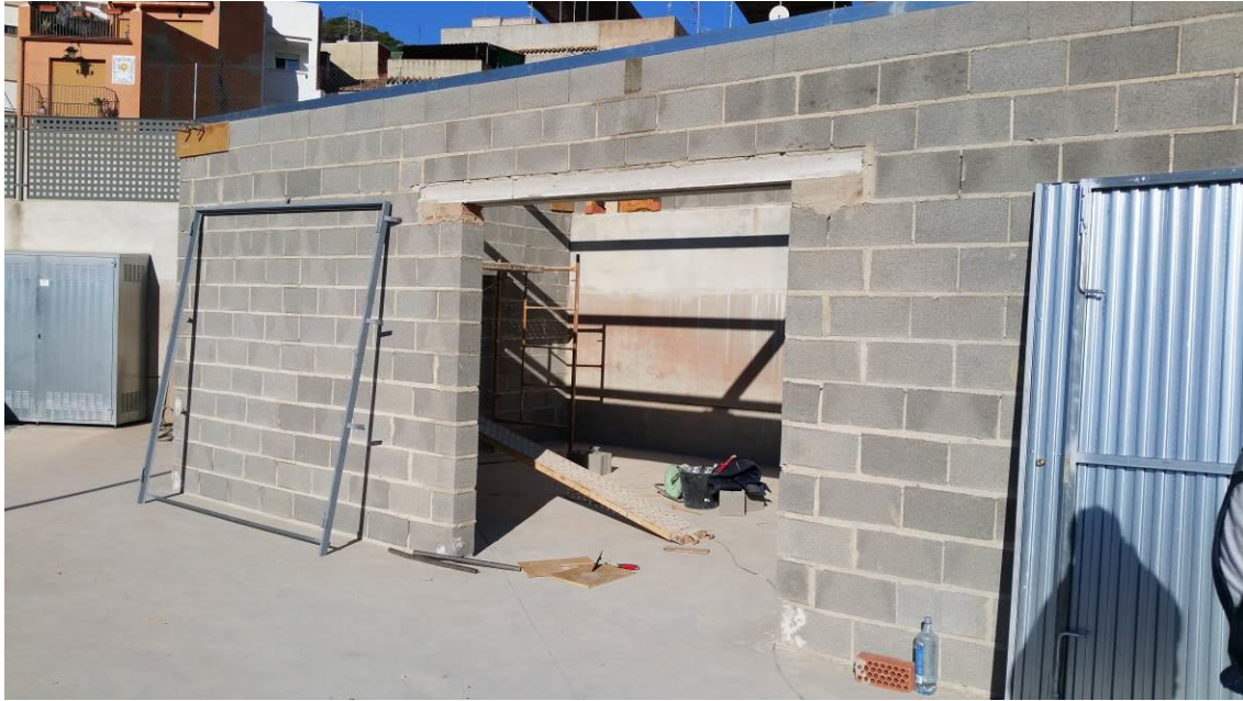
Fotografía 65. Construcción de la caseta que alojaría la caldera del colegio público.
