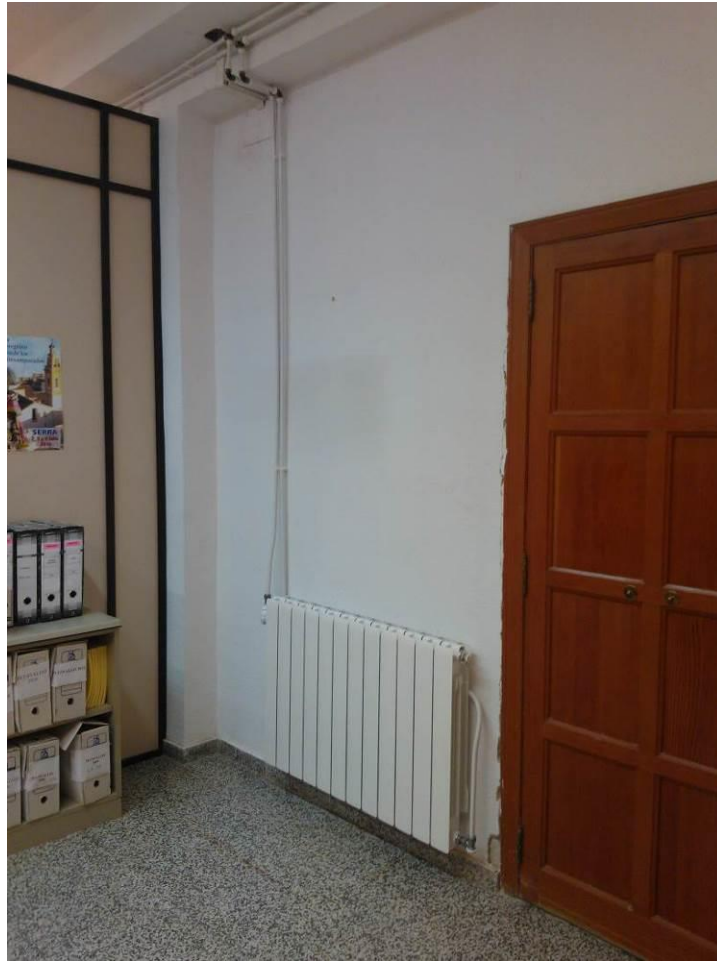
Fotografía 57. Instalación de radiadores del edificio consistorial, oficina registro.
