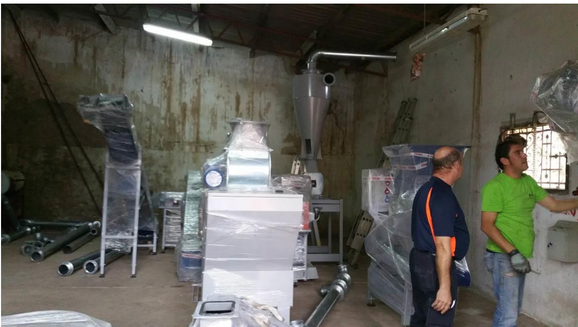
Fotografía 20. Descargas y montaje de la línea semi industrial de peletizado.
