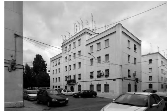
Fig. 36. Imagen identificativa del grupo. Fuente: Renta Limitada. Los grupos de vivienda barata construidos en la post-guerra (1939-1964). Fotografía realizada por Juan Peiró.
