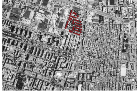
Fig. 65. Imagen aerea del grupo, a través de google.maps para su ubicación. Fuente: Elaboración propia.
