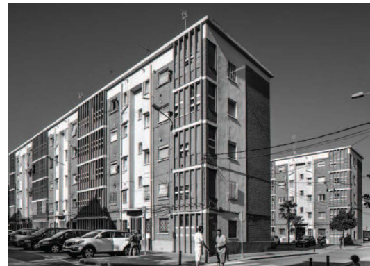
Fig. 11 Imagen del Grupo Virgen de la Fuensanta, de la década de 1960, proyecto de J. A. Pastor, J.R.Pons, C. Soria. Fuente: Renta Limitada. Los grupos de vivienda barata construidos en la postguerra (1939-1964). Fotografía realizada por Juan Peiró.
