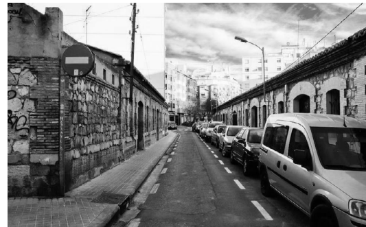
Fig. 22 Vista general de al Calle Ramon de Castro Fuente: Las Provincias. Tamara Villena.
