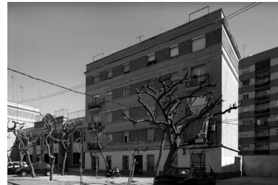
Fig. 16. Imagen identificativa del grupo. Fuente: Renta Limitada. Los grupos de vivienda barata construidos en la post-guerra (1939-1964). Fotografía realizada por Juan Peiró.
