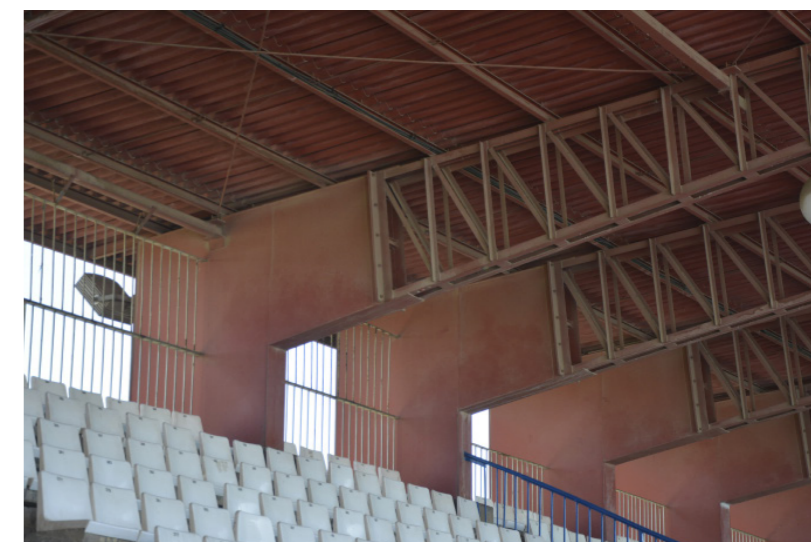
Figura 93. Cubierta sobre la Tribuna General, 2020.
