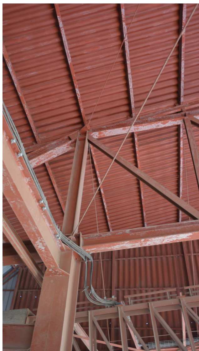
Figura 96. Encuentro interior del soporte con la cercha, 2020.
