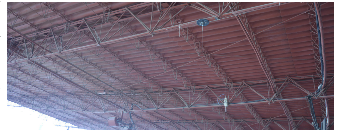
Figura 87. Celosías inferiores de la cubierta de tribuna Preferente, 2020.
