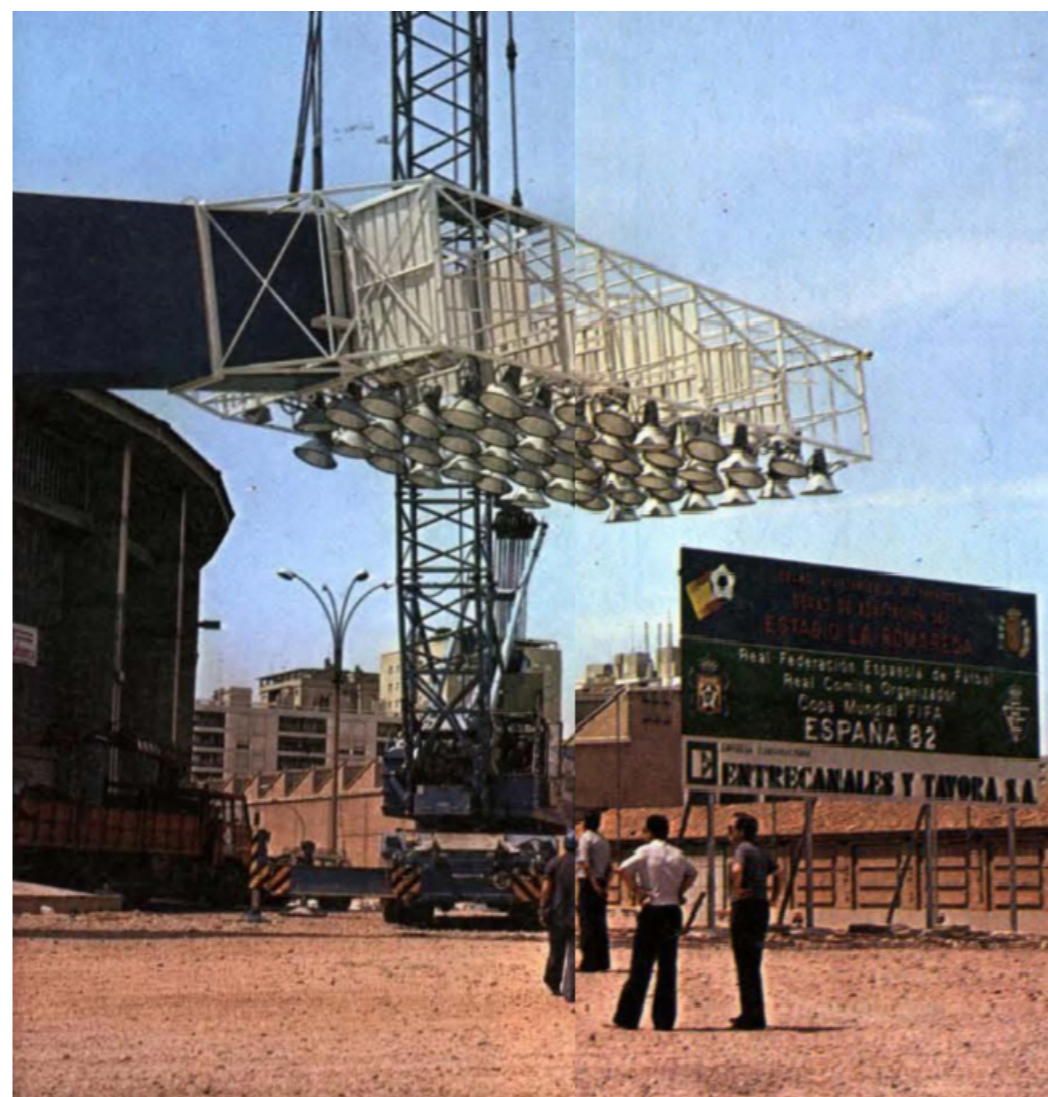
Figura 100. Instalación de las torres de iluminación para el Mundial'82, 1980.
