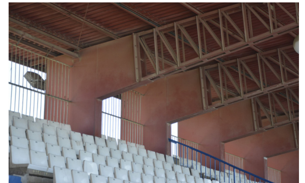
Figura 123. Pieza rígida sobre los soportes de la tribuna General que conecta con las celosías de cubierta, 2020.
