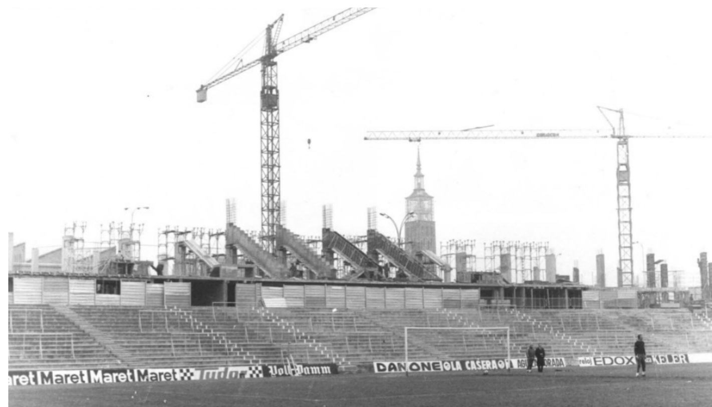
Figura 65. Ejecución de los pórticos de la tribuna Gol Norte, 1975.
