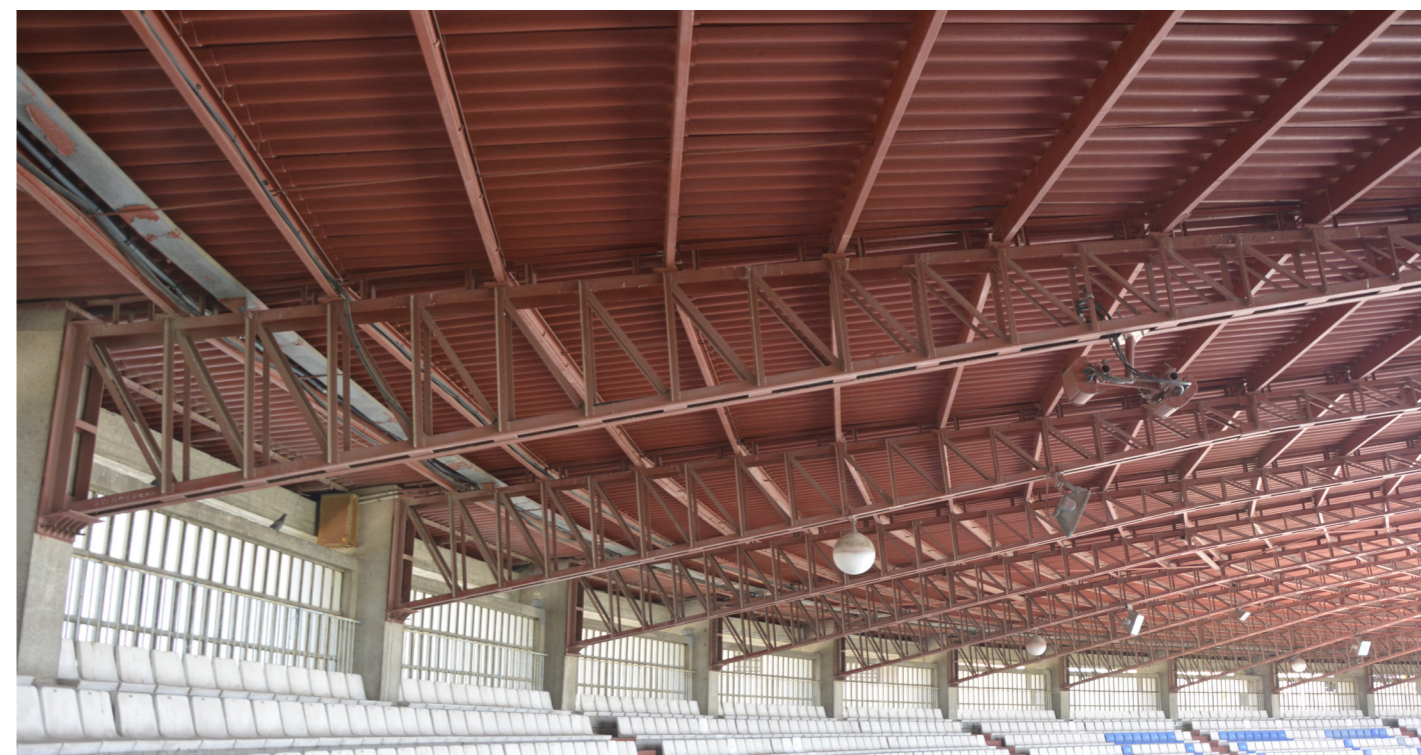
Figura 114. Cubierta sobre la tribuna Gol Norte, 2020.
