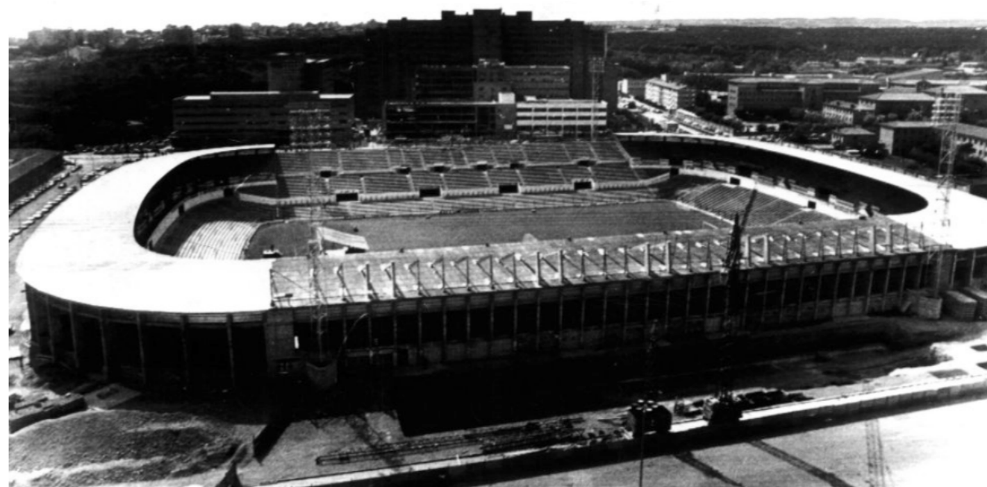
Figura 69. Imagen del estadio al finalizar la Segunda Fase. Se aprecia que únicamente falta la cubierta de la tribuna General.
