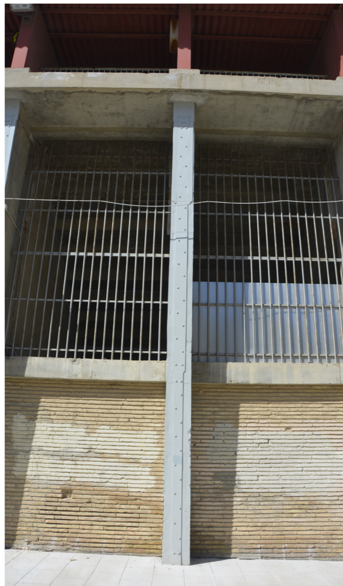
Figura 71. Refuerzo externo del pórtico, tribuna General, 2020.
