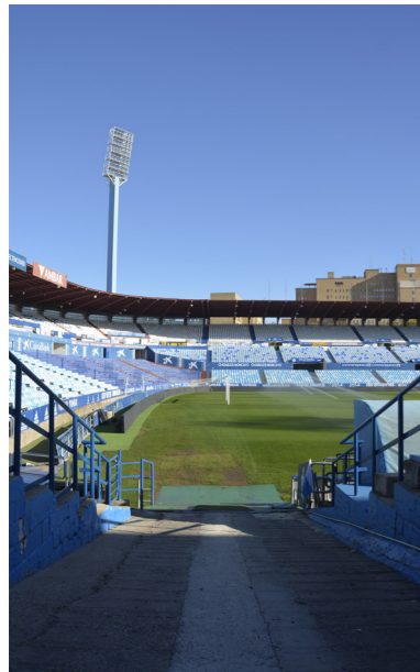
Figura 41. Vista desde el tunel de vestuarios. 2020.
