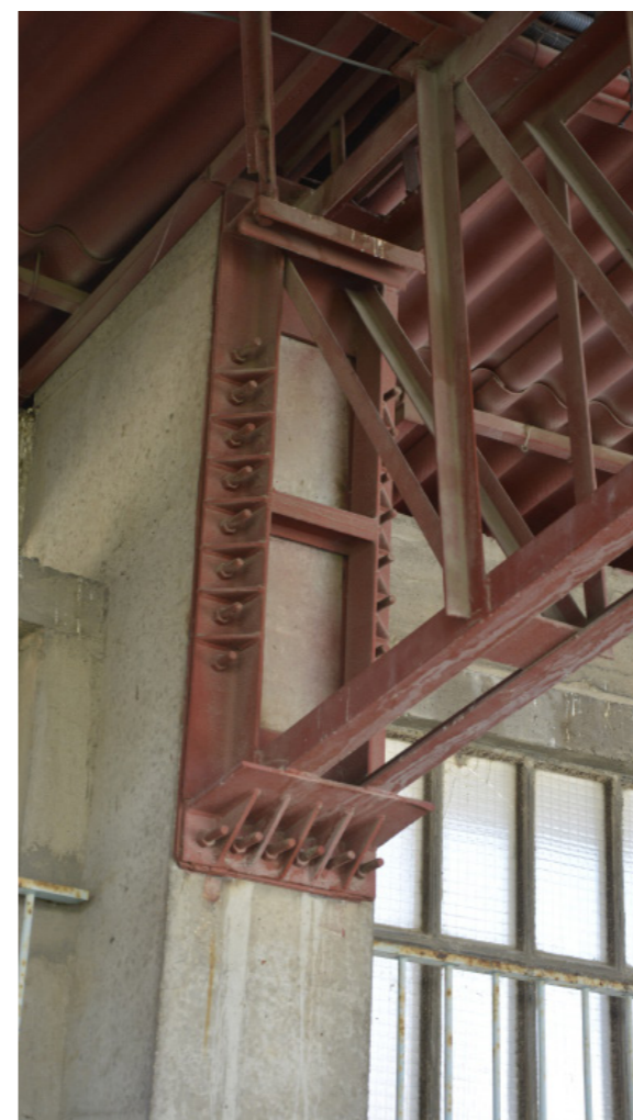
Figura 116. Empotramiento atornillado de la celosía de la cubierta con el pórtico de la tribuna Gol, 2020.
