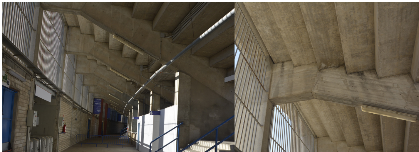
Figura 63. Pórticos de la grada Gol Sur, 2020.
