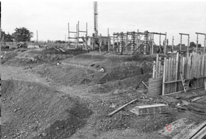
Figura 59. Encofrado de los pórticos, 1956.
