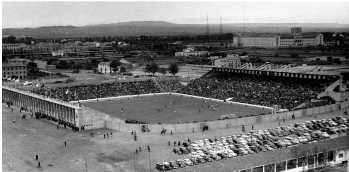
Figura 102. Imagen del nuevo estadio de La Romareda tras ejecutar la primera fase.
