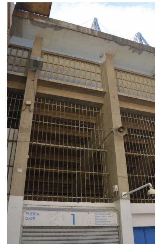
Figura 105. Vista exterior de la tribuna Preferente y la losa perimetral superior, 2020.
