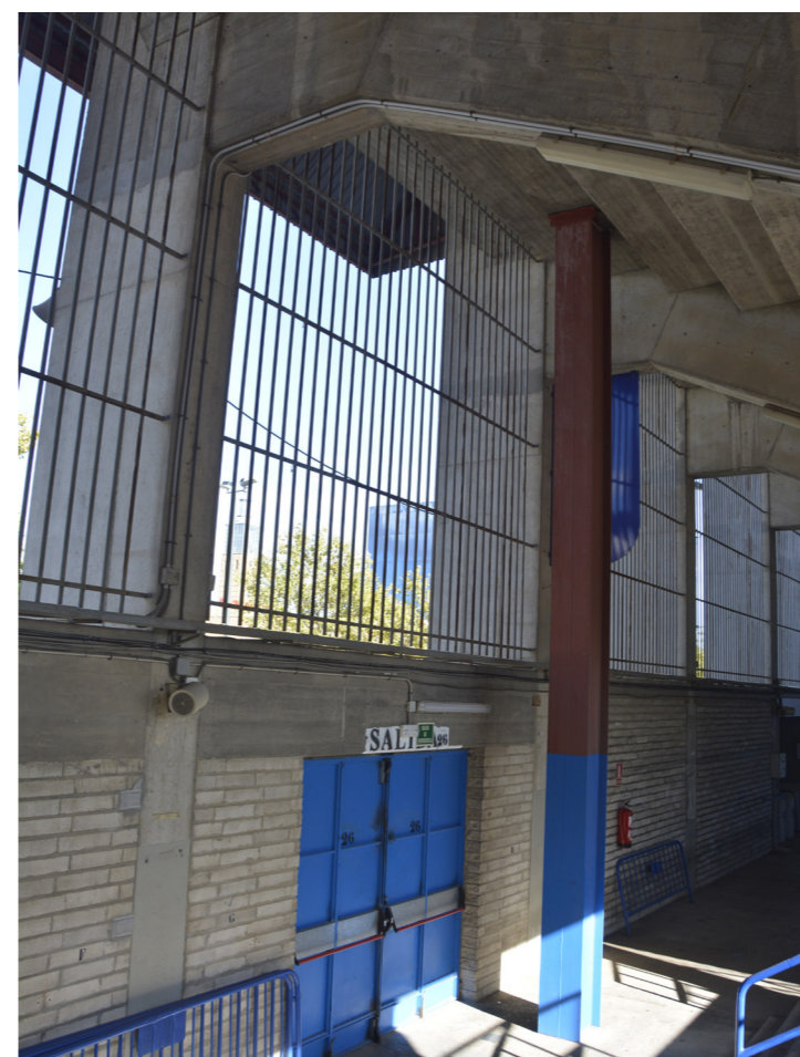
Figura 108. Entrada a la tribuna Gol Norte junto con el apoyo interior de la estructura del marcador, 2020.
