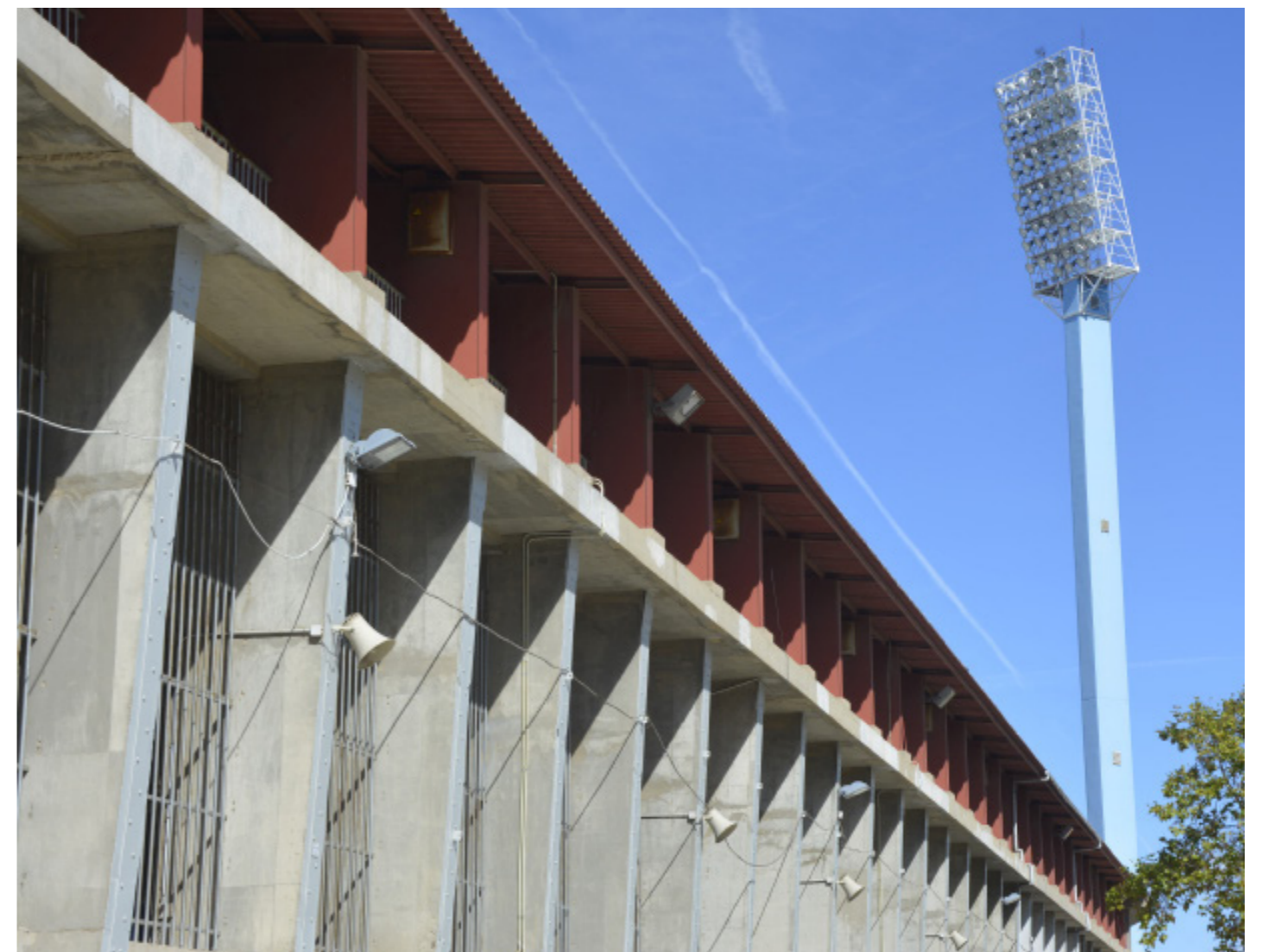
Figura 74. Vista de la tribuna General y la torre de iluminación Este. 2020.
