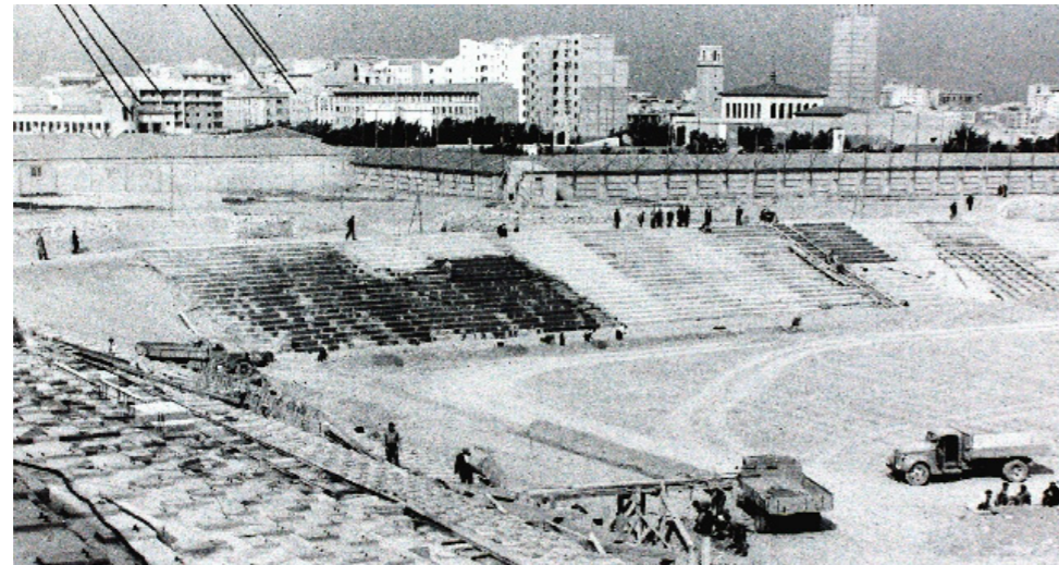
Figura 31. Construcción del nuevo estadio del Real Zaragoza C.D., 1956.
