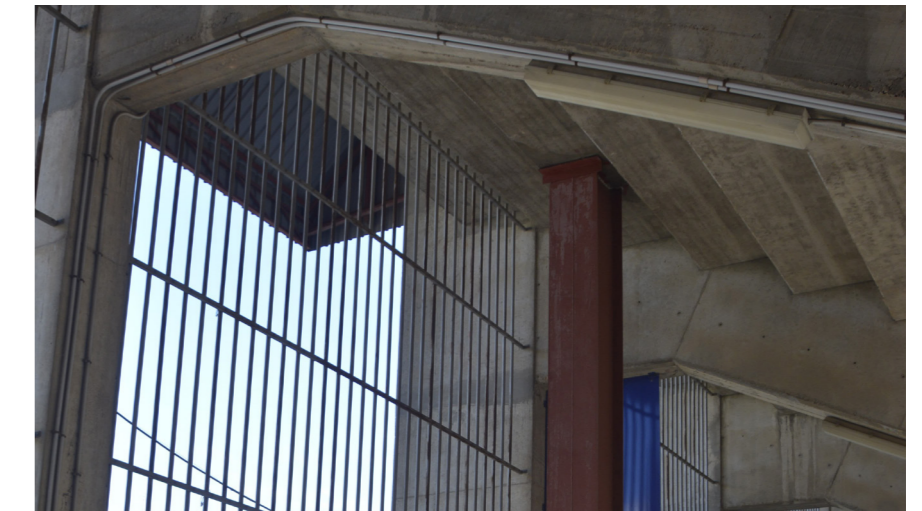
Figura 121. Soporte de la estructura del marcador atravesando la grada, 2020.
