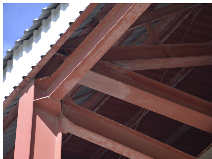
Figura 97. Encuentro exterior del soporte con la cercha, 2020.
