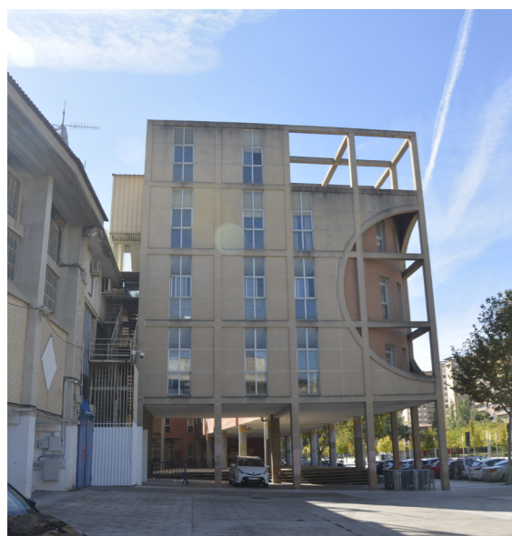
Figura 75. Edificio de Urbanismo. 2020.
