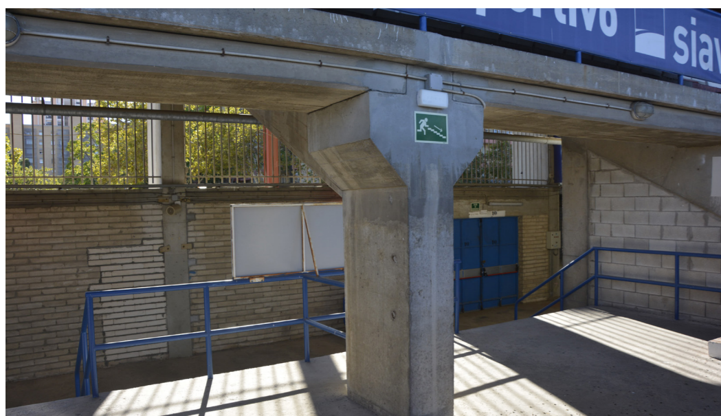
Figura 89. Soporte del pórtico de la sección, Tribuna Gol Sur, 2020.
