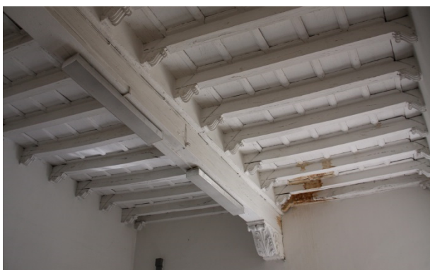
Figure 12: Timber floor in Palazzo Affaitati-Soldi.
