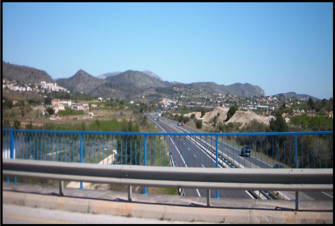
Foto n° 7: Vista de la Sequia junto a la Autopista A7.
