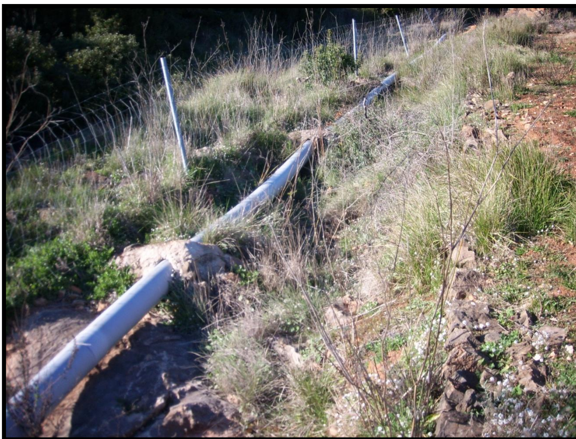
Foto nº 15: Apreciación de tuberías en el cauce del barranco de l'Aigüera.
