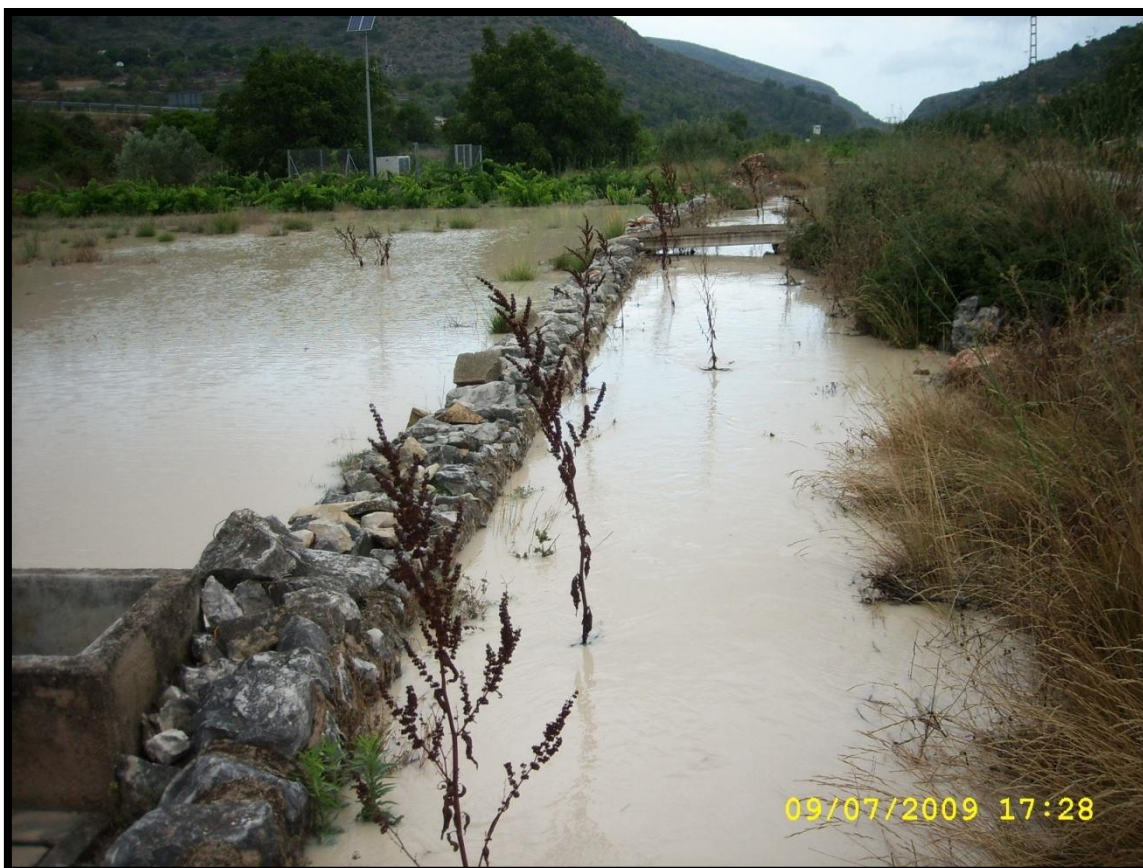
Foto nº 23: Efectos de las lluvias torrenciales en el barranco de l'Aigüera
