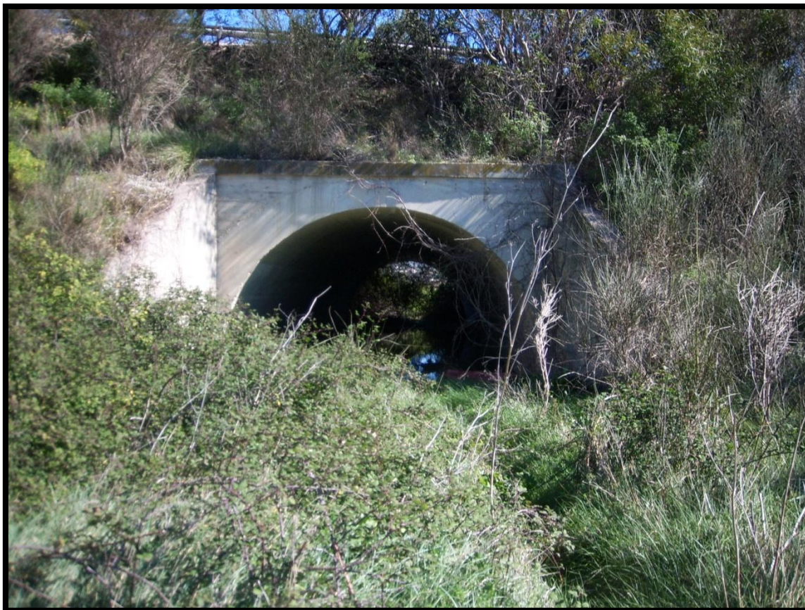
Foto nº 11: Barranco de la Sequia cruzado por un desagüe de la Autopista A7.
