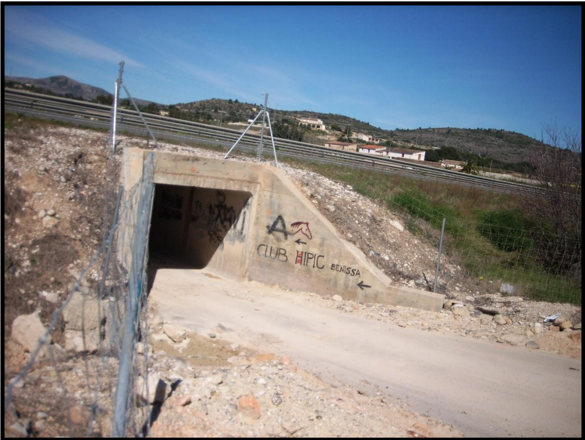
Foto n° 8: Puente situado sobre el cauce del barranco de l'Aiguera.
