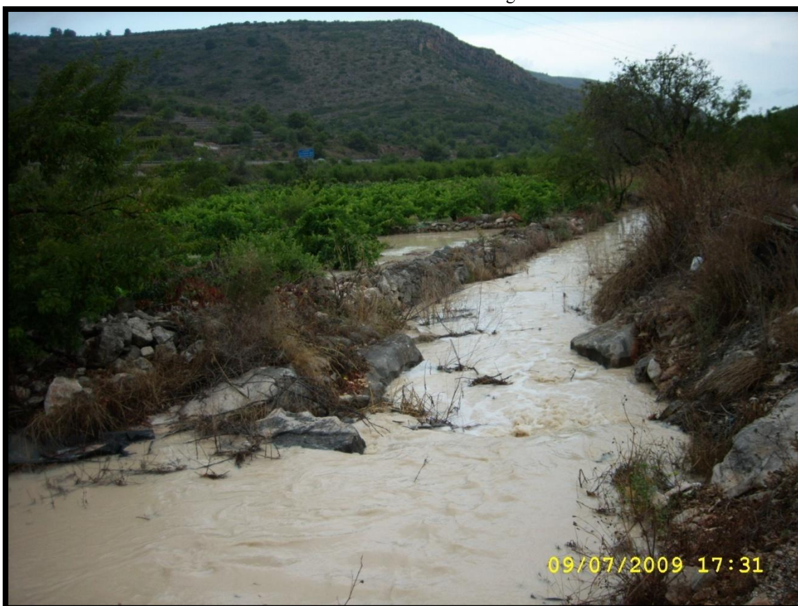
Foto nº 24: Efectos de las lluvias torrenciales en el barranco de l'Aigüera
