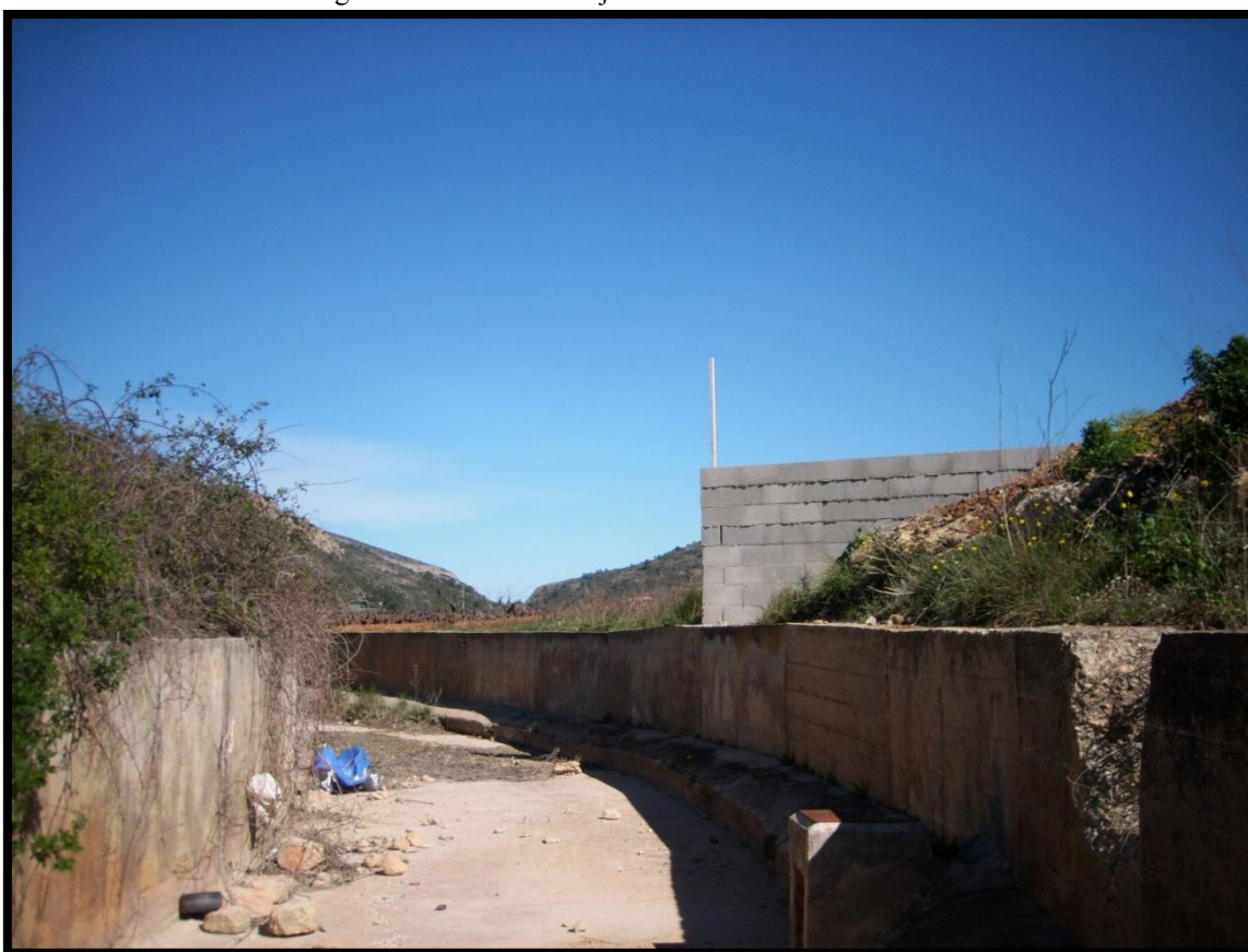
Foto nº 14: Encauzamiento del barranco de l'Aigüera.
