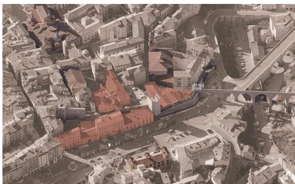
Figura 78 Construcciones derribadas para la actuación
