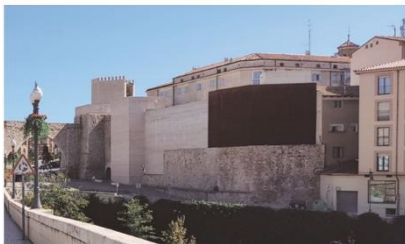
Figura 45 Restauración de muralla
