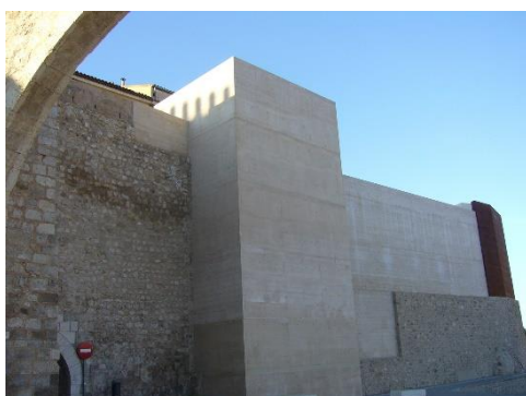
Figura 49 Restauración de la muralla
