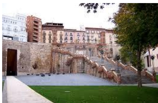
Figura 31 Escalinata y ascensor de acceso
