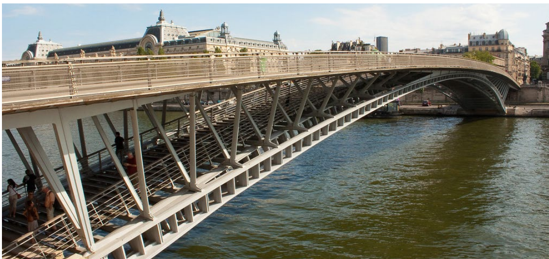
Imagen 40 Pasarela Solferino, Paris. (Fuente: https://www.flickr.com/photos/franibanez/ )
