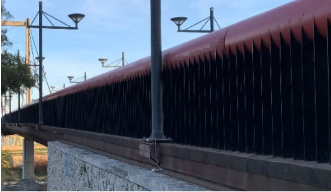
Imagen 10 Vista de los equipamientos desde el estribo izquierdo. (Fuente: elaboración propia).
