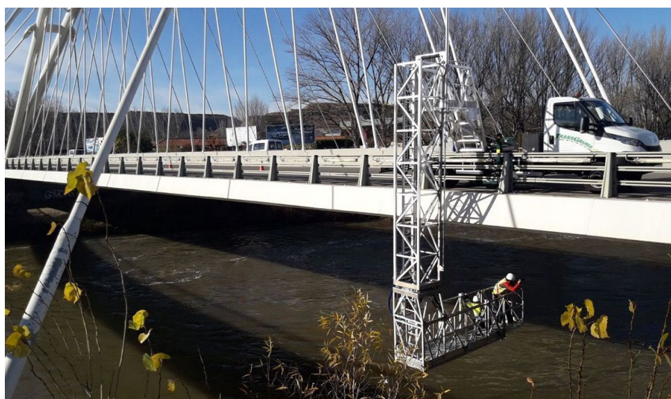
Imagen 73 Tareas de inspección del puente de Sagasta, Logroño. (Fuente: Transgruma)
