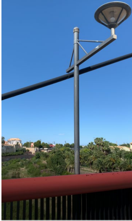
Imagen 11 Farola sobre el tablero. (Fuente: elaboración propia)
