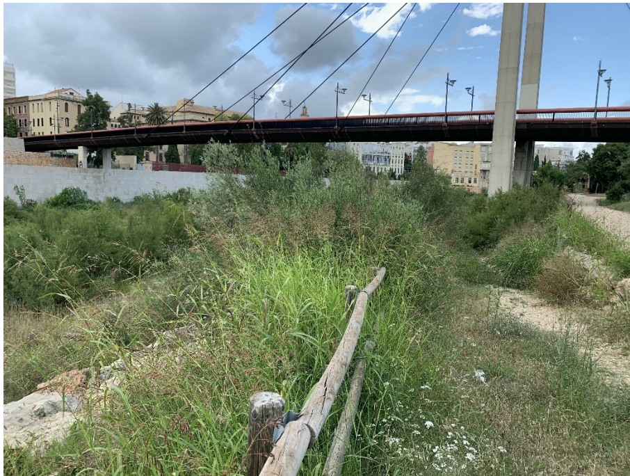
Imagen 83 Camino de acceso al cauce del río [2]. (Fuente: elaboración propia).
