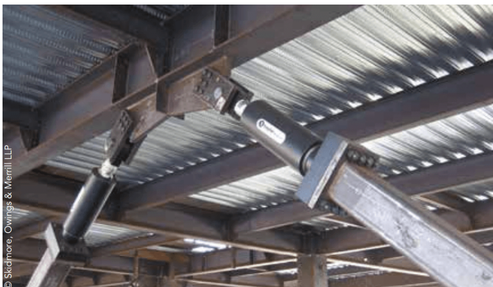
Imagen 36 Amortiguadores viscosos en el San Bernardino Justice Center. (Fuente: (CSI Spain, 2016)).
