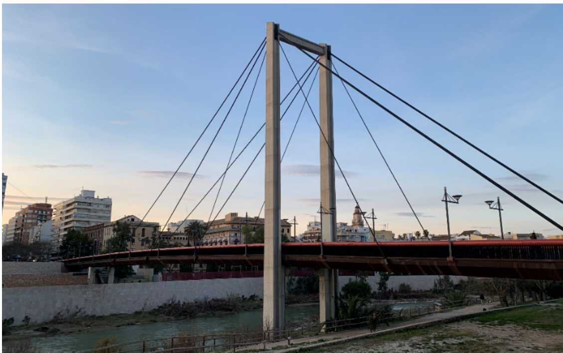
Imagen 9 Vista general de la estructura de la pasarela. (Fuente: elaboración propia).
