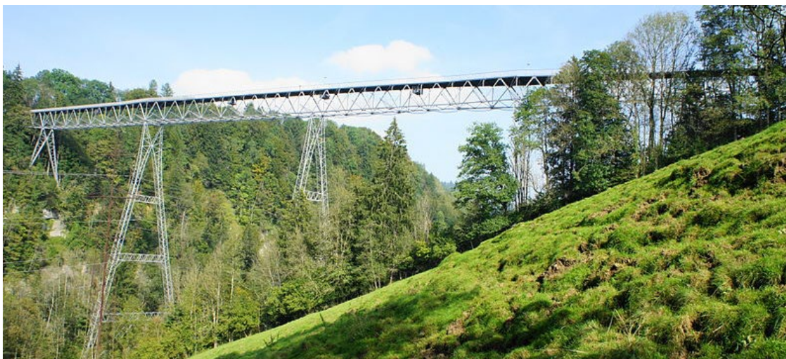
Imagen 47 Pasarela “Haggenbrücke”, Suiza. (Fuente: Wikipedia)
