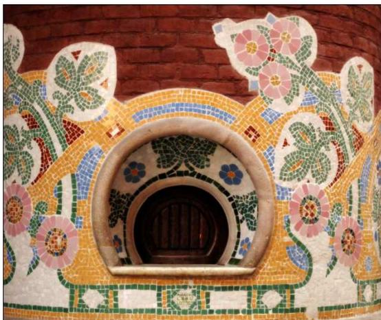
FIG. Nº 42: Taquilla realizada en el interior de una columna con el típico trencadís.
