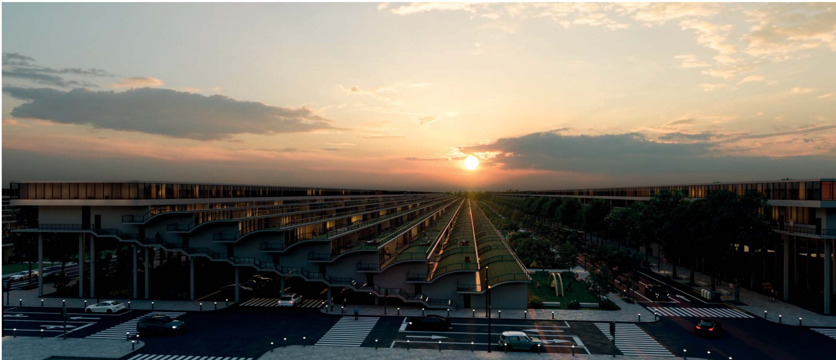
Fig. 133 (Doble página) Vista general de Conjunto de blocs
