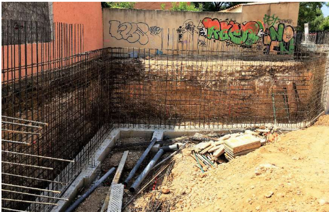
Figura 58 : diario de obra
