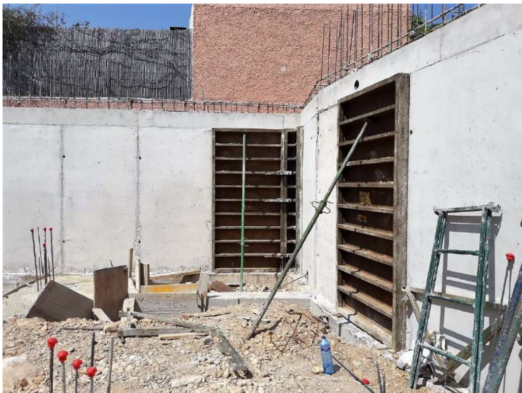
Figura 94 : diario de obra
