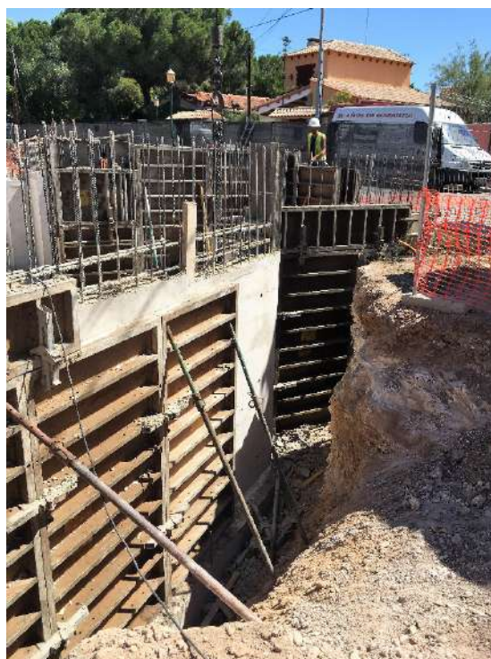
Figura 107 : diario de obra
