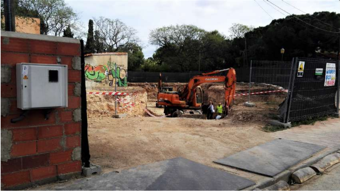
Figura 11 : diario de obra
