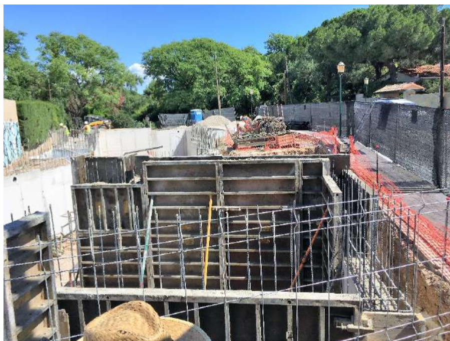
Figura 103: diario de obra
