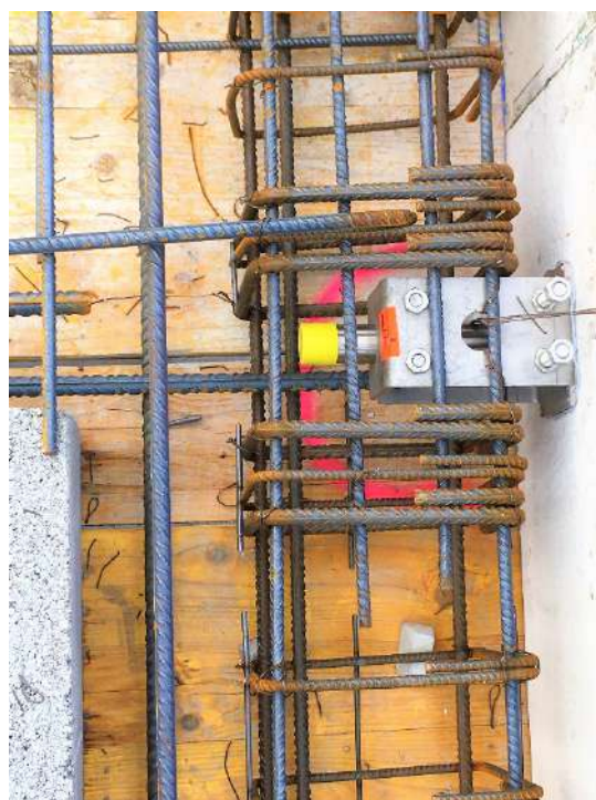
Figura 228 : diario de obra
