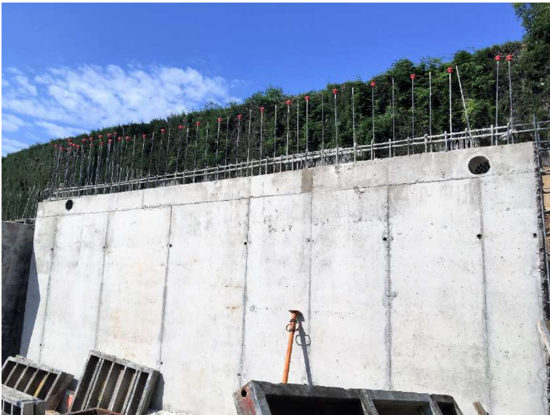
Figura 53 : diario de obra
