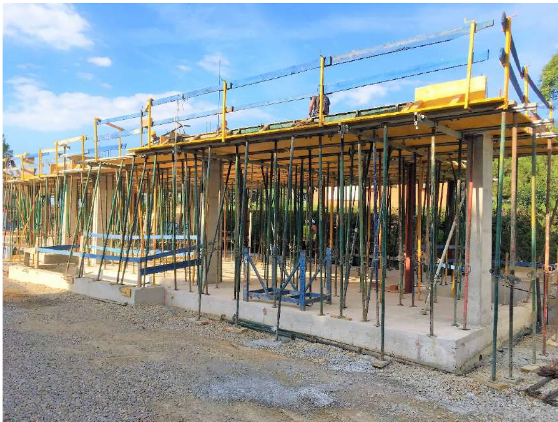
Figura 233 : diario de obra
