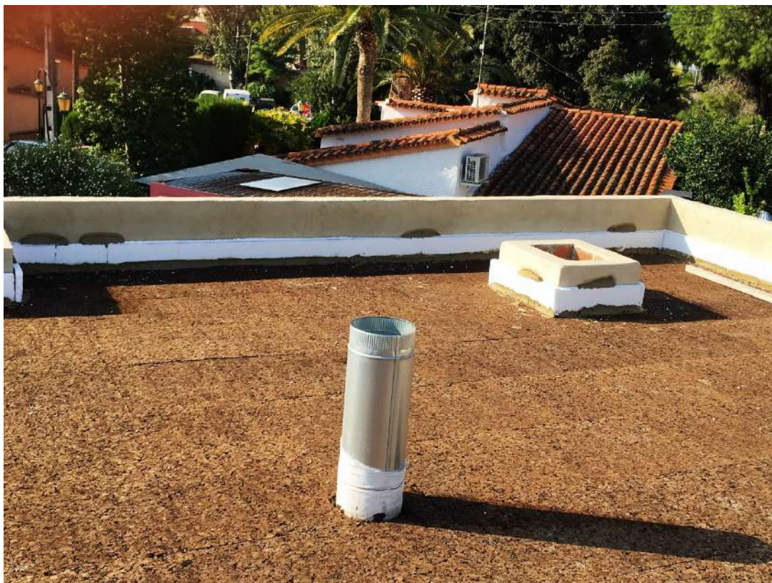
Figura 310 : diario de obra
