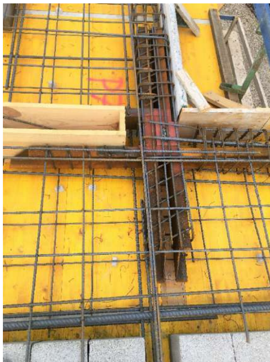
Figura 221 : diario de obra
