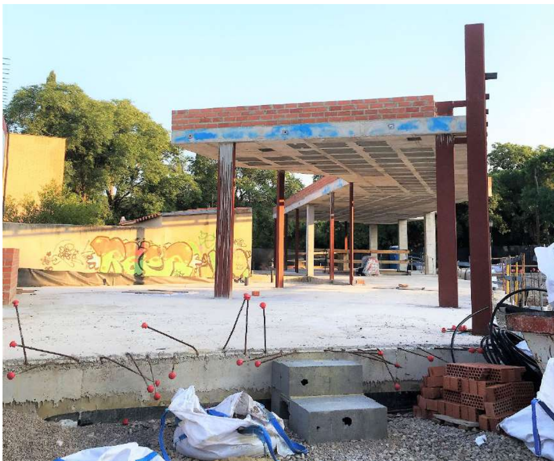
Figura 279 : diario de obra
