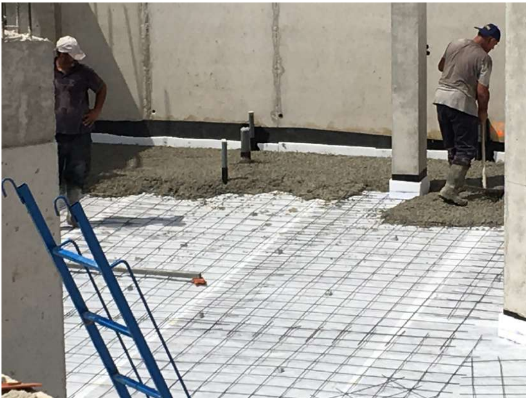
Figura 186 : diario de obra
