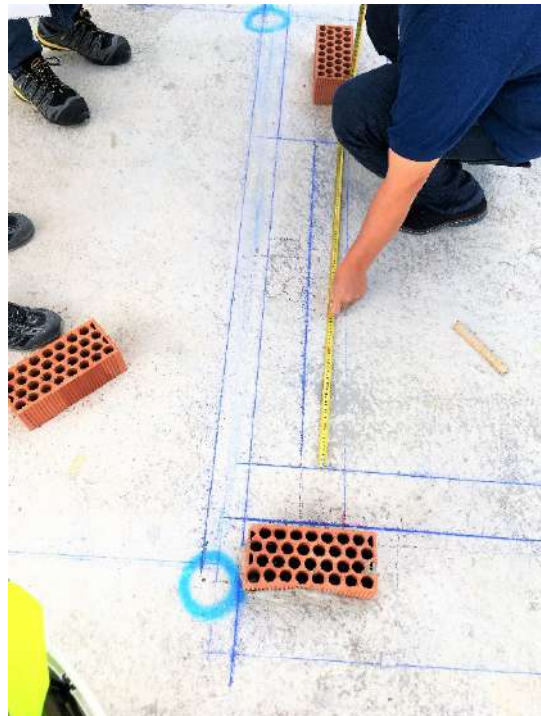
Figura 285 : diario de obra
