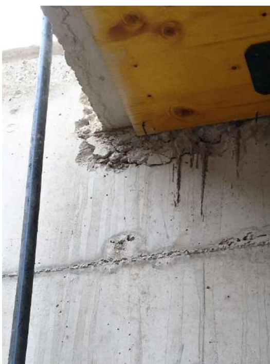
Figura 272 : diario de obra
