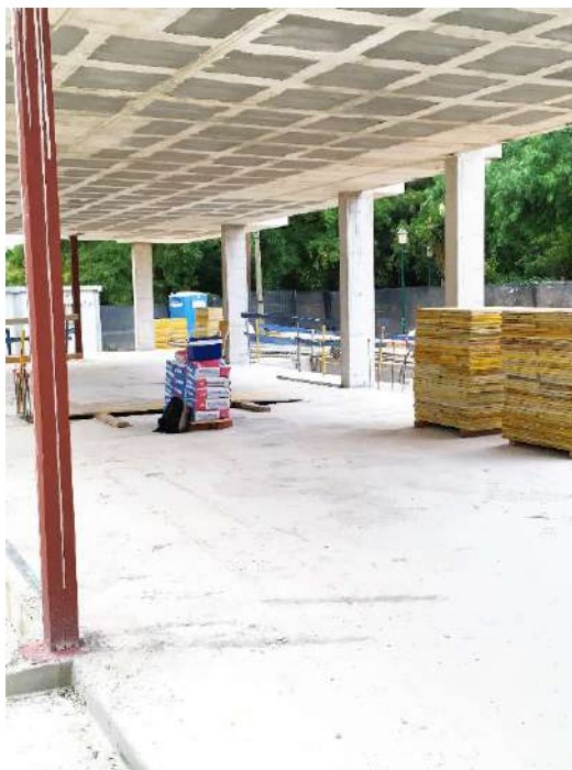
Figura 267 : diario de obra
