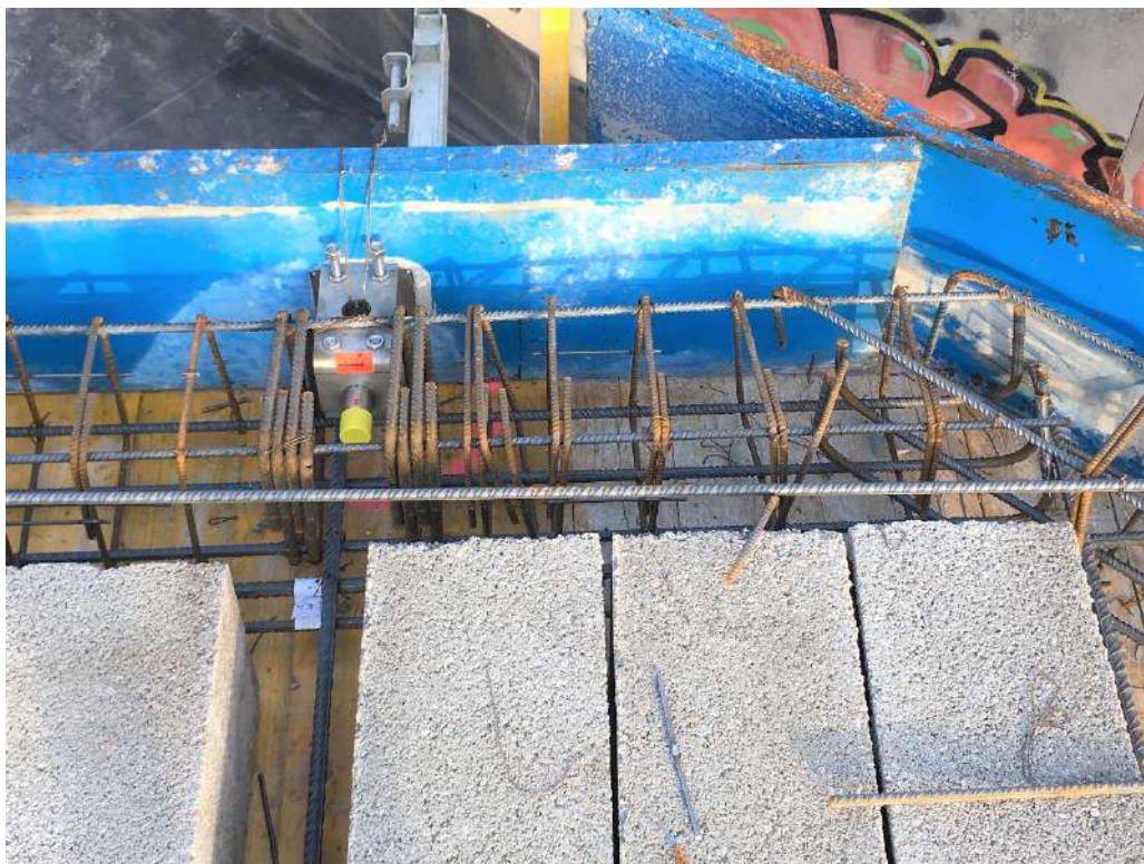
Figura 215 : diario de obra
