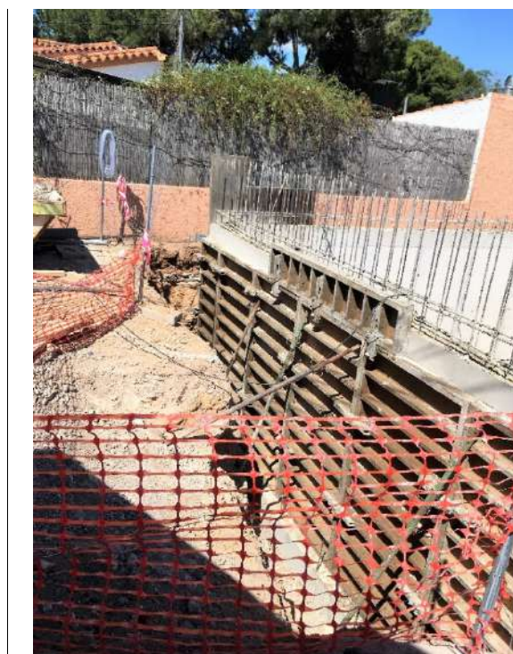
Figura 105 : diario de obra
