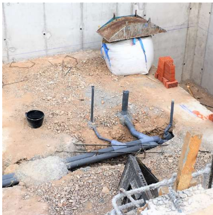
Figura 148 : diario de obra
