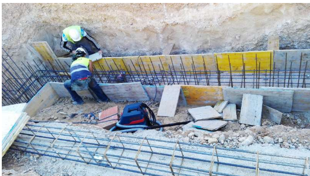
Figura 13 : diario de obra
