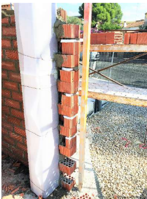
Figura 319 : diario de obra
