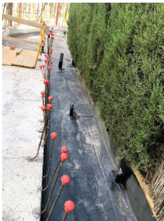
Figura 234 : diario de obra
