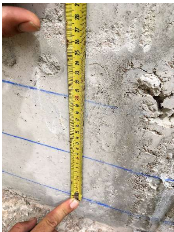
Figura 161 : diario de obra
