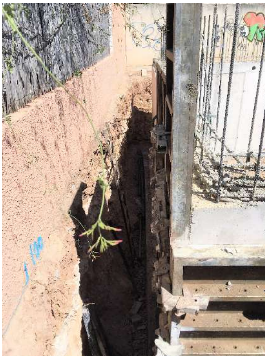
Figura 108 : diario de obra
