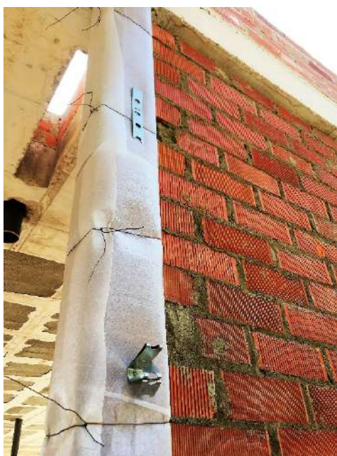
Figura 316 : diario de obra
