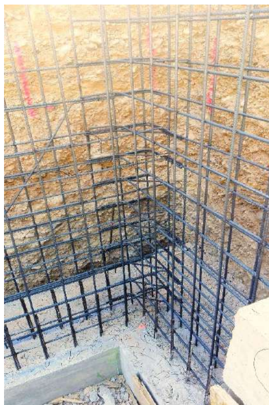
Figura 27: diario de obra
