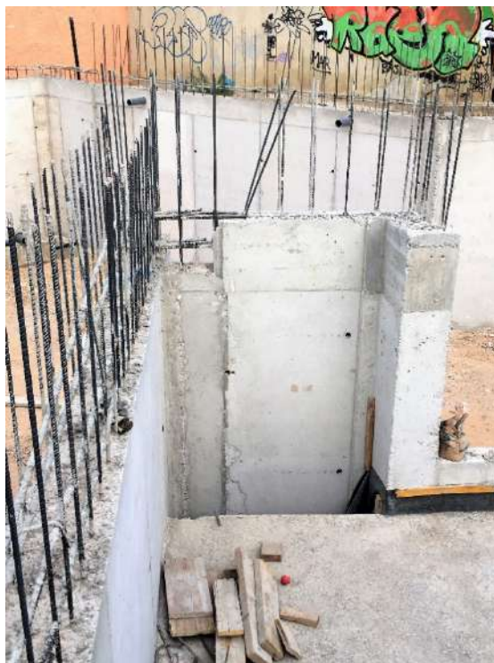
Figura 138 : diario de obra
