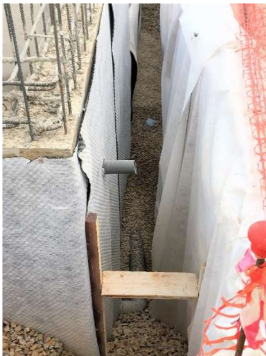
Figura 136 : diario de obra
