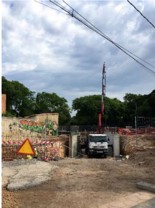
Figura 35 : diario de obra
