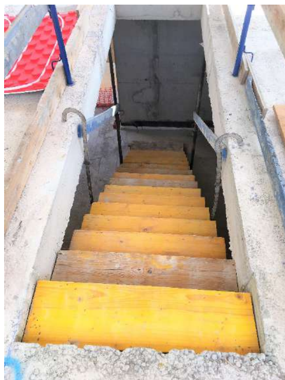
Figura 281 : diario de obra
