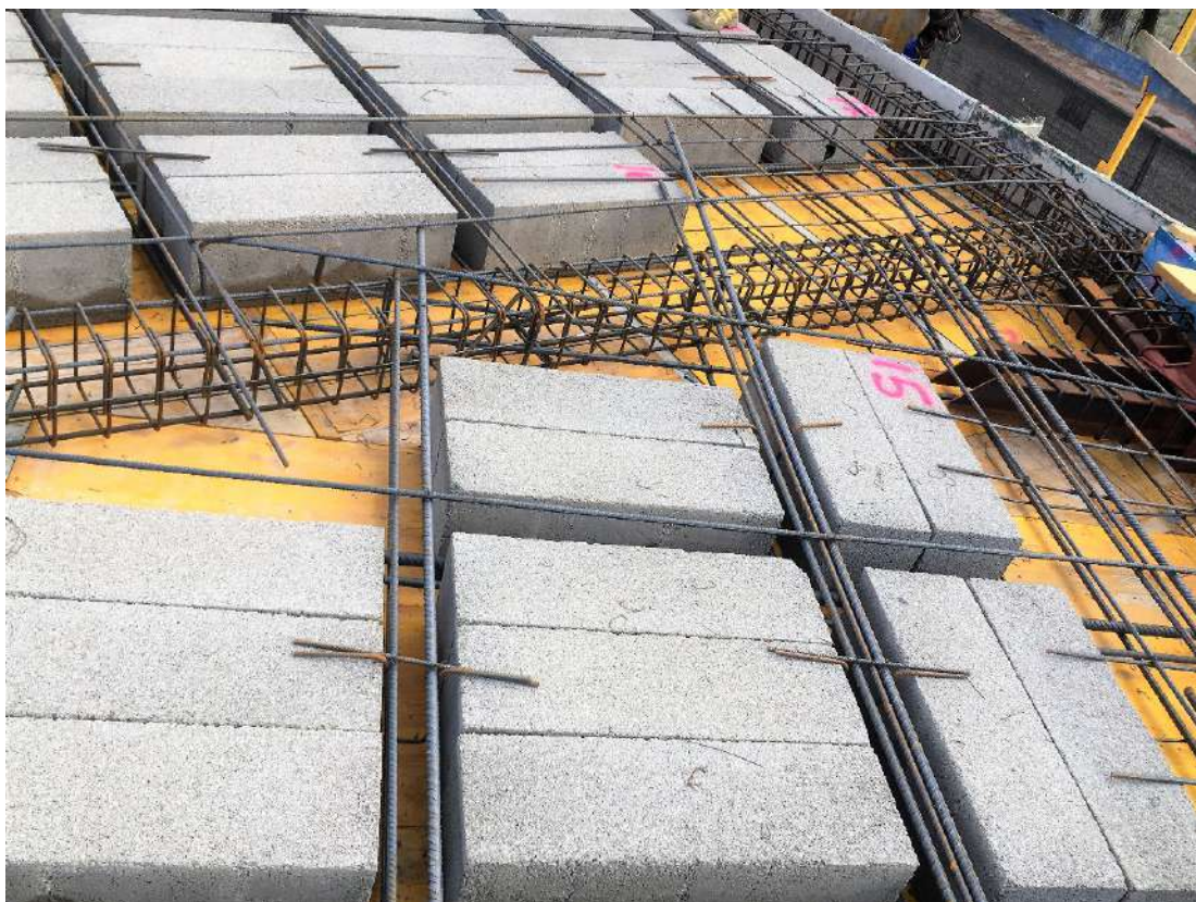
Figura 232 : diario de obra
