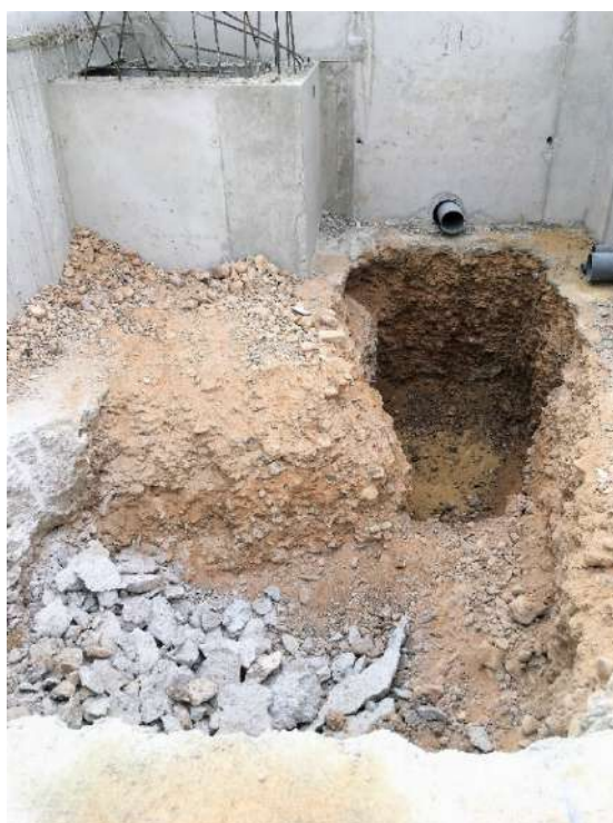
Figura 153 : diario de obra
