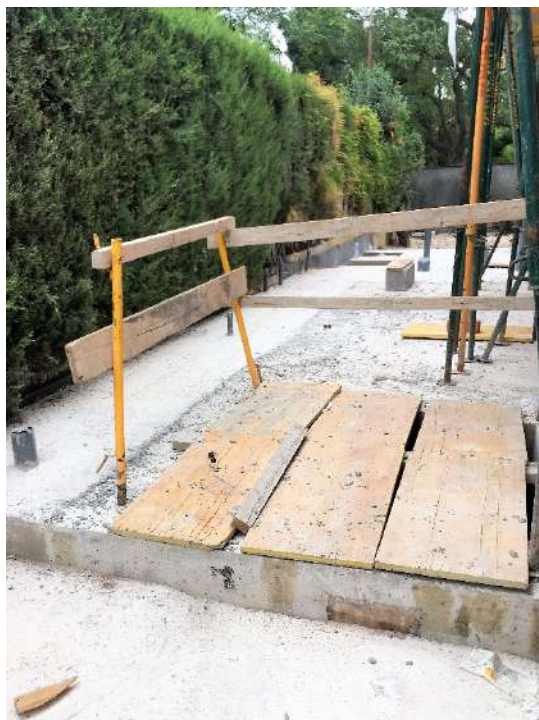
Figura 242 : diario de obra
