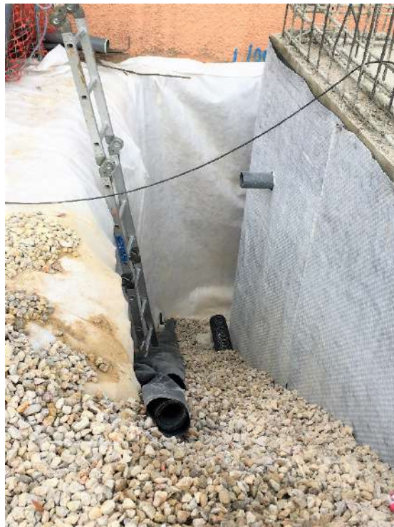
Figura 131 : diario de obra
