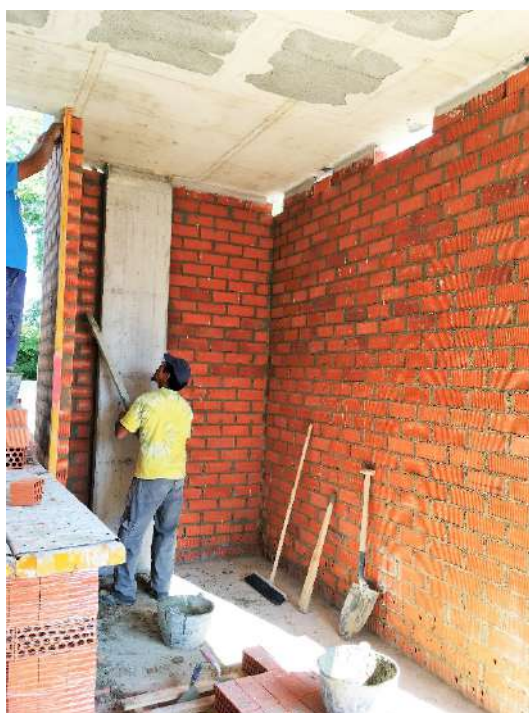
Figura 305 : diario de obra
