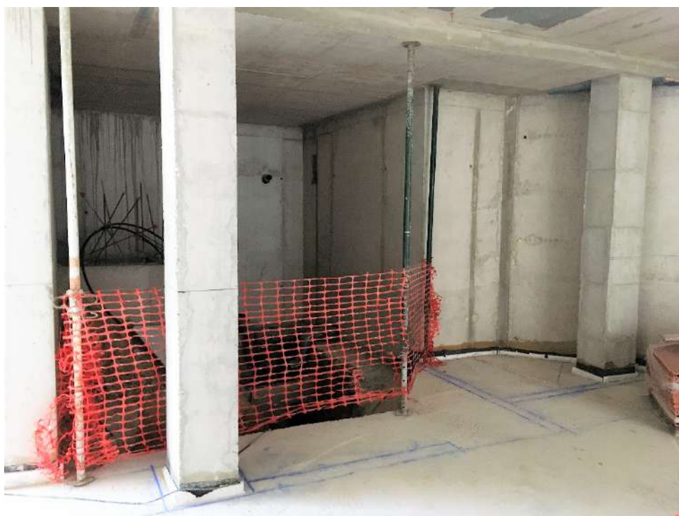
Figura 257 : diario de obra
