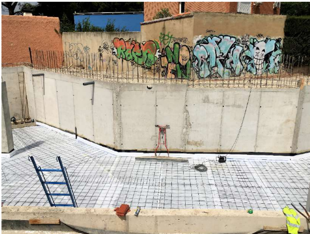
Figura 183 : diario de obra
