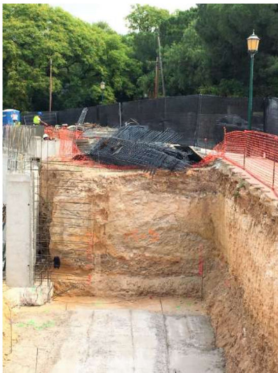
Figura 83 : diario de obra
