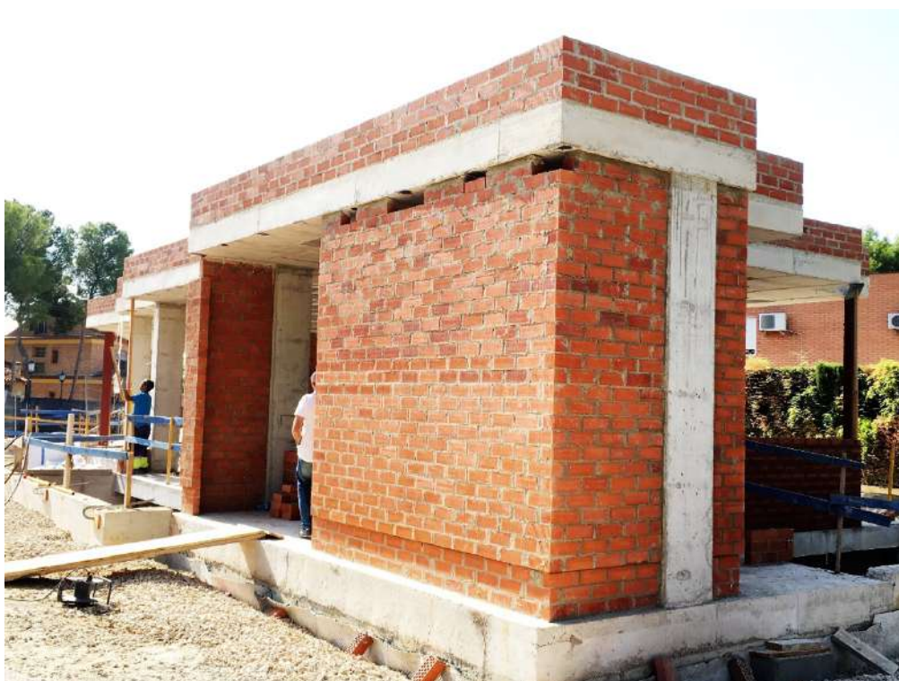
Figura 307 : diario de obra
