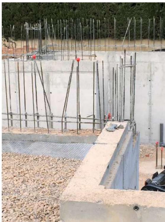
Figura 145 : diario de obra
