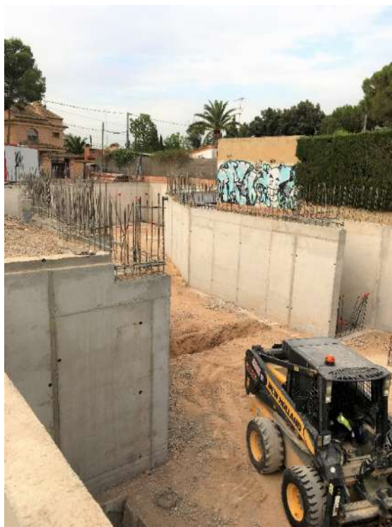
Figura 146 : diario de obra
