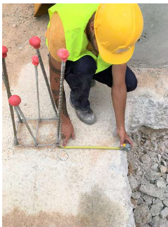
Figura 163 : diario de obra
