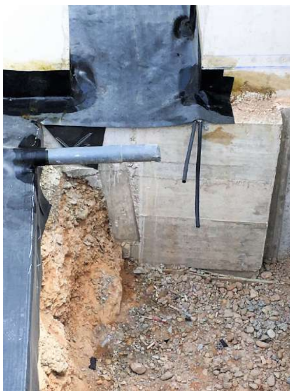
Figura 180 : diario de obra
