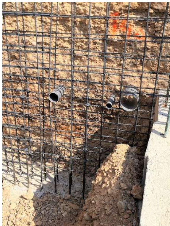
Figura 54 : diario de obra
