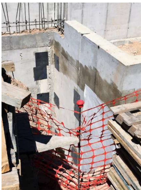
Figura 117 : diario de obra
