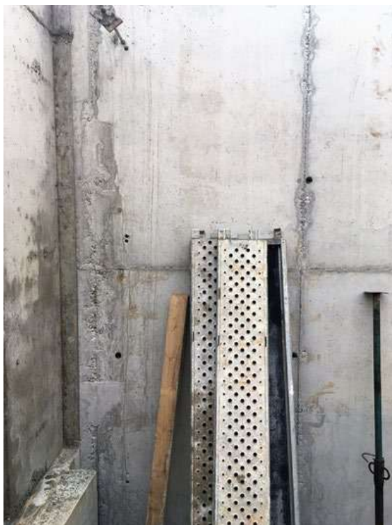
Figura 73 : diario de obra
