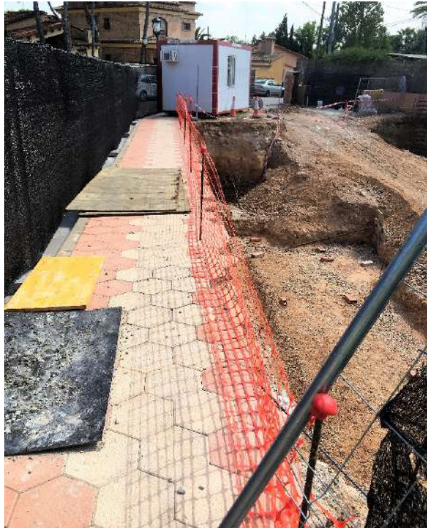
Figura 61 : diario de obra
