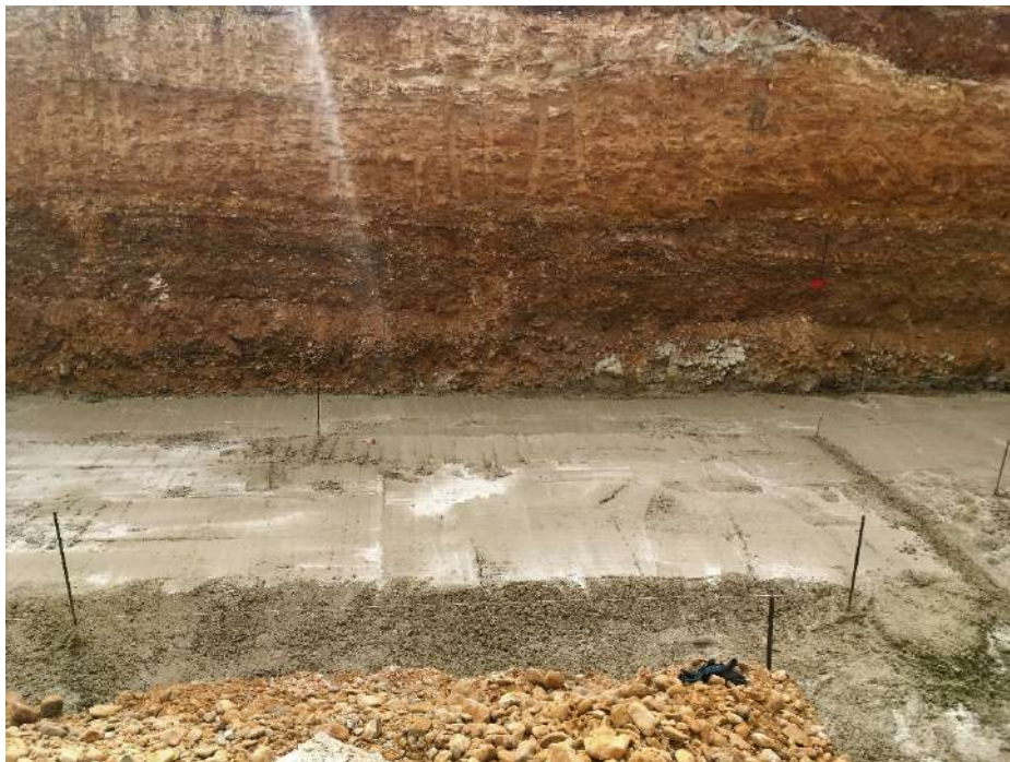
Figura 63: diario de obra
