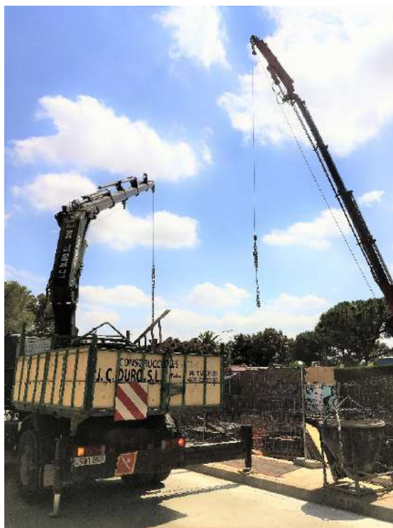
Figura 56 : diario de obra
