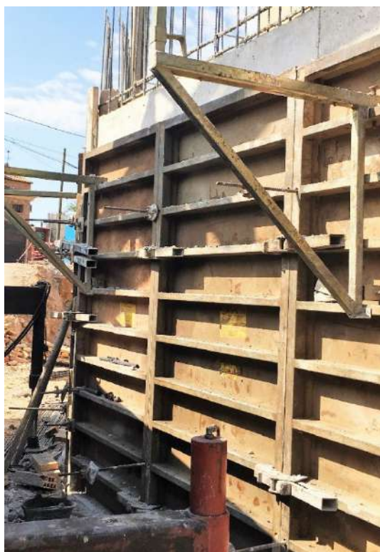
Figura 44: diario de obra
