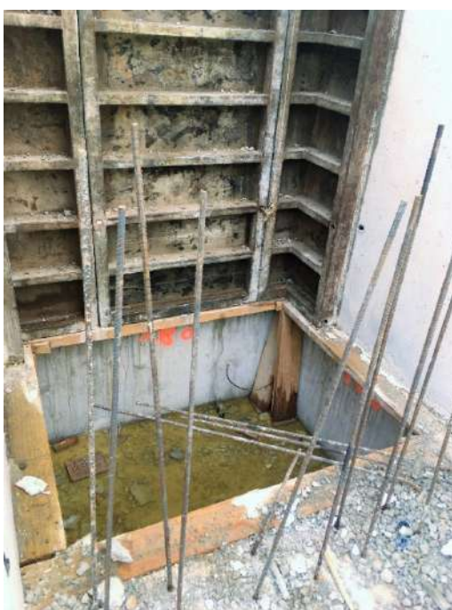
Figura 67 : diario de obra
