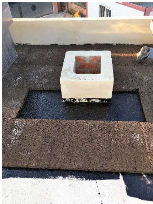
Figura 297 : diario de obra
