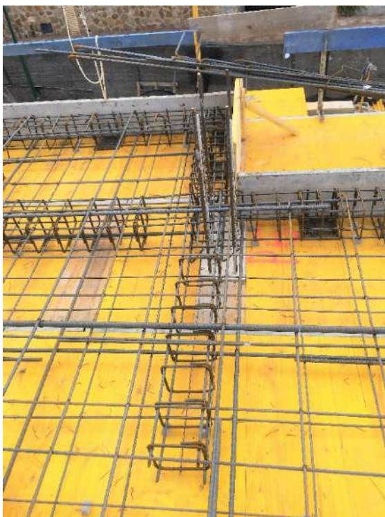
Figura 222 : diario de obra
