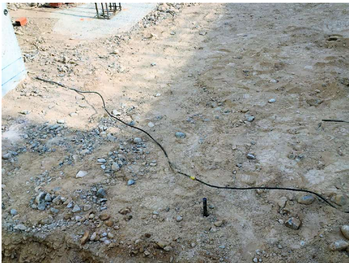
Figura 160 : diario de obra
