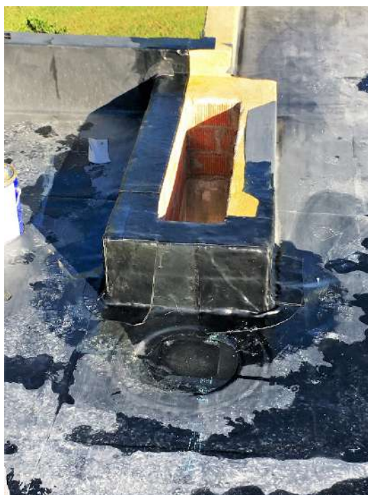
Figura 329 : diario de obra
