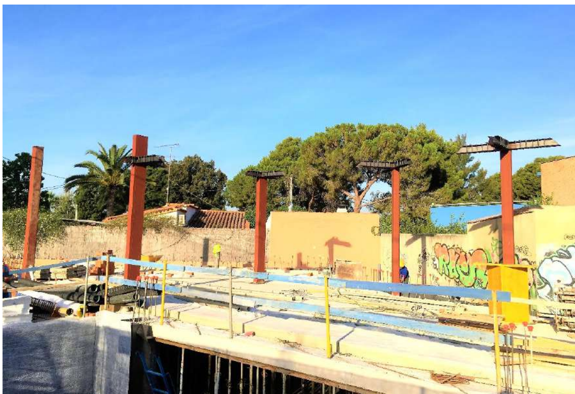
Figura 202 : diario de obra
