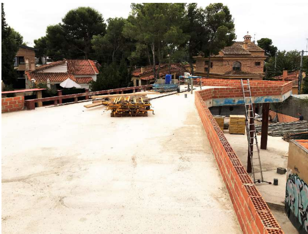
Figura 276 : diario de obra
