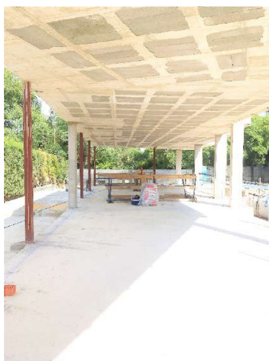
Figura 283 : diario de obra
