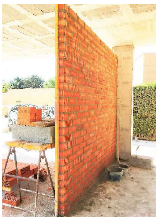
Figura 292 : diario de obra
