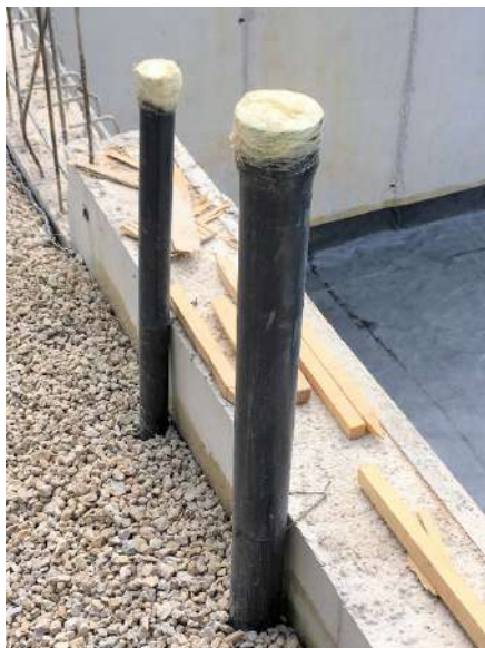
Figura 166 : diario de obra
