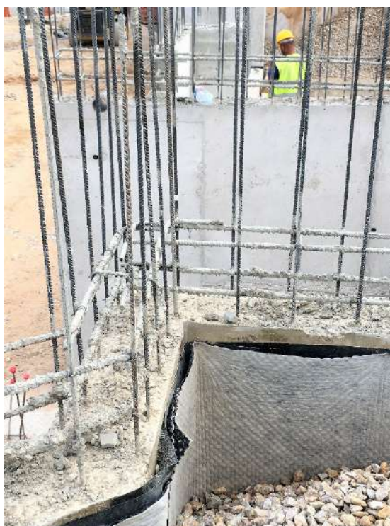
Figura 133 : diario de obra
