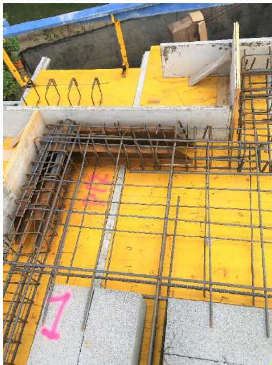
Figura 223 : diario de obra
