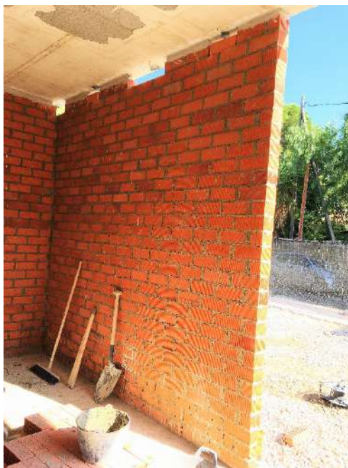
Figura 304 : diario de obra
