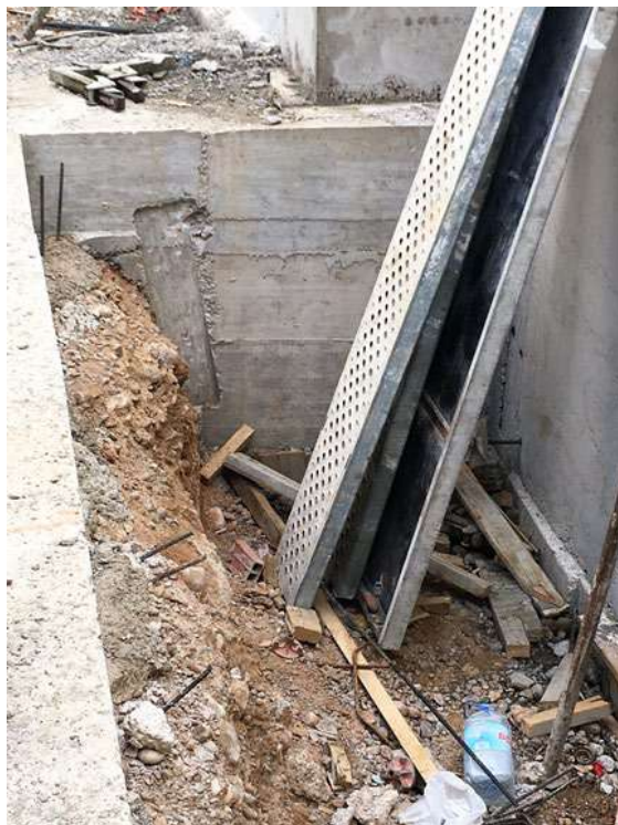
Figura 79 : diario de obra
