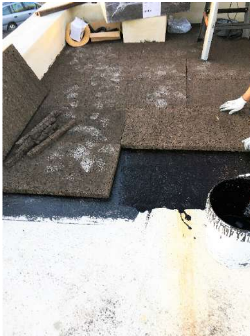
Figura 296 : diario de obra
