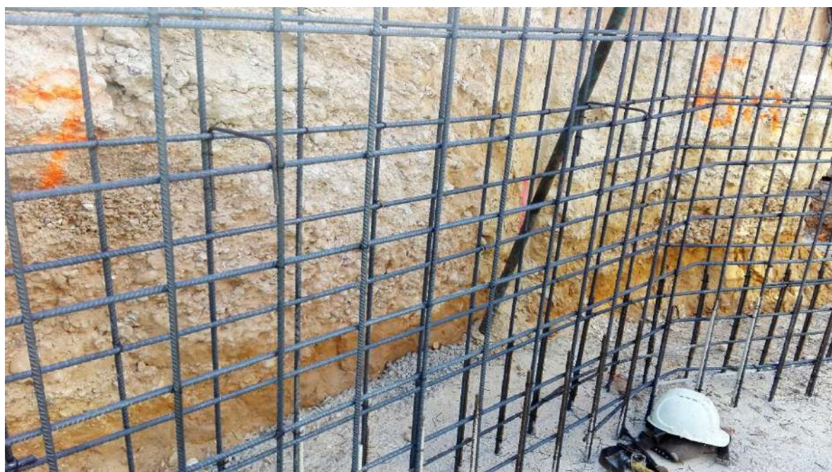
Figura 49: diario de obra
