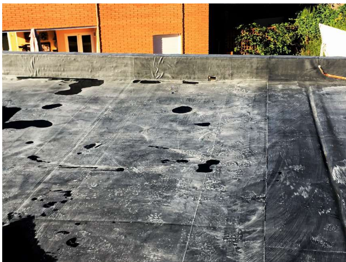
Figura 331 : diario de obra
