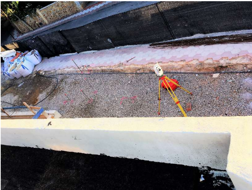
Figura 286 : diario de obra
