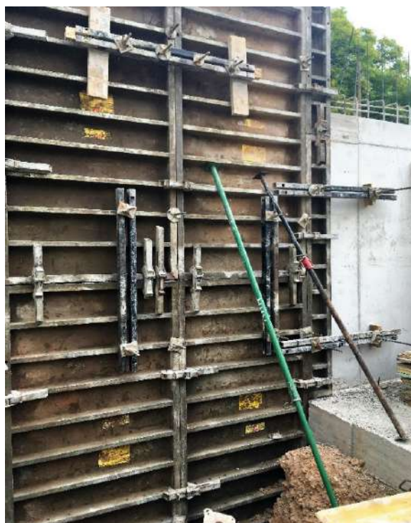
Figura 70: diario de obra
