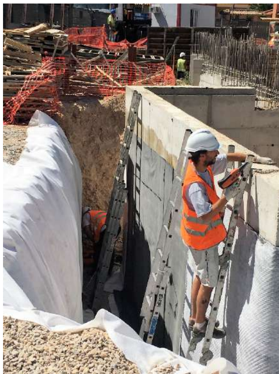
Figura 122: diario de obra
