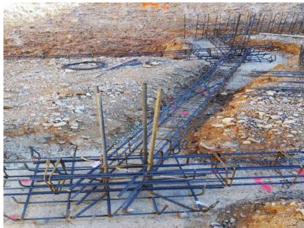
Figura 14: Diario de obra
