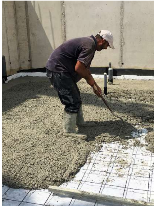
Figura 189 : diario de obra
