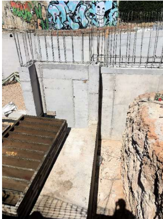
Figura 114 : diario de obra
