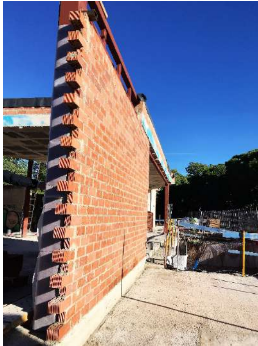
Figura 320 : diario de obra
