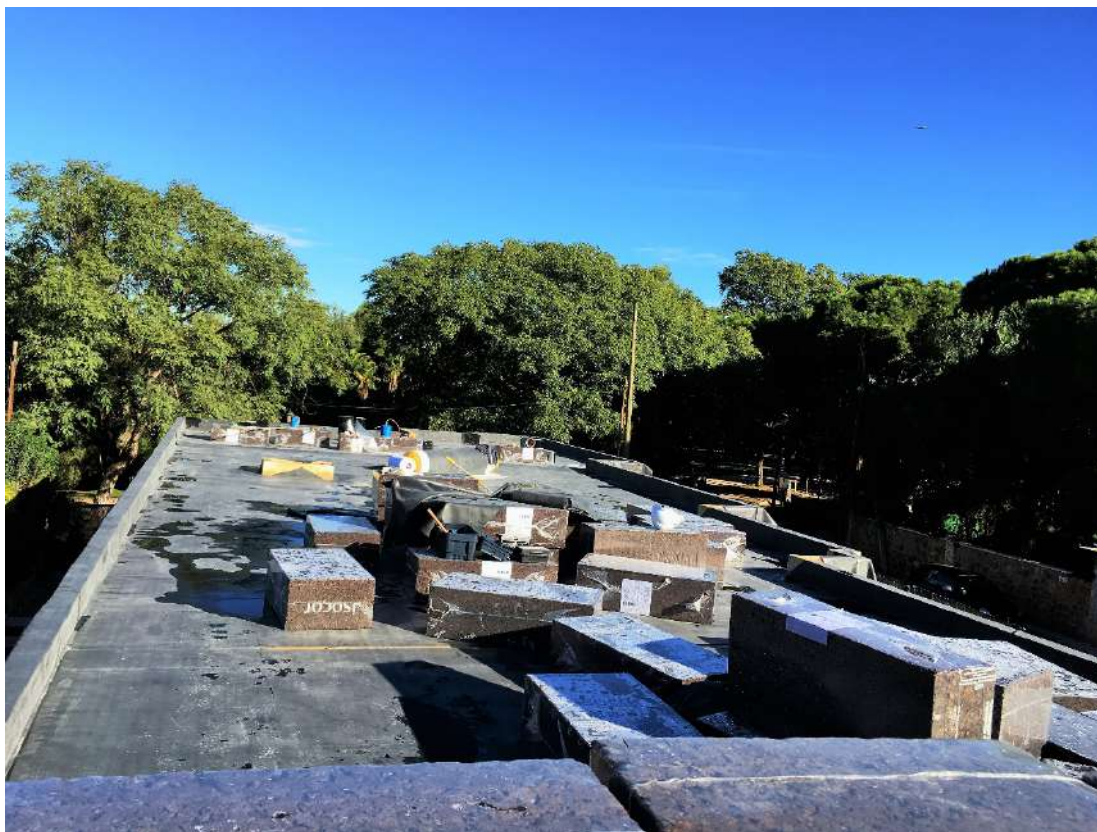
Figura 328 : diario de obra
