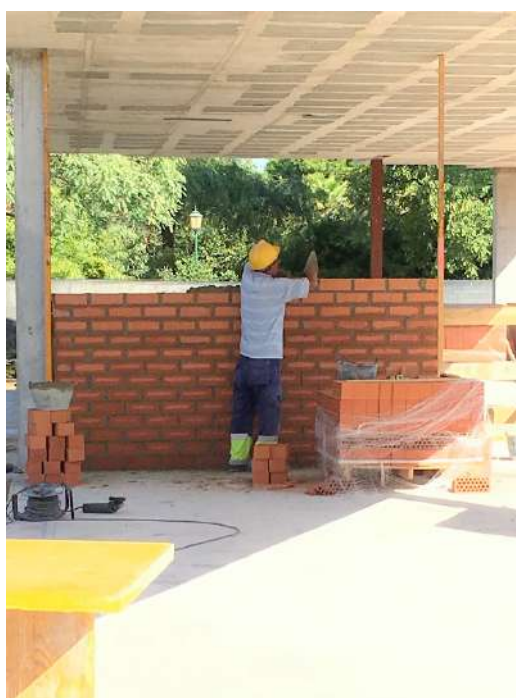
Figura 290 : diario de obra
