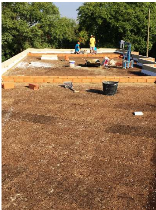
Figura 308 : diario de obra
