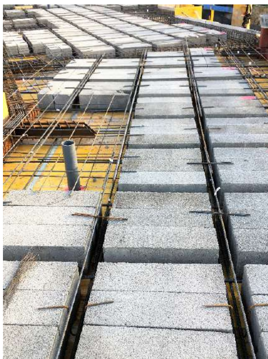
Figura 213 : diario de obra
