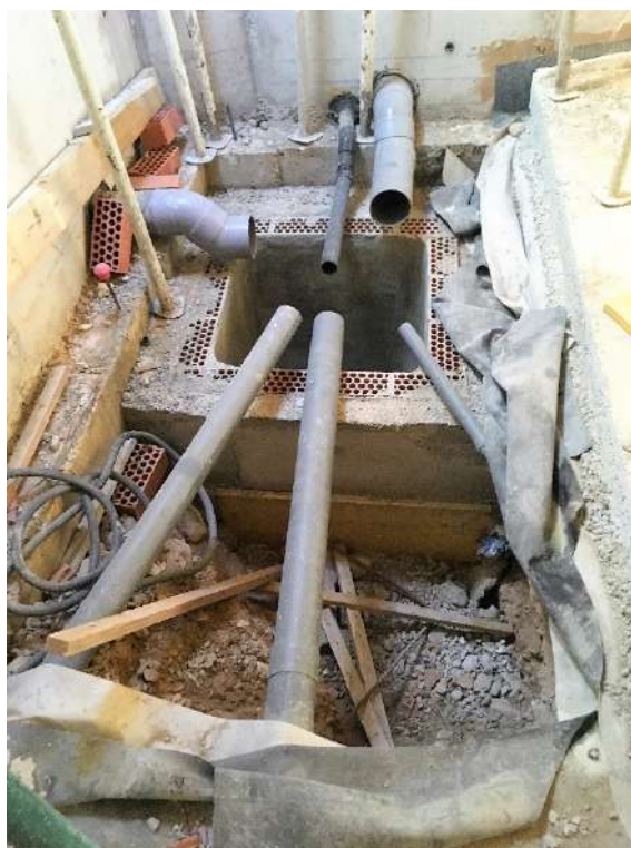
Figura 209 : diario de obra
