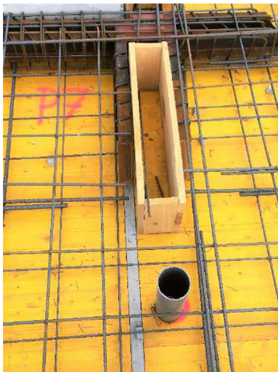
Figura 225 : diario de obra
