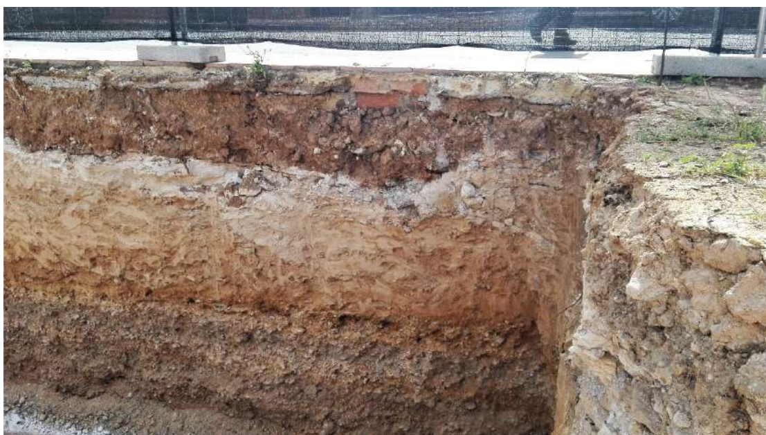
Figura 10 : diario de obra
