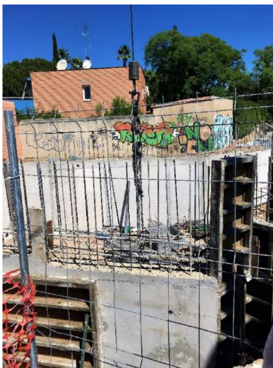
Figura 104 : diario de obra
