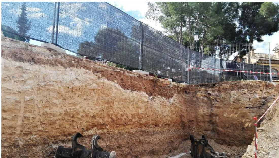
Figura 9: diario de obra
