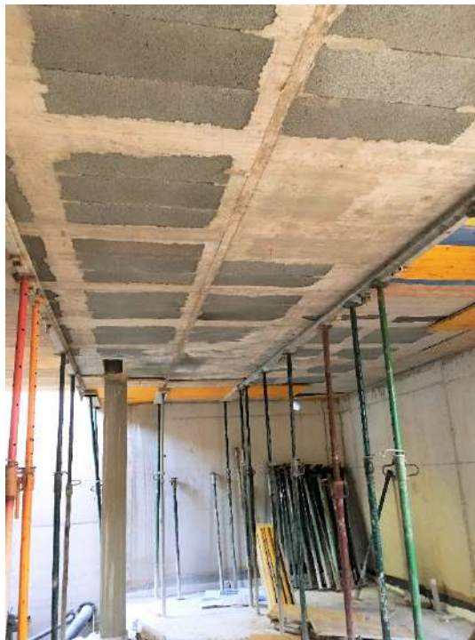
Figura 204 : diario de obra
