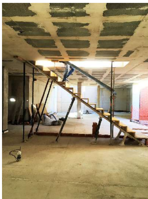
Figura 335 : diario de obra
