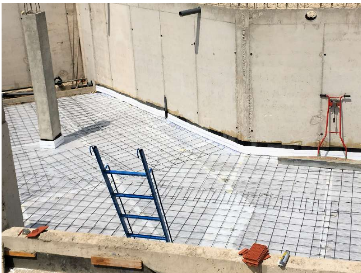
Figura 181 : diario de obra
