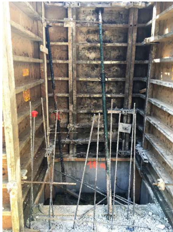
Figura 52 : diario de obra
