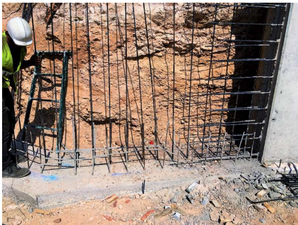
Figura 46: diario de obra
