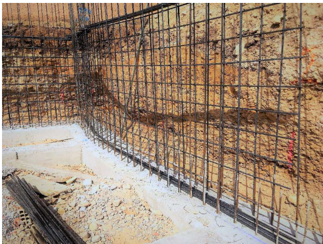
Figura 47: diario de obra
