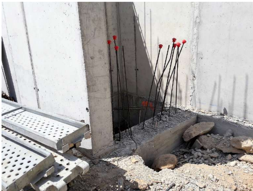
Figura 92 : diario de obra
