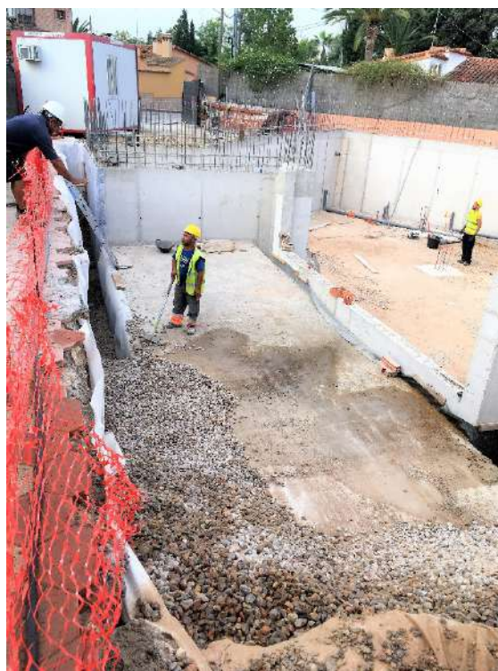
Figura 142 : diario de obra
