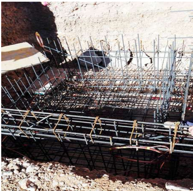
Figura 16: diario de obra
