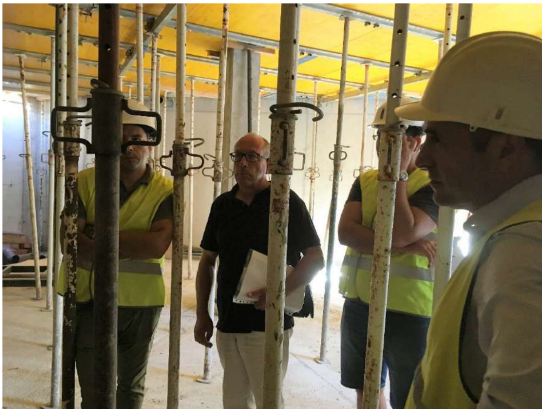
Figura 208 : diario de obra
