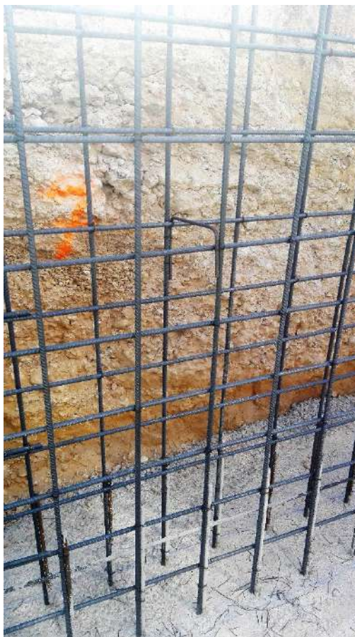
Figura 29 : diario de obra
