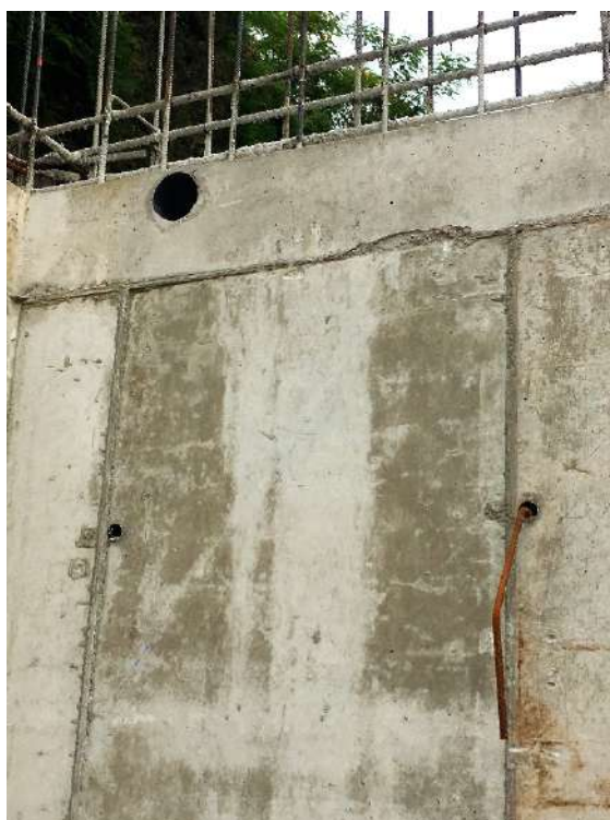
Figura 80 : diario de obra
