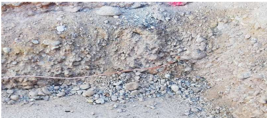
Figura 12 : diario de obra
