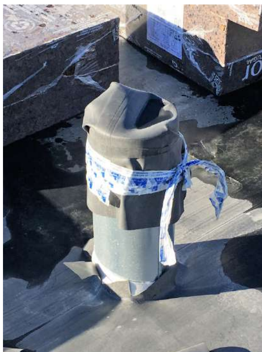
Figura 330 : diario de obra
