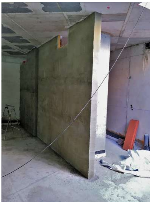
Figura 322 : diario de obra
