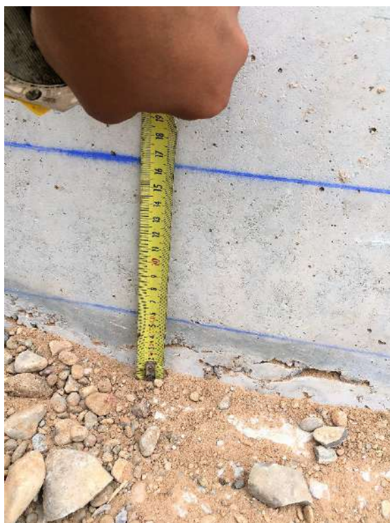
Figura 162: diario de obra
