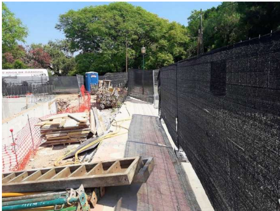
Figura 87 : diario de obra
