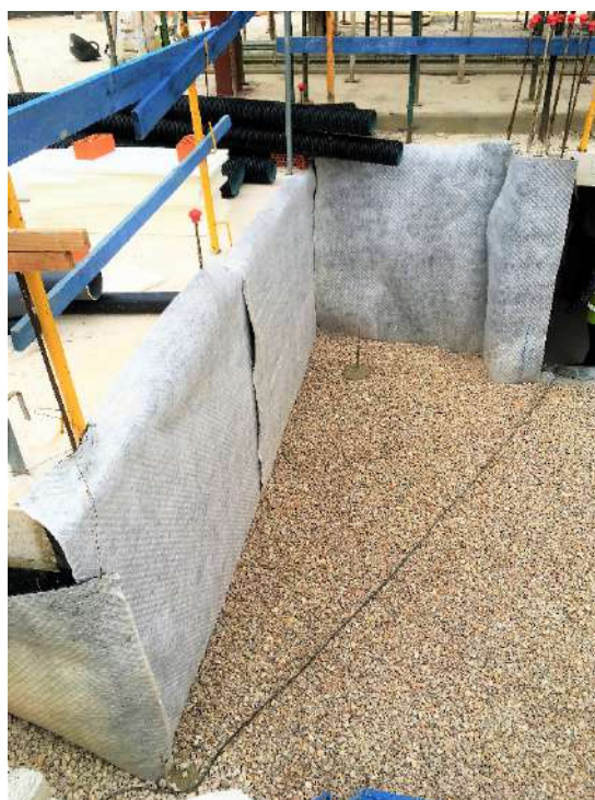
Figura 251 : diario de obra
