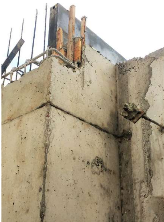
Figura 74 : diario de obra
