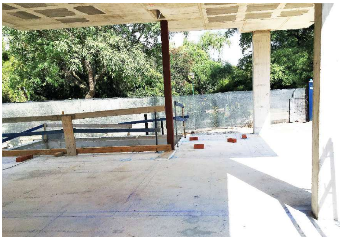
Figura 282 : diario de obra
