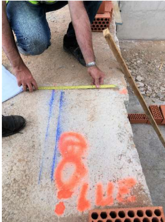
Figura 156 : diario de obra
