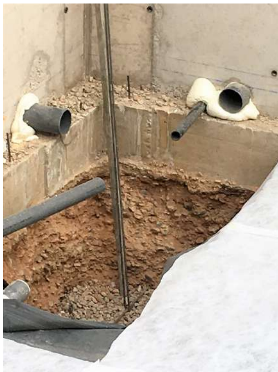
Figura 179 : diario de obra
