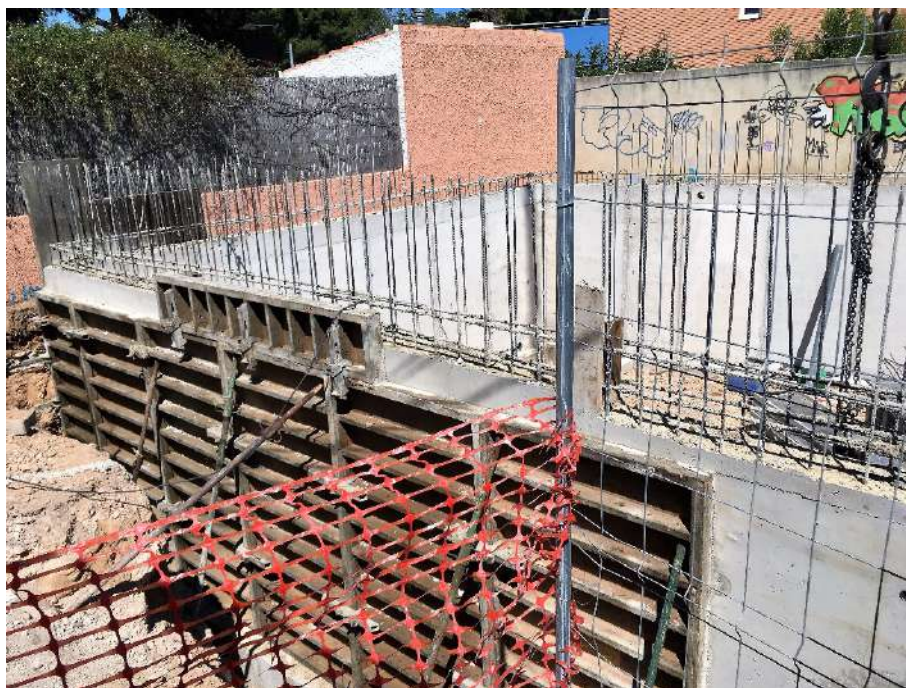
Figura 102 : diario de obra
