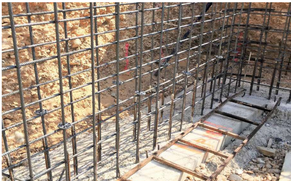
Figura 55 : diario de obra
