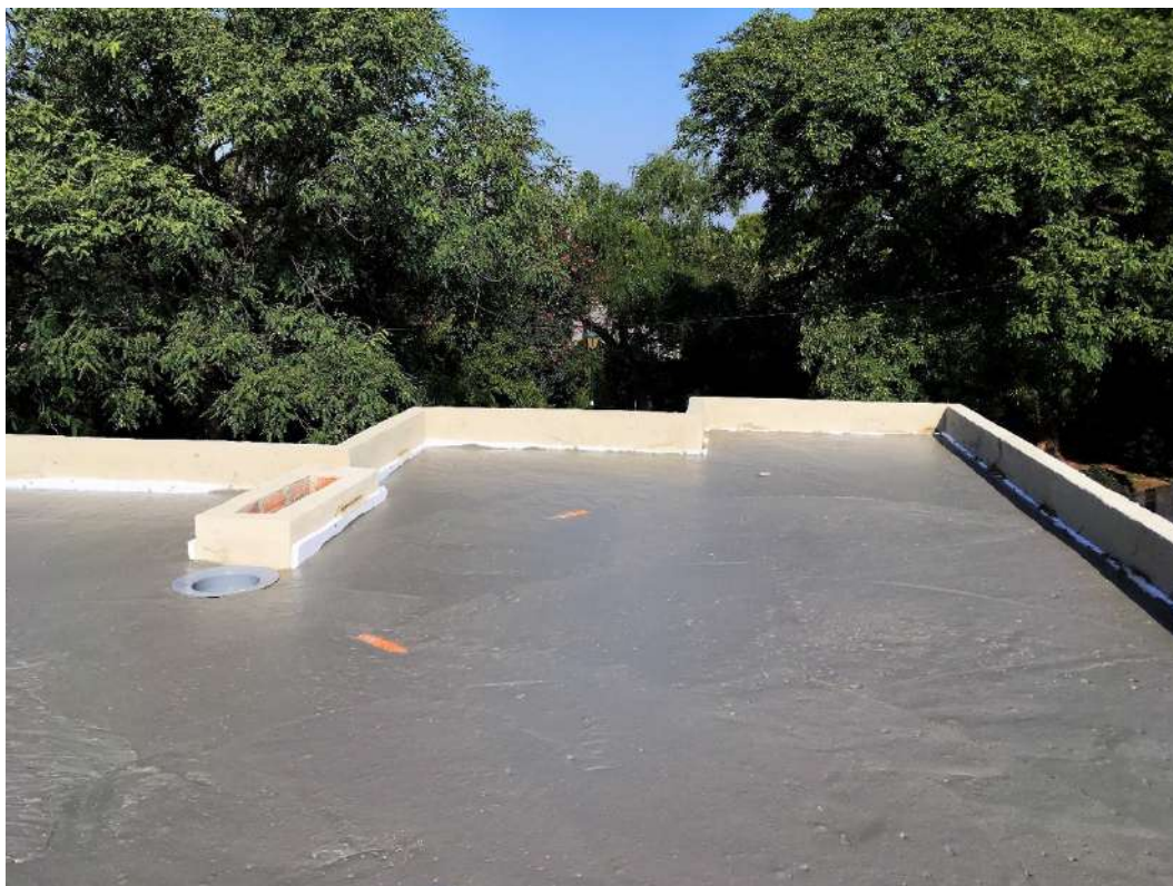
Figura 314 : diario de obra
