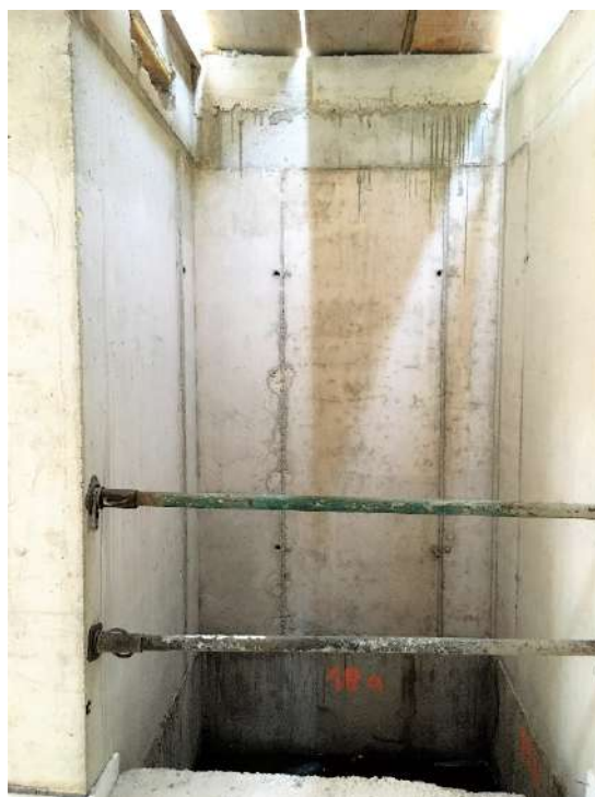
Figura 258 : diario de obra
