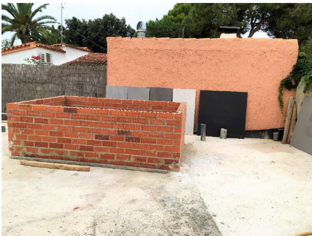
Figura 245 : diario de obra
