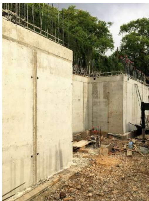
Figura 65 : diario de obra
