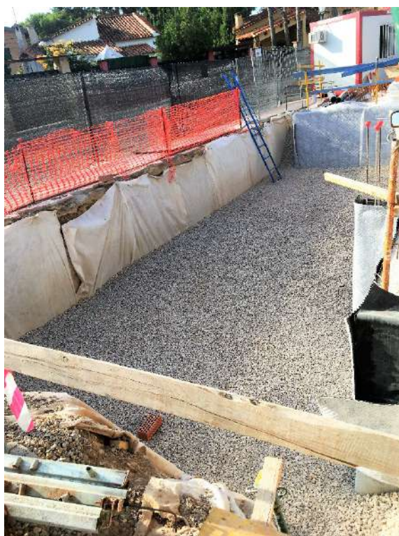
Figura 236 : diario de obra
