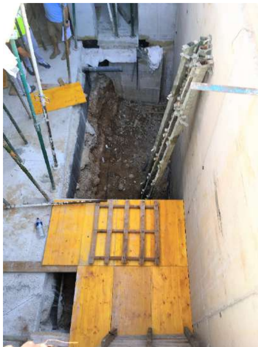
Figura 195 : diario de obra
