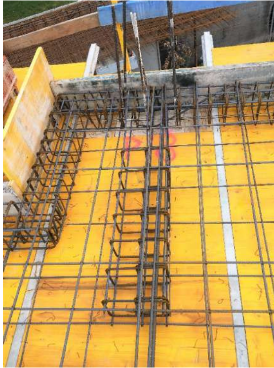
Figura 219 : diario de obra
