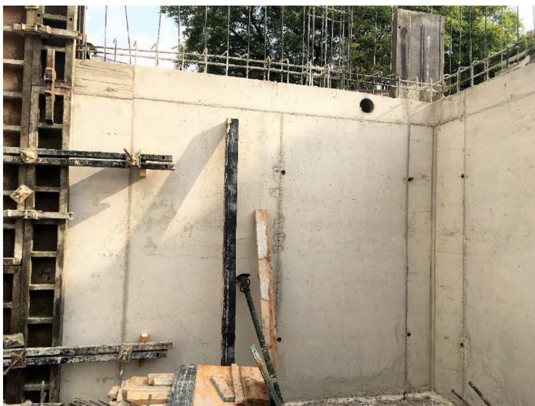
Figura 71 : diario de obra
