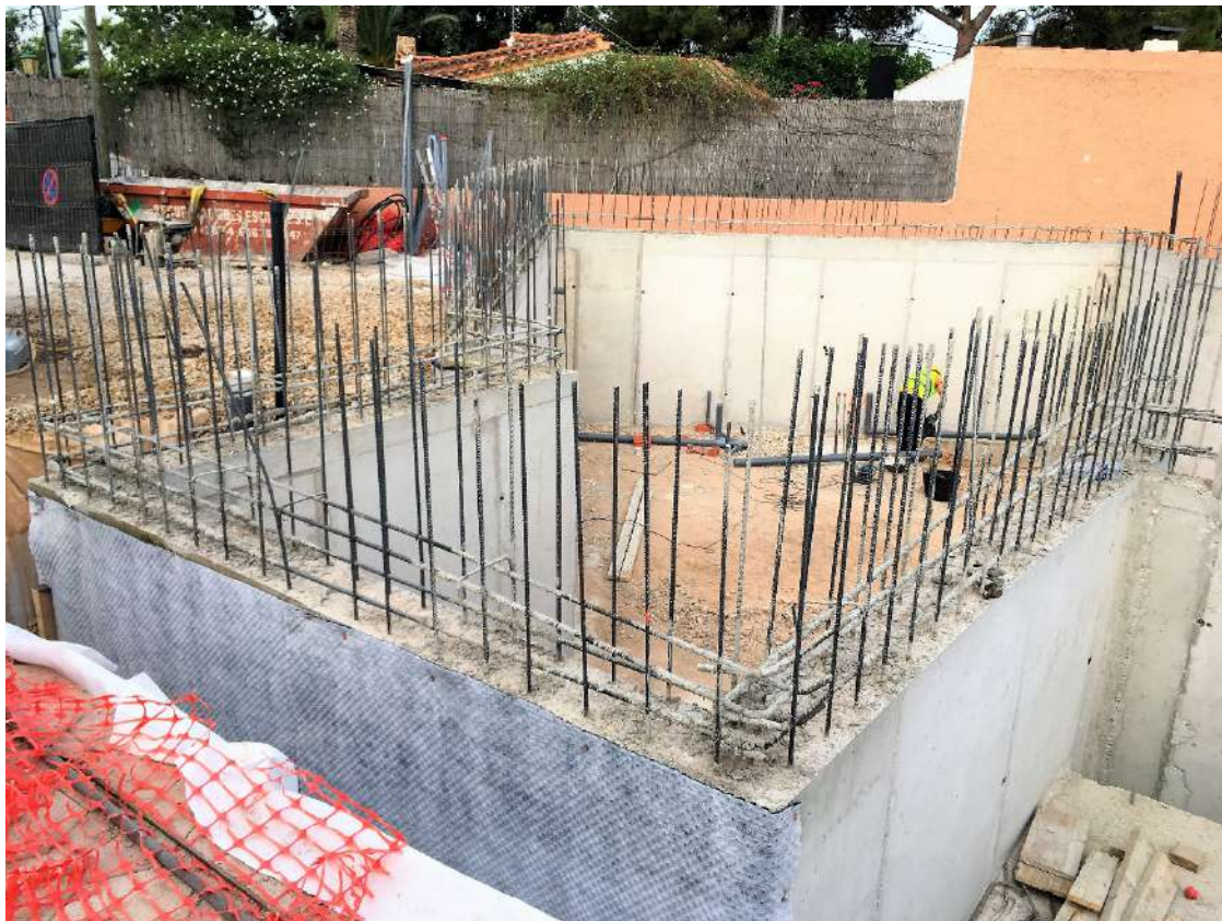
Figura 137: diario de obra
