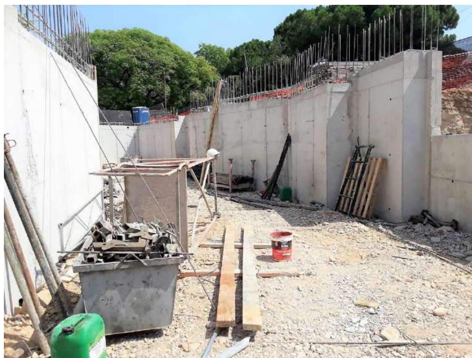
Figura 97 : diario de obra
