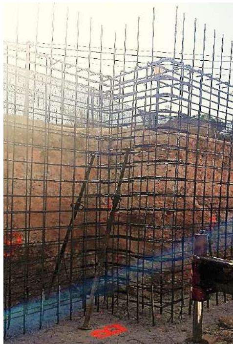
Figura 26: diario de obra
