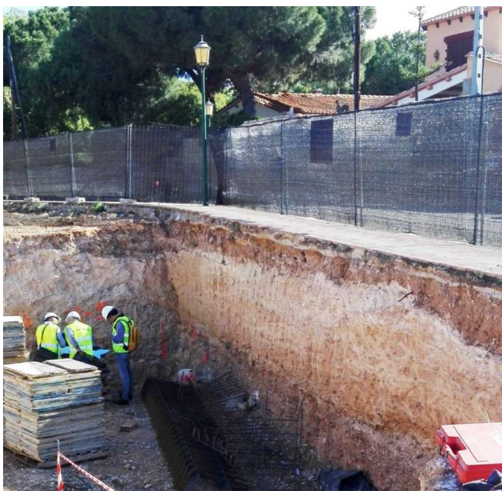
Figura 21: diario de obra
