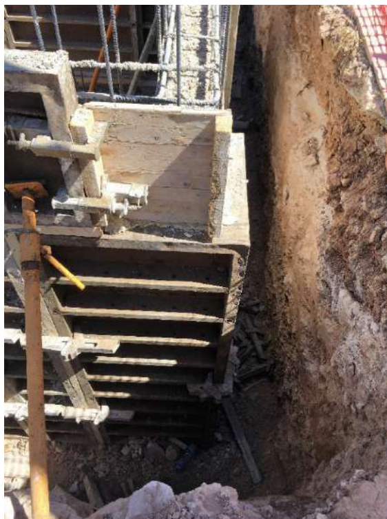
Figura 110 : diario de obra
