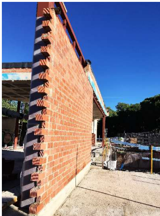
Figura 333 : diario de obra
