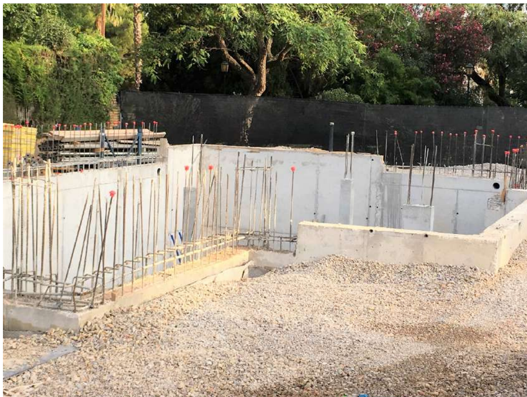
Figura 173 : diario de obra
