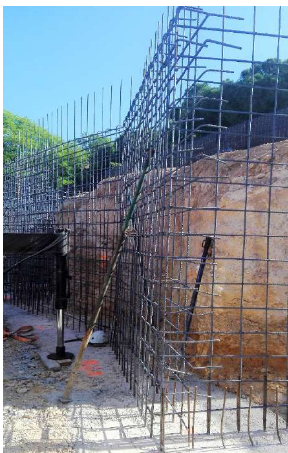
Figura 34 : diario de obra
