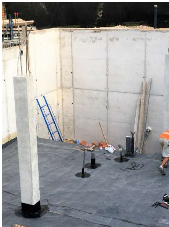
Figura 175 : diario de obra
