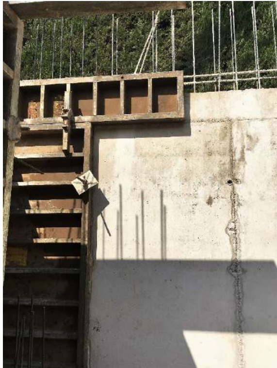
Figura 50: diario de obra
