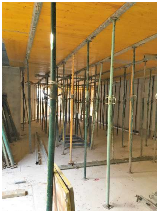
Figura 206 : diario de obra
