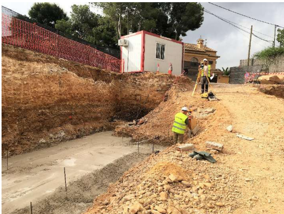
Figura 64 : diario de obra
