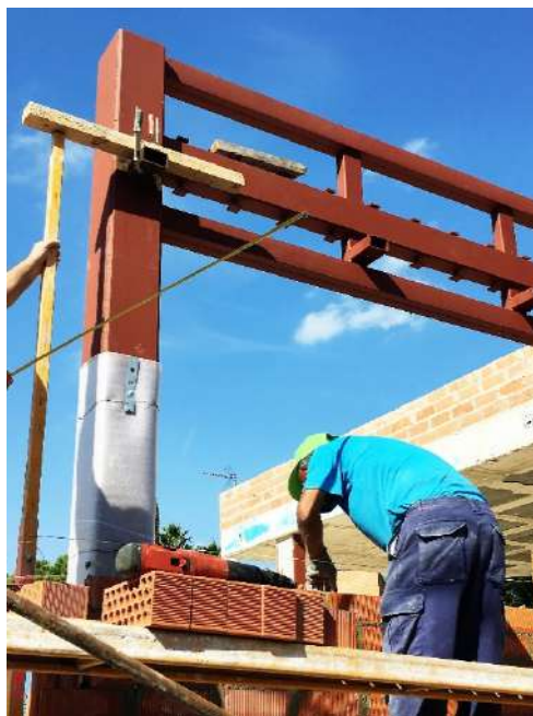
Figura 317 : diario de obra
