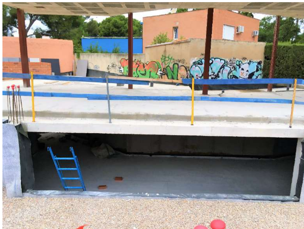
Figura 264 : diario de obra
