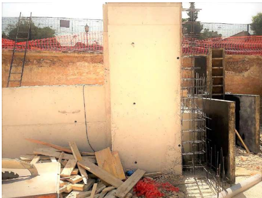
Figura 96 : diario de obra
