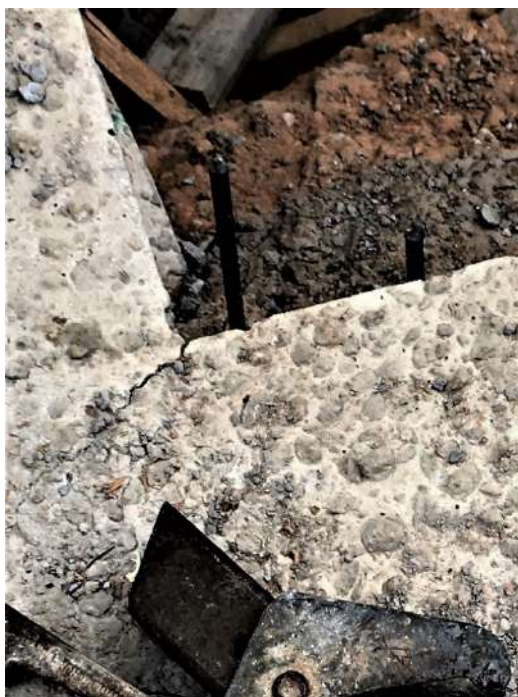
Figura 72 : diario de obra
