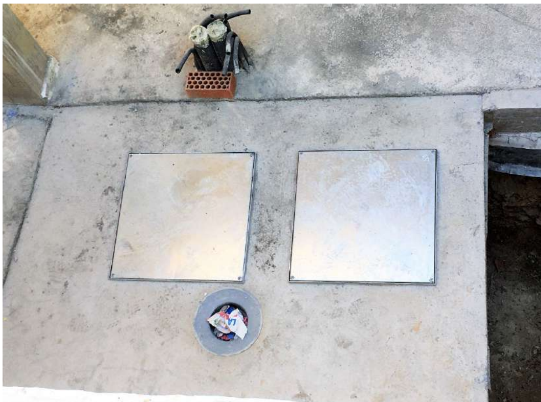
Figura 289 : diario de obra
