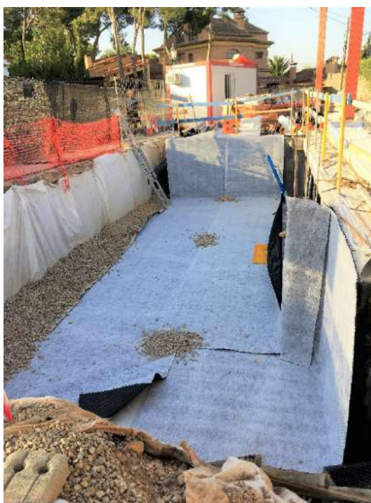
Figura 199 : diario de obra
