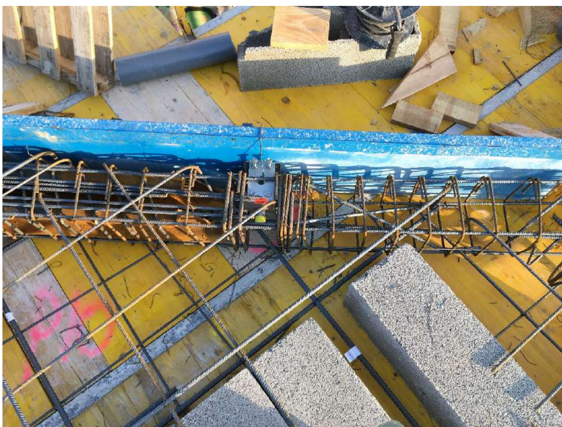
Figura 216 : diario de obra
