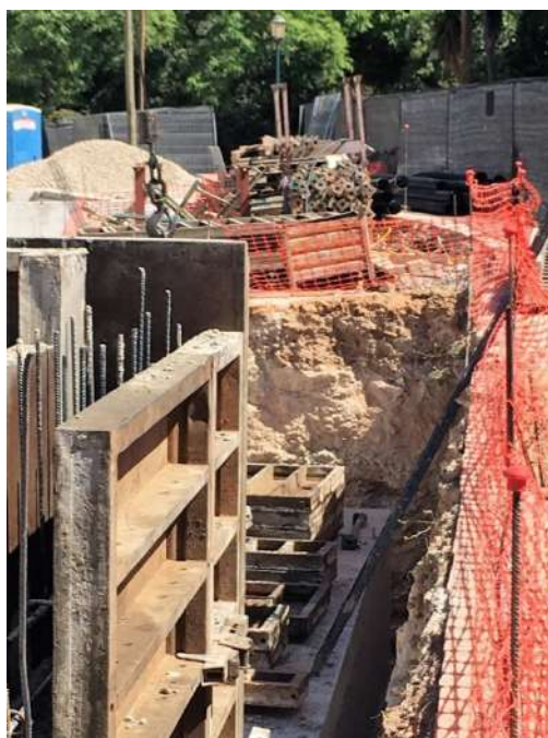
Figura 113 : diario de obra
