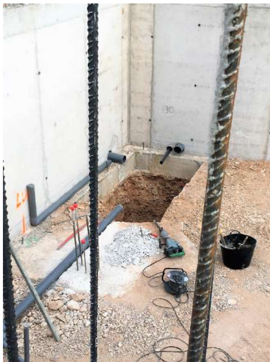
Figura 132 : diario de obra
