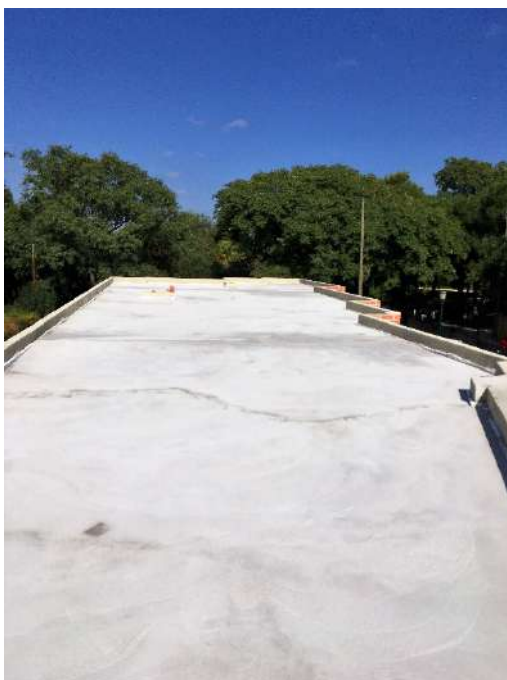
Figura 337 : diario de obra
