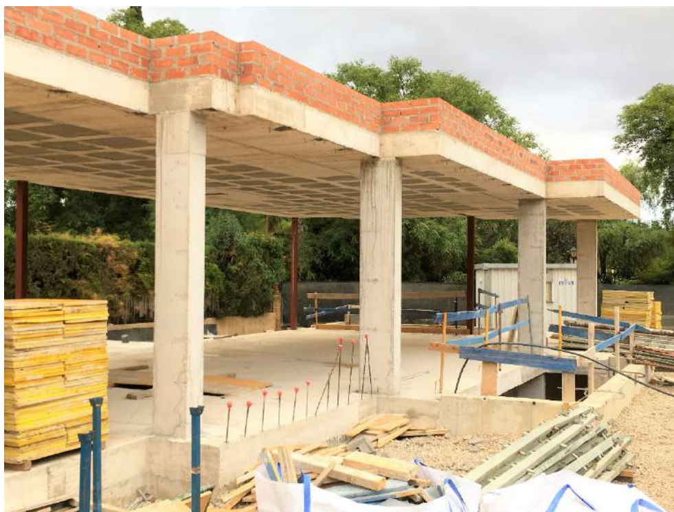
Figura 265 : diario de obra
