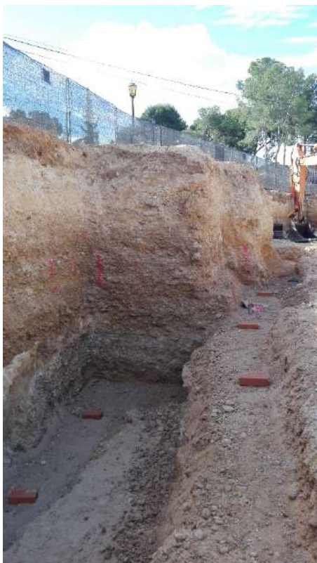
Figura 5: diario de obra
