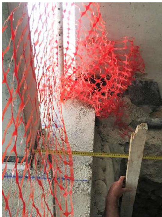
Figura 278 : diario de obra
