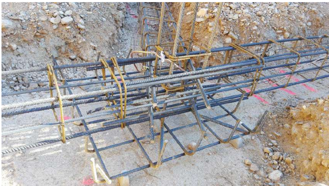
Figura 19: diario de obra
