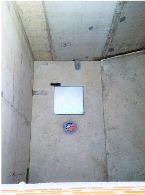
Figura 287 : diario de obra
