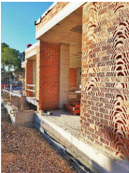
Figura 336 : diario de obra
