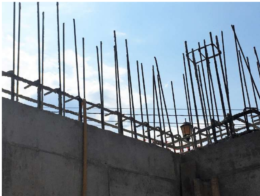
Figura 48: diario de obra
