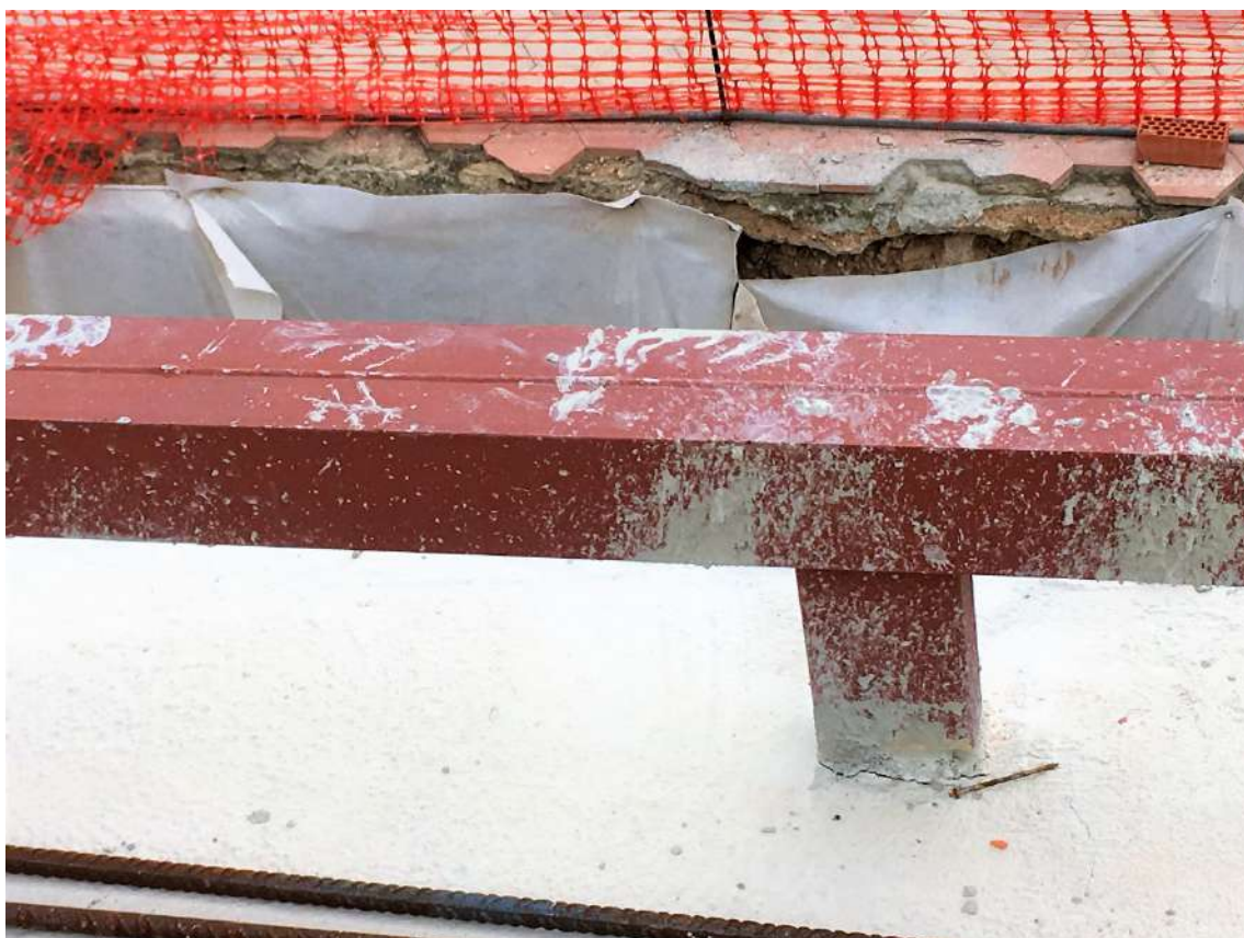
Figura 275 : diario de obra
