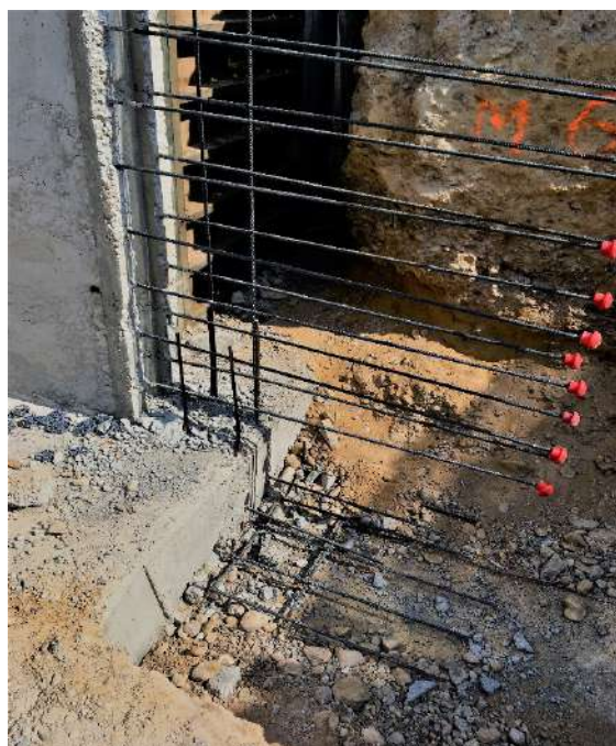
Figura 38 : diario de obra
