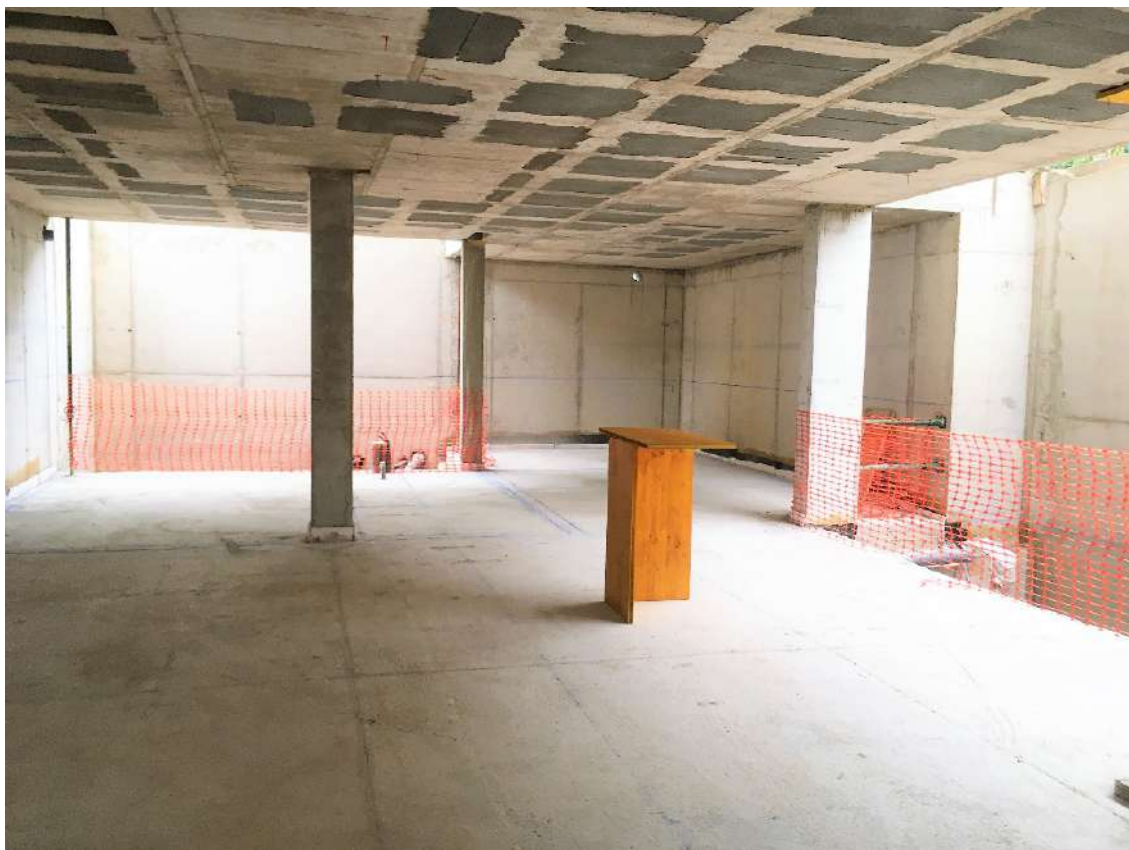
Figura 256 : diario de obra
