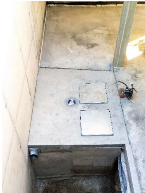
Figura 288 : diario de obra
