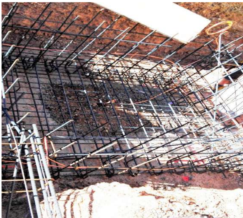
Figura 18: diario de obra
