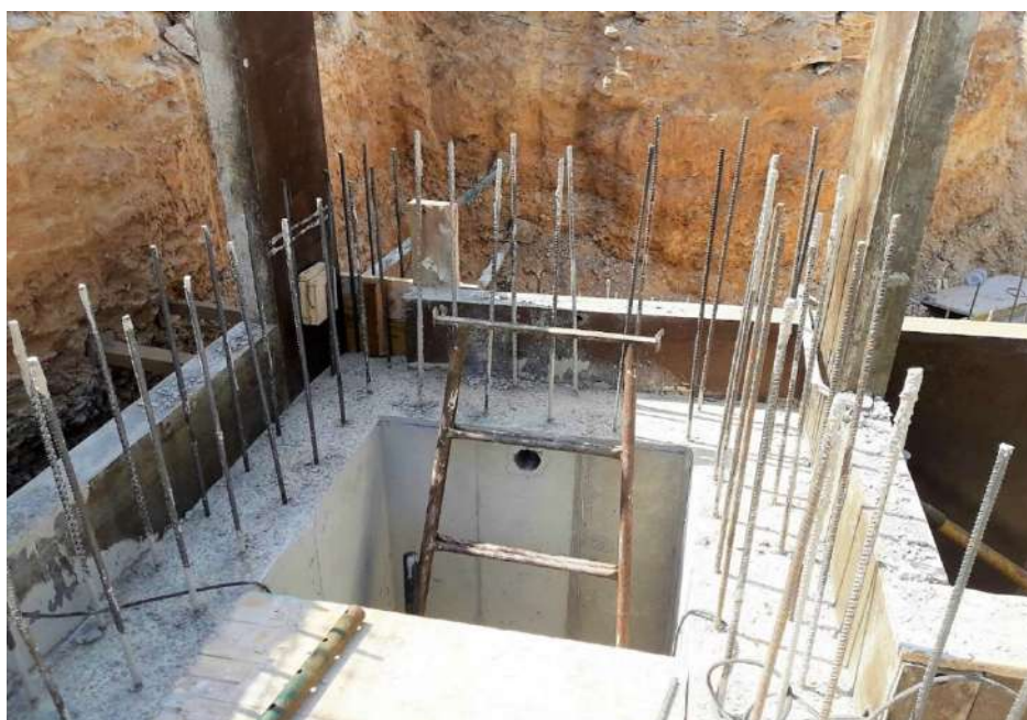
Figura 101 : diario de obra
