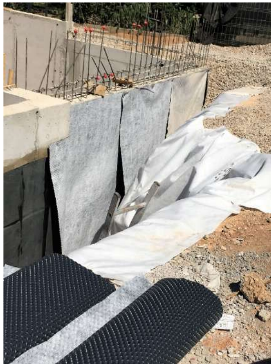
Figura 119 : diario de obra
