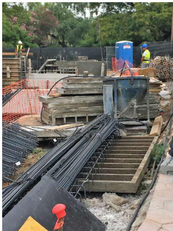
Figura 81: diario de obra
