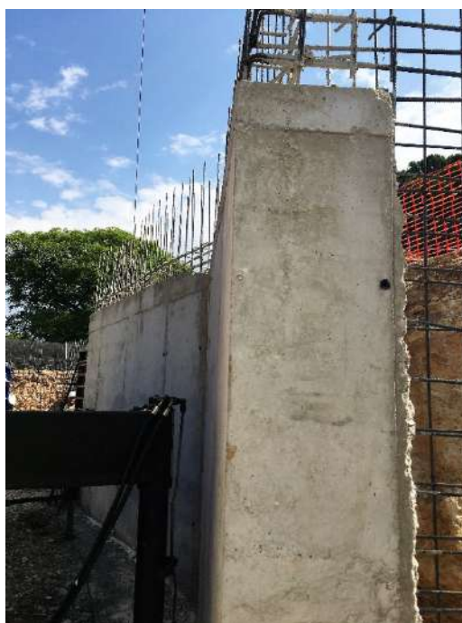
Figura 40: diario de obra
