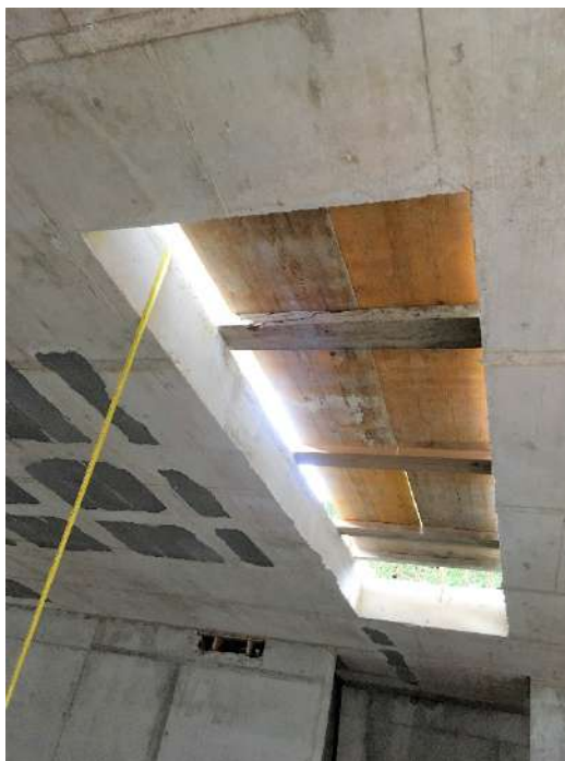
Figura 273 : diario de obra
