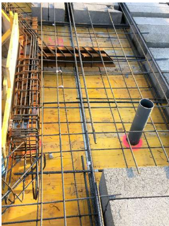
Figura 217 : diario de obra
