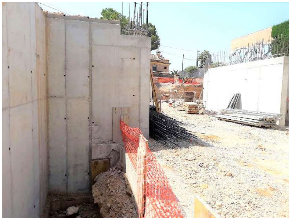
Figura 88 : diario de obra
