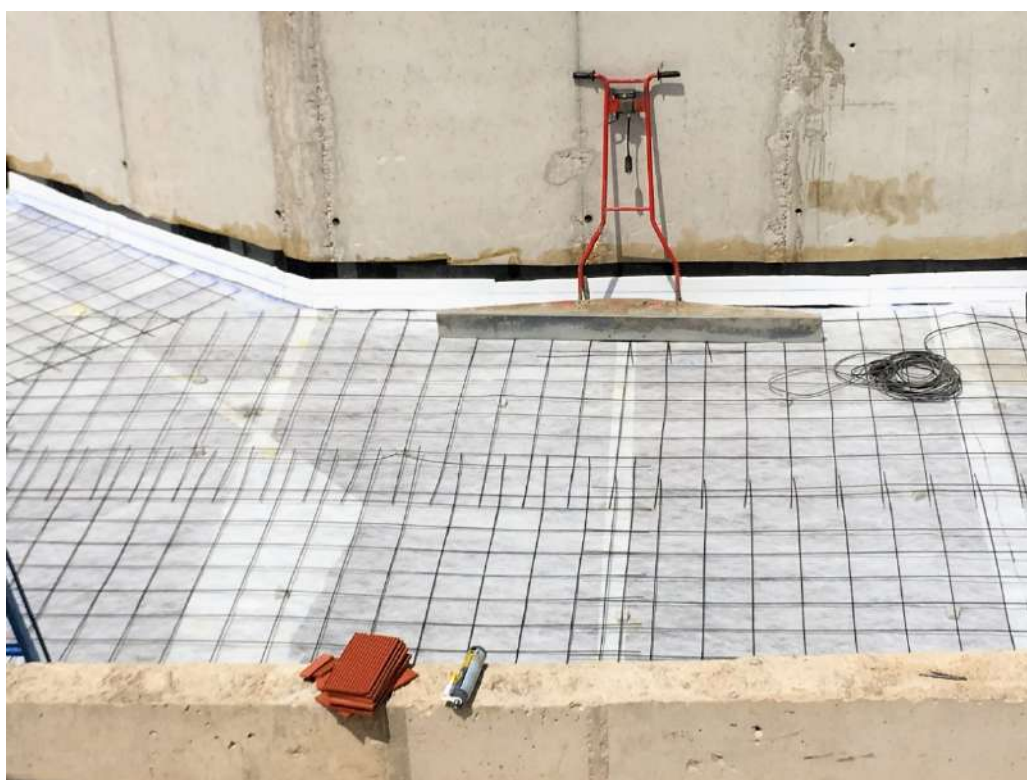
Figura 182 : diario de obra
