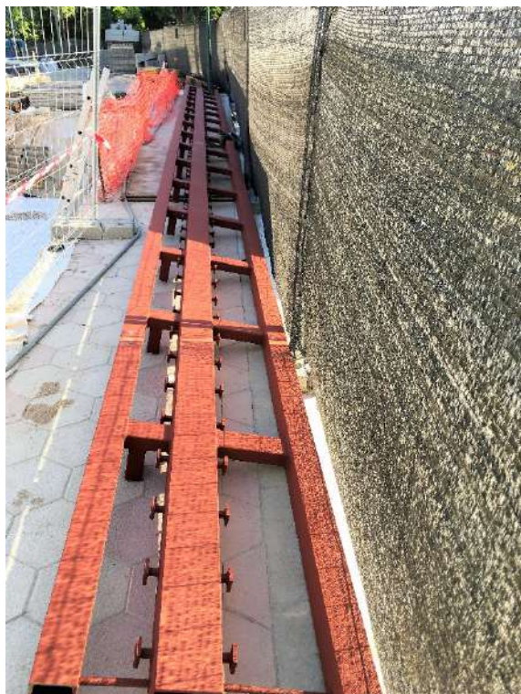
Figura 210 : diario de obra
