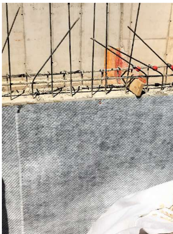
Figura 123 : diario de obra
