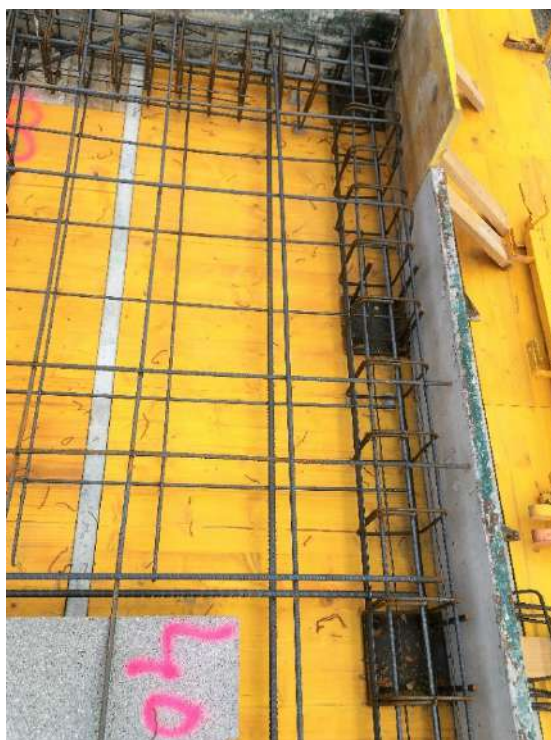
Figura 218 : diario de obra
