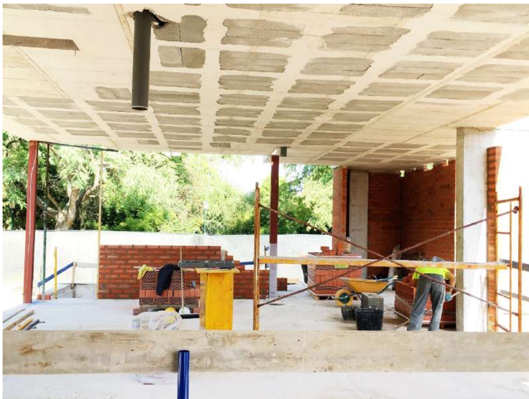
Figura 306 : diario de obra
