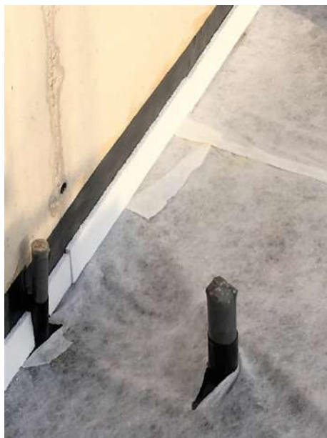
Figura 167 : diario de obra
