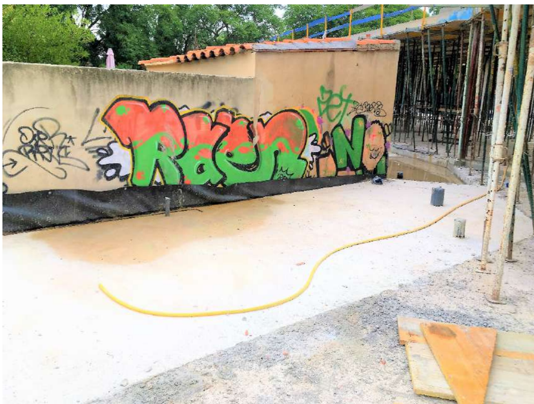
Figura 244 : diario de obra
