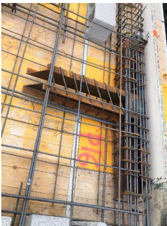
Figura 224 : diario de obra
