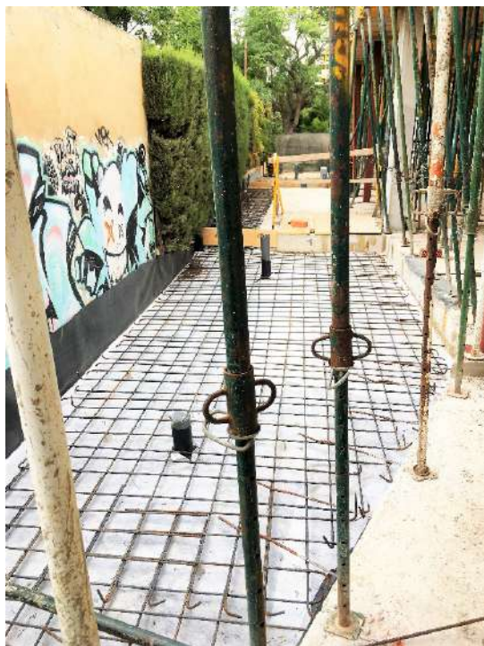
Figura 240 : diario de obra
