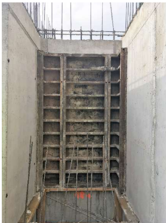
Figura 77: diario de obra
