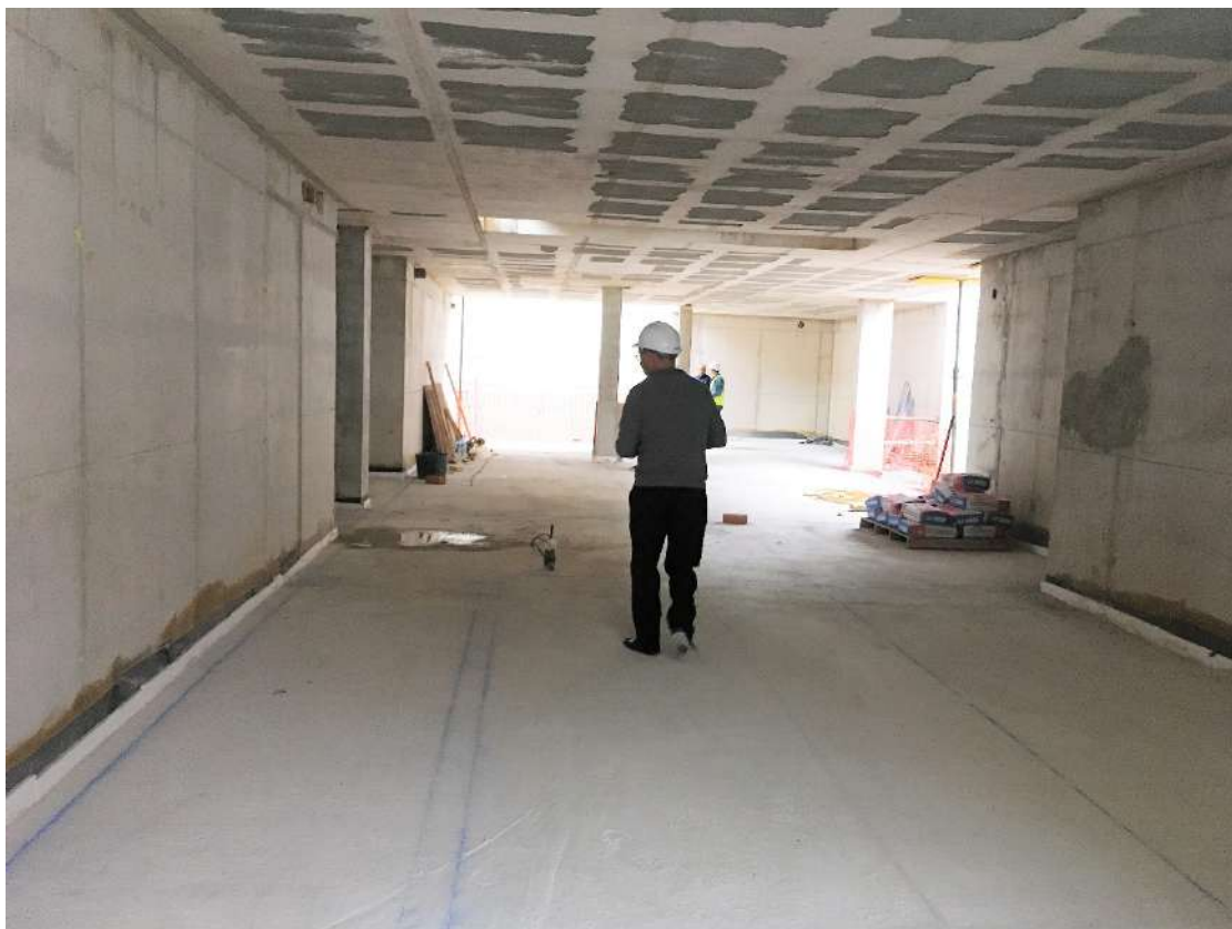
Figura 269 : diario de obra
