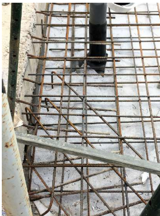
Figura 239 : diario de obra
