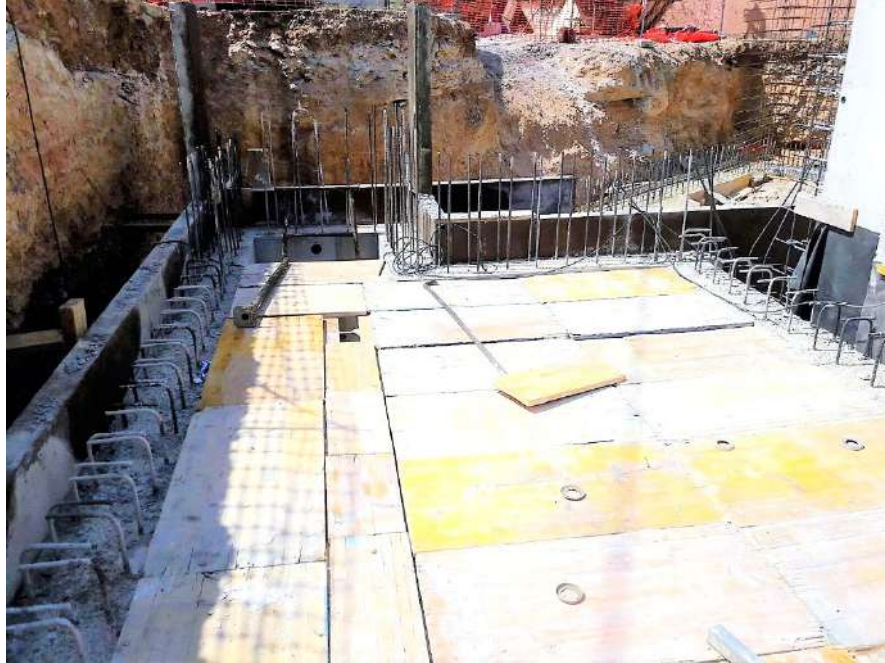
Figura 86 : diario de obra
