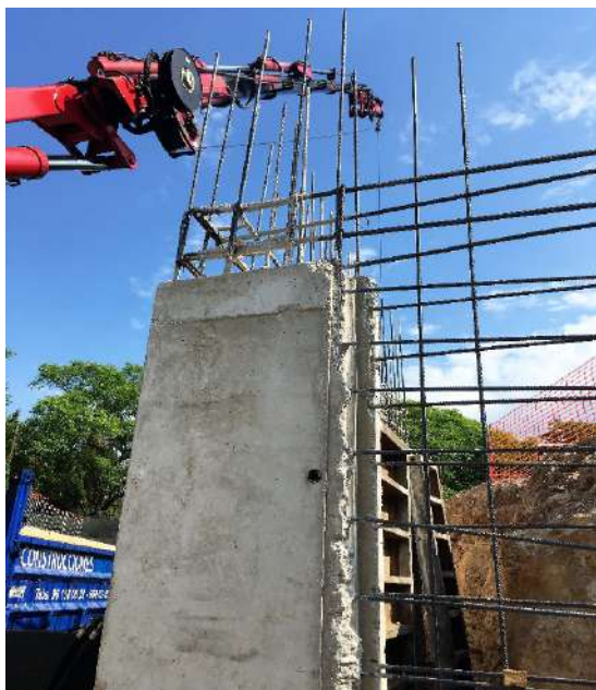
Figura 39: diario de obra
