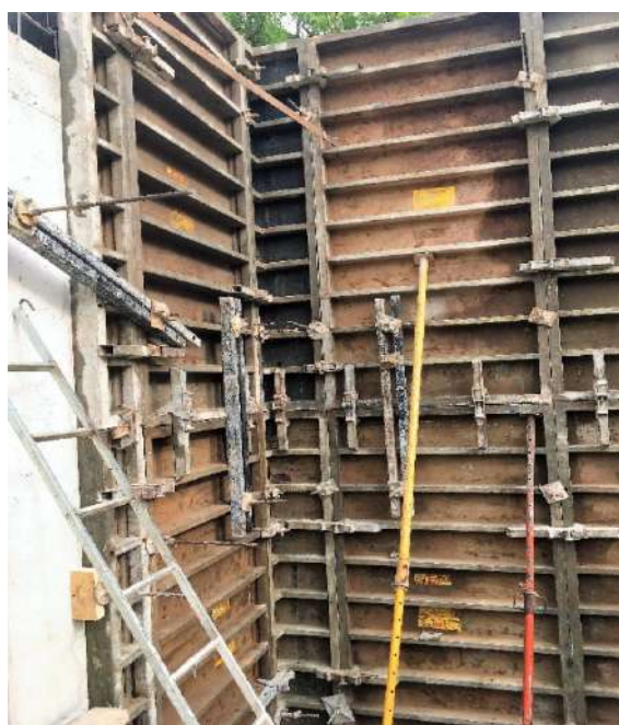
Figura 69: diario de obra
