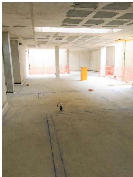
Figura 255 : diario de obra
