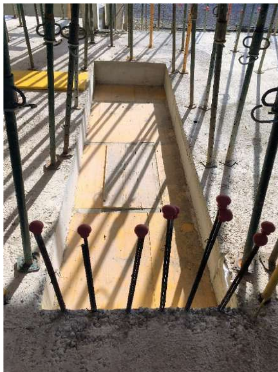
Figura 235 : diario de obra
