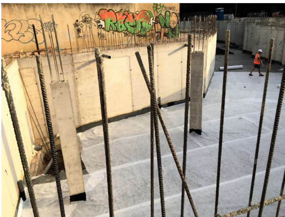
Figura 168 : diario de obra
