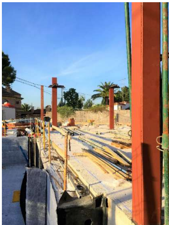
Figura 200 : diario de obra
