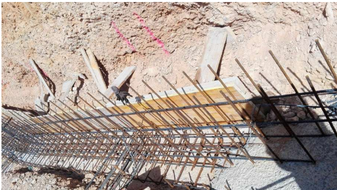
Figura 23: diario de obra
