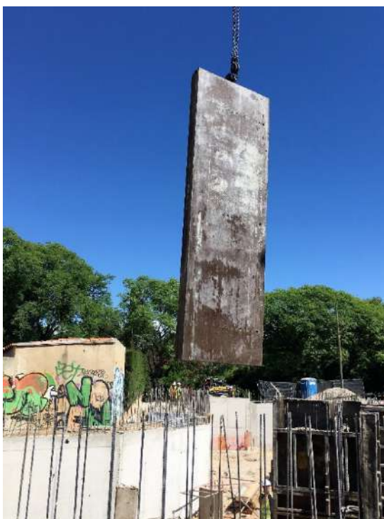
Figura 109 : diario de obra
