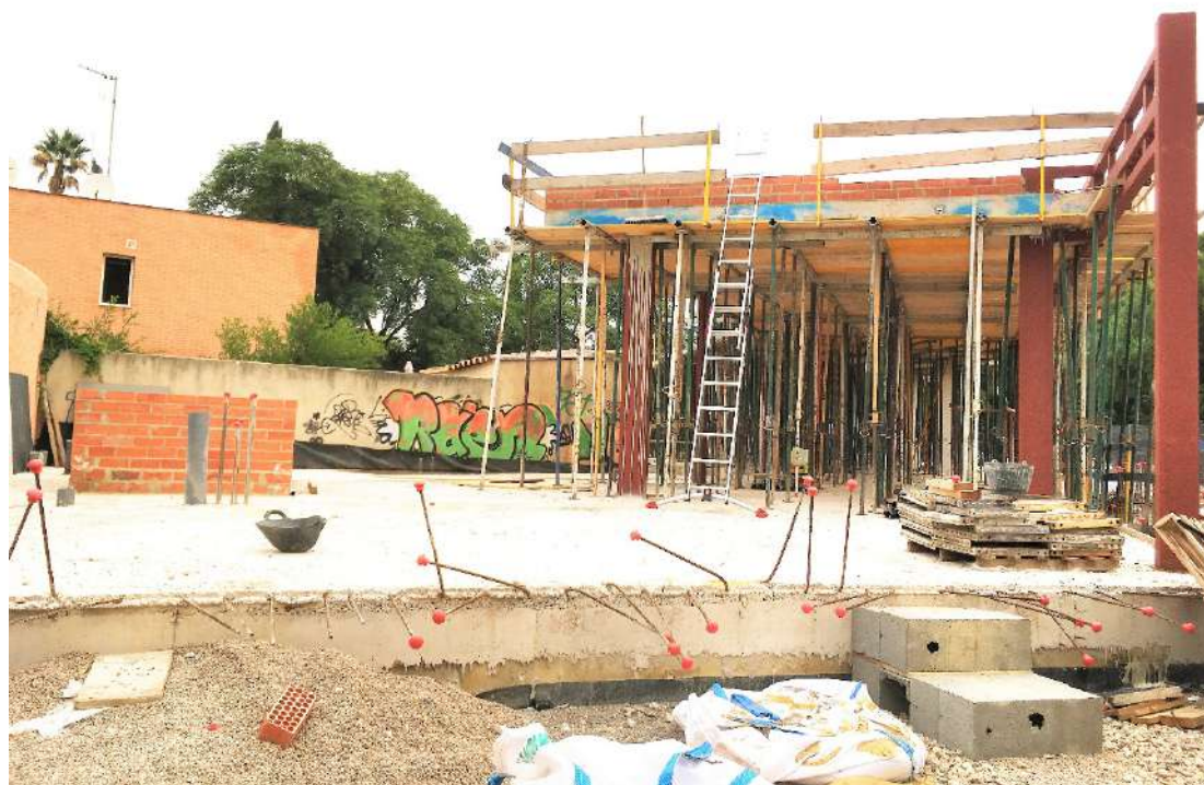
Figura 259 : diario de obra
