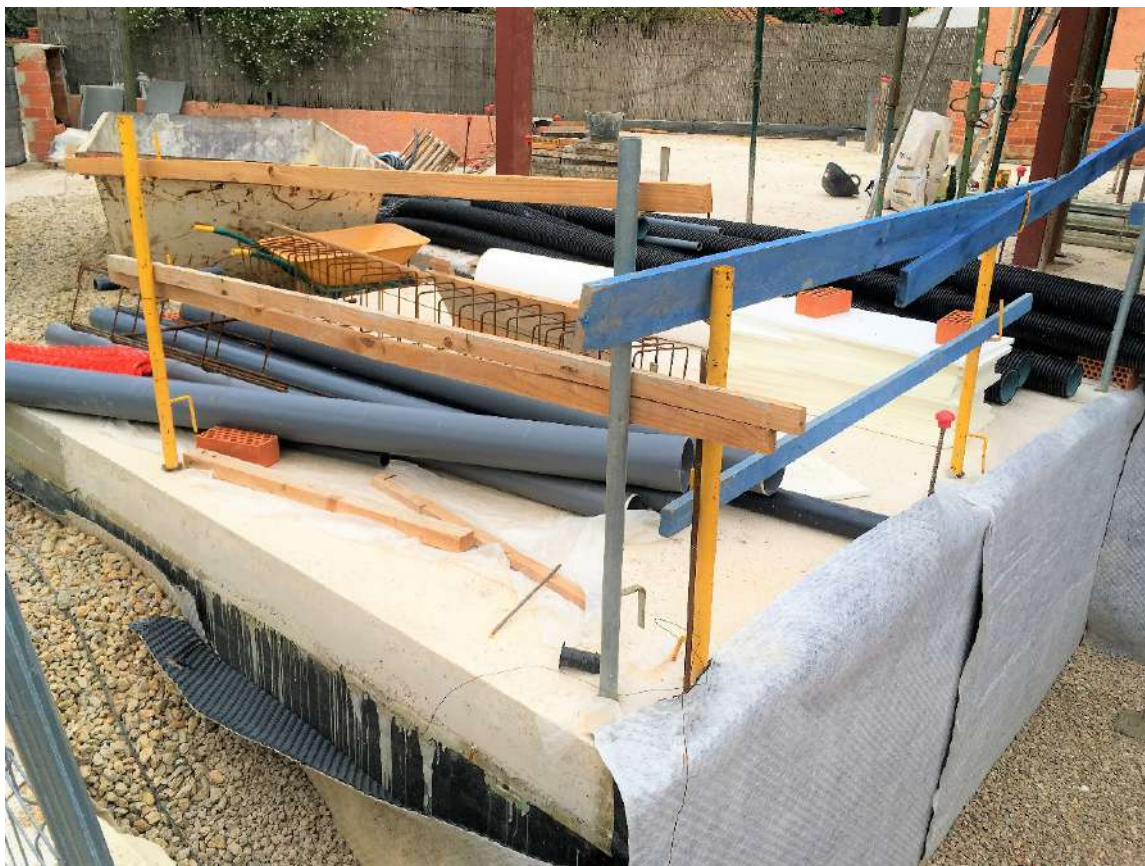
Figura 250 : diario de obra
