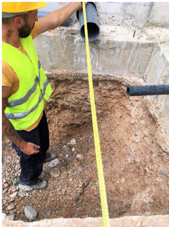
Figura 155 : diario de obra
