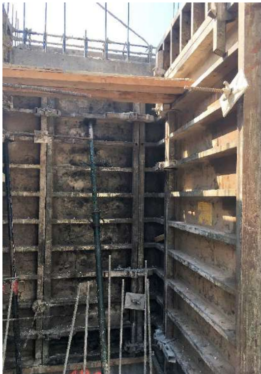
Figura 51: diario de obra
