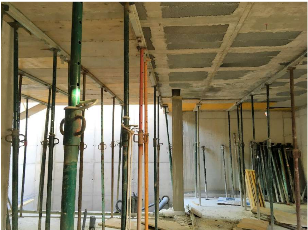
Figura 205 : diario de obra
