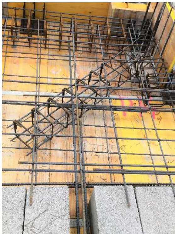
Figura 229 : diario de obra
