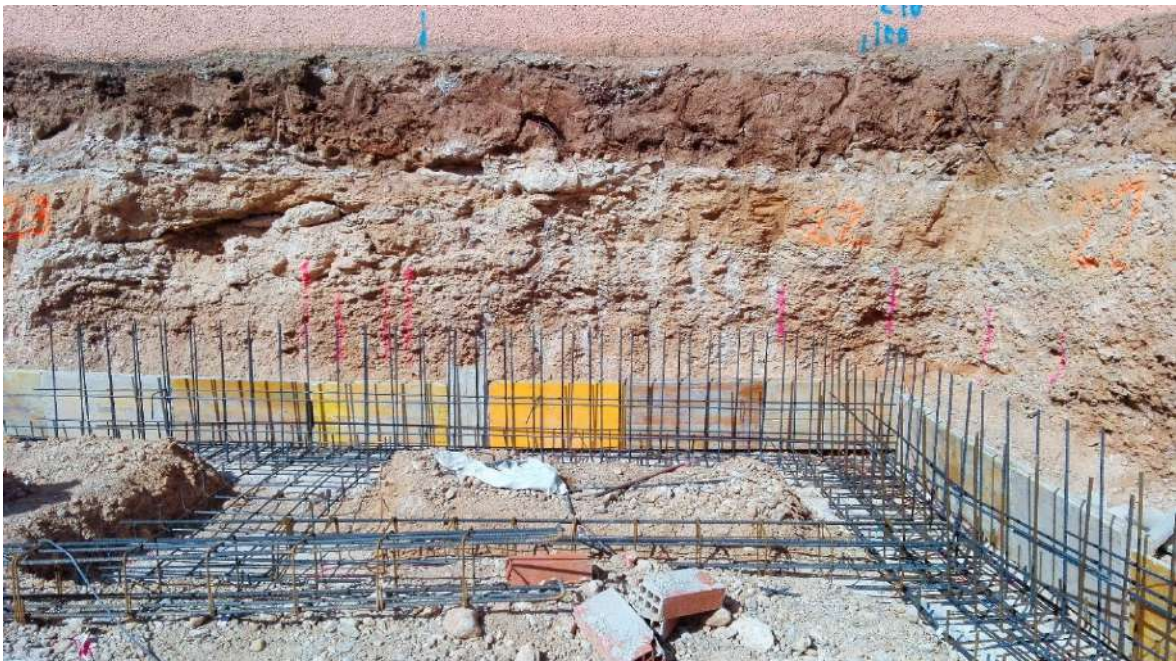
Figura 22: diario de obra
