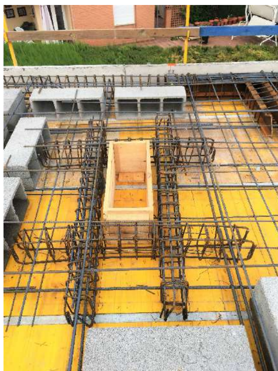
Figura 226 : diario de obra
