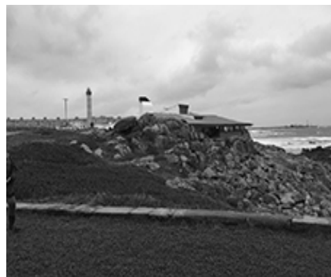
48. Imagen exterior visita a Oporto. Elaboración propia
