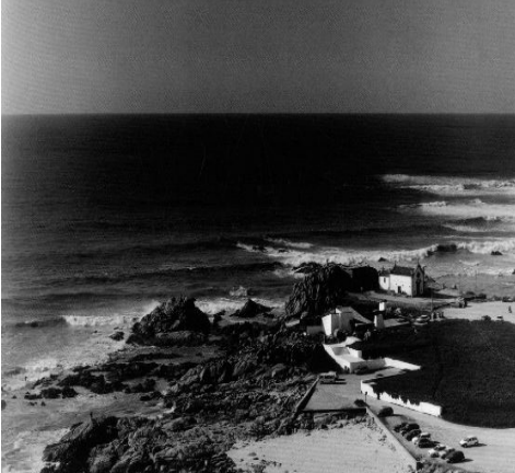
41. Imagen exterior de Restaurante Boa Nova y océano Atlántico. Vista aérea.
