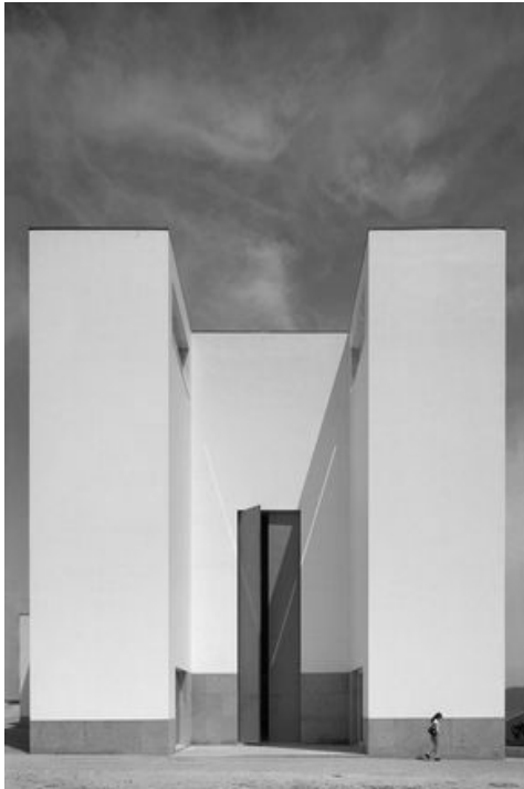
35. Imagen fachada oeste de la Iglesia en Marco de Canaveses.
