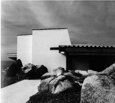
49. Vista de la cubierta desde el acceso
