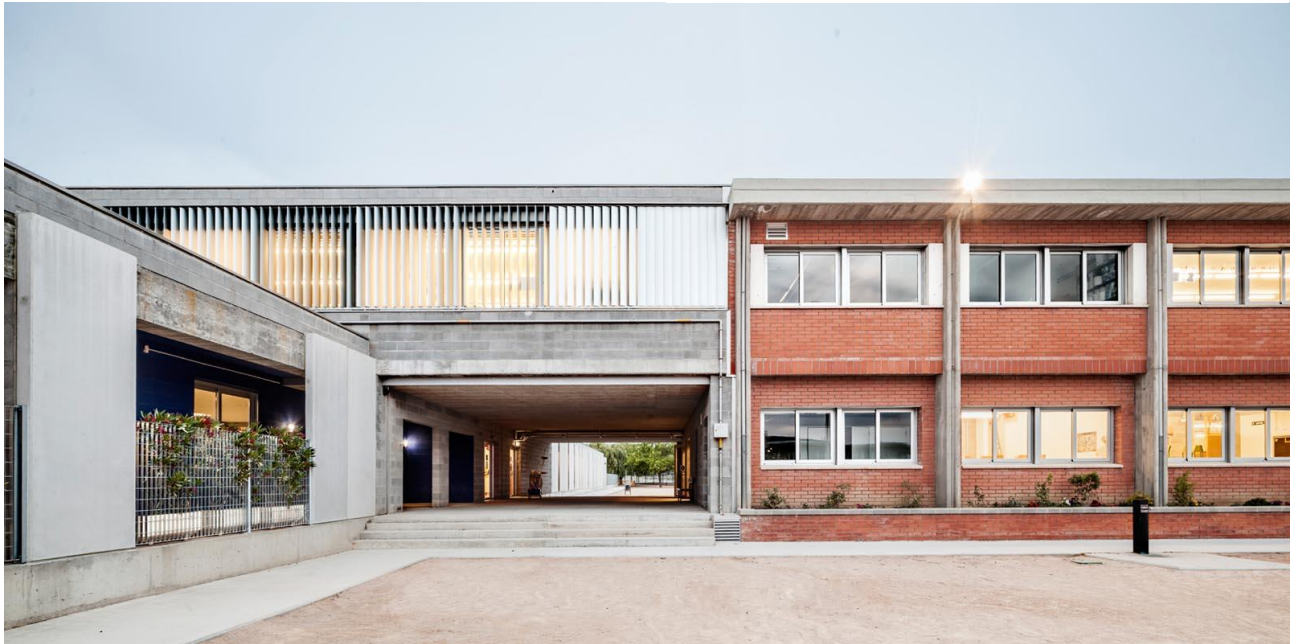
99 · Escuela 215. Vista exterior de la intervención (Harquitectes, 2015)
