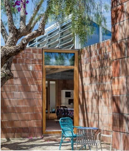
35· Casa 1311. Vista exterior (Harquitectes, 2015)
