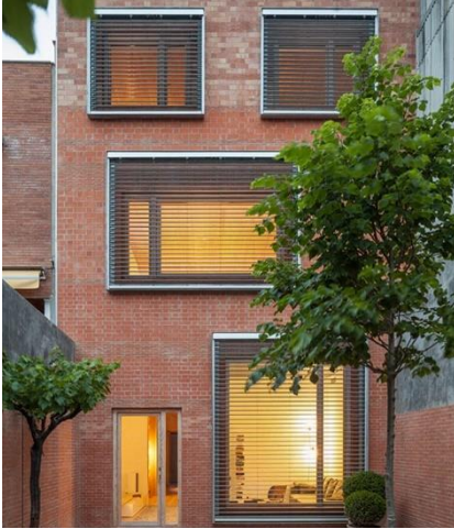
32 · Casa 1014. Fachada del Jardín (Harquitectes, 2015)
