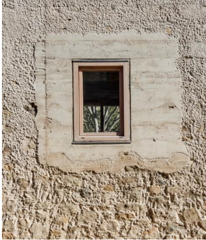
33 · Casa 1413. Muro perimetral (Harquitectes, 2015)
