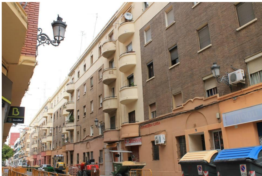
Figura 10. Fotografía edificio Calle Marino Albesa 55. Fuente: Fundación Goerlich
