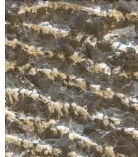
Figura 8: Detalle del punzonado labrando líneas
