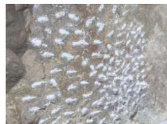
**Figura 6:** Detalle punzonado degradado
