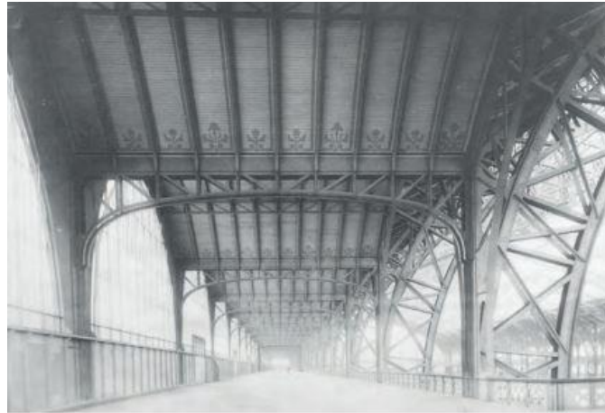
Figura 50: Nave lateral de la Galería de las Máquinas. (Dunlop & Hector, 1999)
