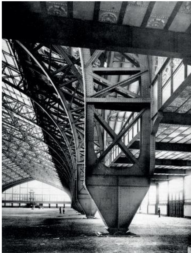
Figura 57: Detalle del apoyo de los arcos, donde se aprecia la materialidad, y el roblonado. (Linares de la Torre, 2018)
