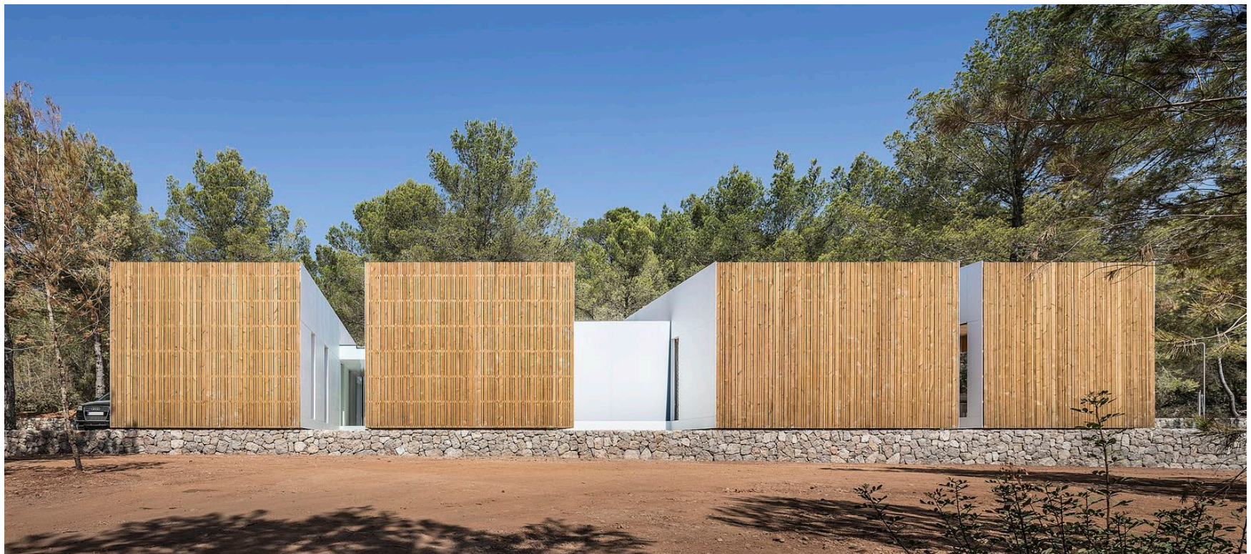
Figura 92 | Vista exterior 1 | Fuente: Marià Castelló en m-ar.net
