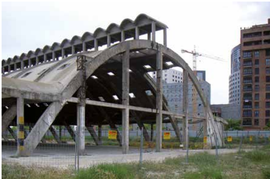
Fig. 15a, b Sopra e sotto Particolari della nave in ce- mento armato della fabbrica S.A. Cros prima dell'interven- to di recupero. Foto: Diana Sánchez Mustieles, < http://patrimonioindustrialarquitectonico.com/portafolio/lugares-visitados/ >.
