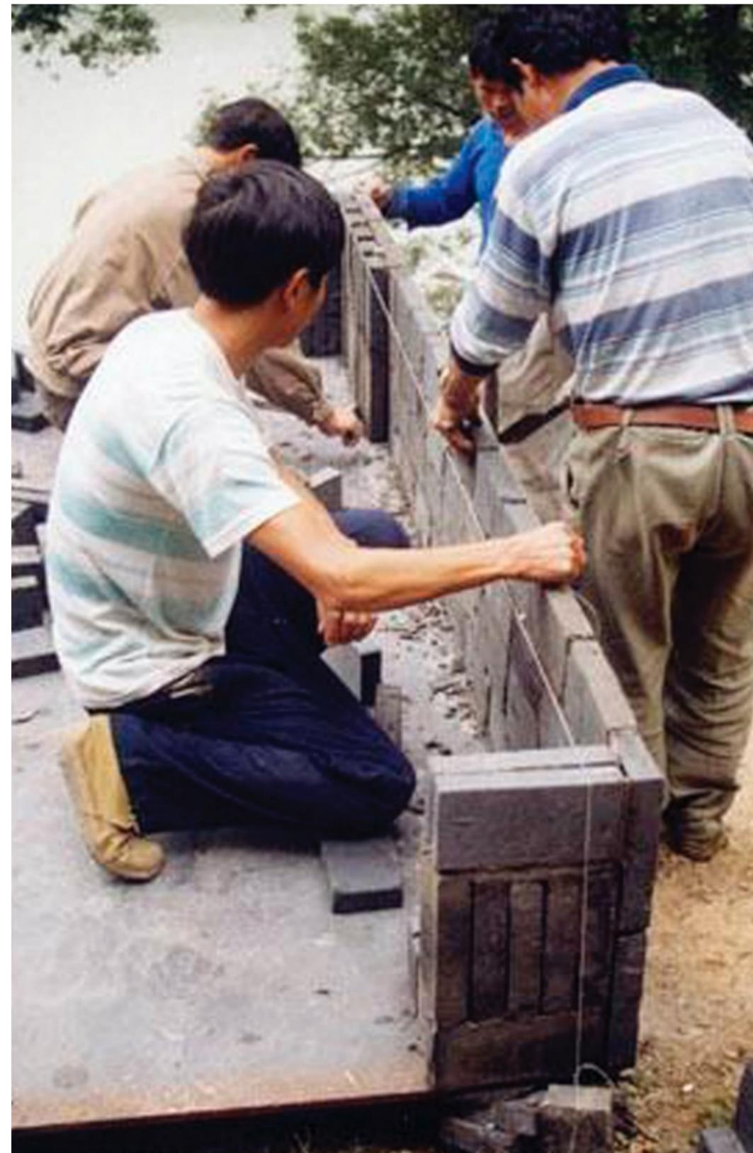
FIG 4. 74. Plantas, alzados, sección, y detalles del edificio; y una imagen del proceso constructivo de la fachada con los ladrillos reciclados. (Imagen extraída en red: lafargeholcim-foundation.org).
