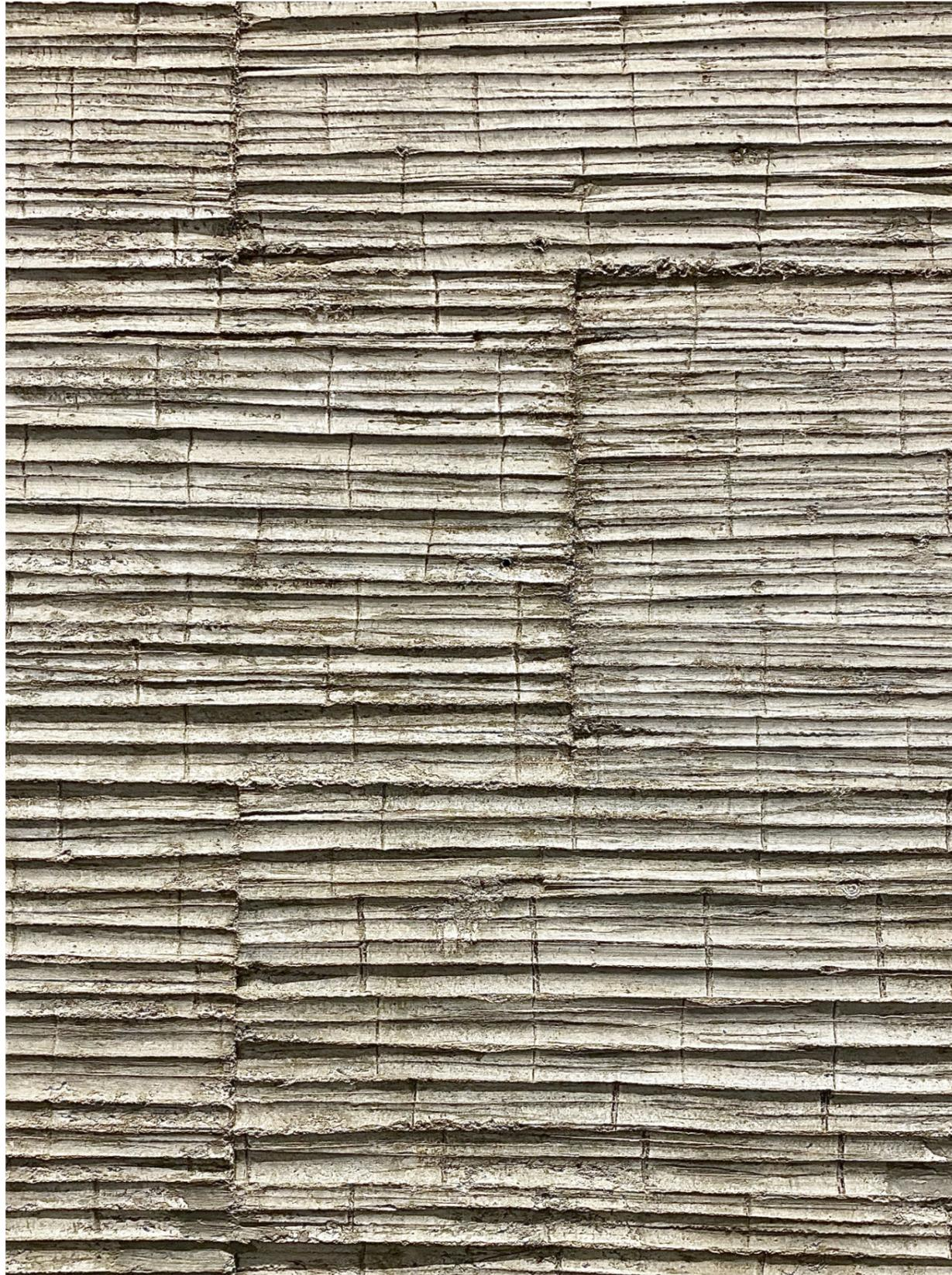
FIG 4. 98. Hormigón visto con la plantilla del bambú. © Gezi Feng, 2020.
