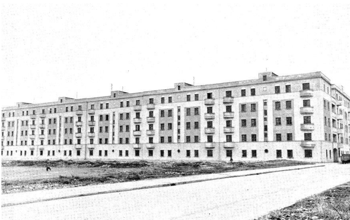
Figura 5. Grupo Residencial Federico Mayo. Fachada
