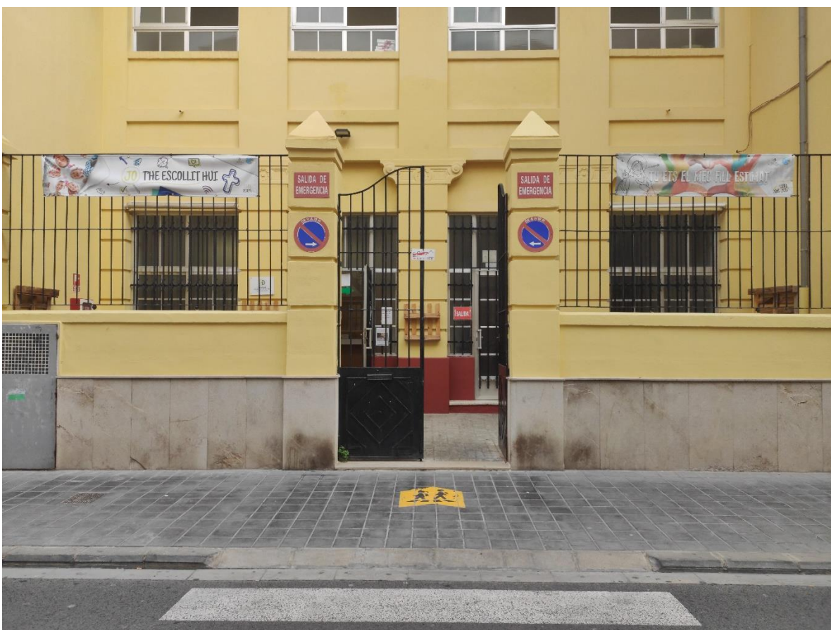
Ilustración 32: Acceso por calle de tráfico rodado
